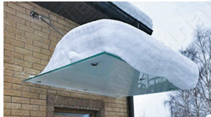
При расчете нагрузки на стеклянные козырьки над входом следует учитывать внезапную мгновенную нагрузку, например, схода с кровли на козырек снежной шапки льда в виде конусных сосулек – так называемый динамический удар. Поэтому, в конструкцию козырька изначально закладывается 300% запаса прочности на точечное воздействие. Добиться такой прочности можно только с применением в конструкции металла и стекла.
