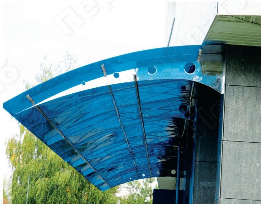
По действующим нормам строительства зданий безопасность на входе должна обеспечиваться козырьками. Козырек должен выдерживать снеговую, ветровую и ударную нагрузку от глыб льда с карниза и т.д. Конструкция козырька, должна обеспечивать безопасность не только двери, но и всего крыльца, отмостки, опалубки перед входом. Также консольные козырьки-навесы, можно использовать над балконом, или для защиты автомобиля на парковке.
