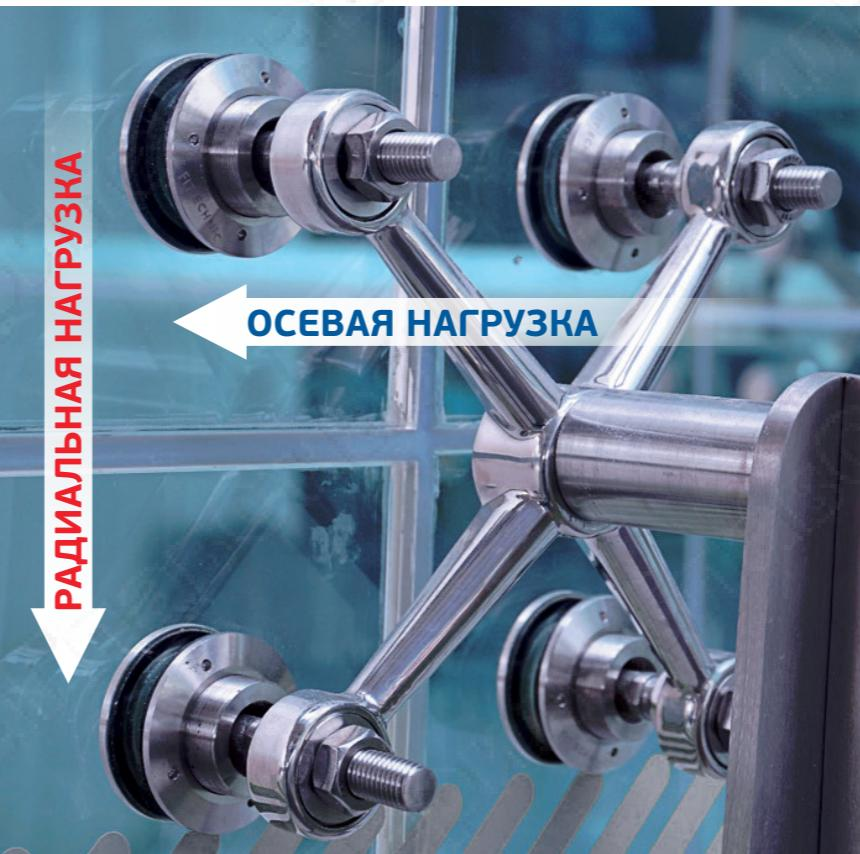
Спайдеры для стекла - это кронштейн для крепления стеклянных полотен, с целью облицовки стен, формирования новых фасадов, горизонтальных навесов, козырьков и стеклянных полов. Основное отличие от других несущих систем – отсутствие несущих перегородок и рам, между полотнами стекла.
