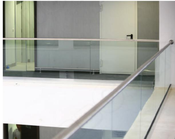
Ограждение со стеклом триплекс 8+8 мм в зажимном алюминиевом профиле k601 и поручнем с пазом диаметром 48,3 мм. Окончание поручня в колонну фланцем k238.
