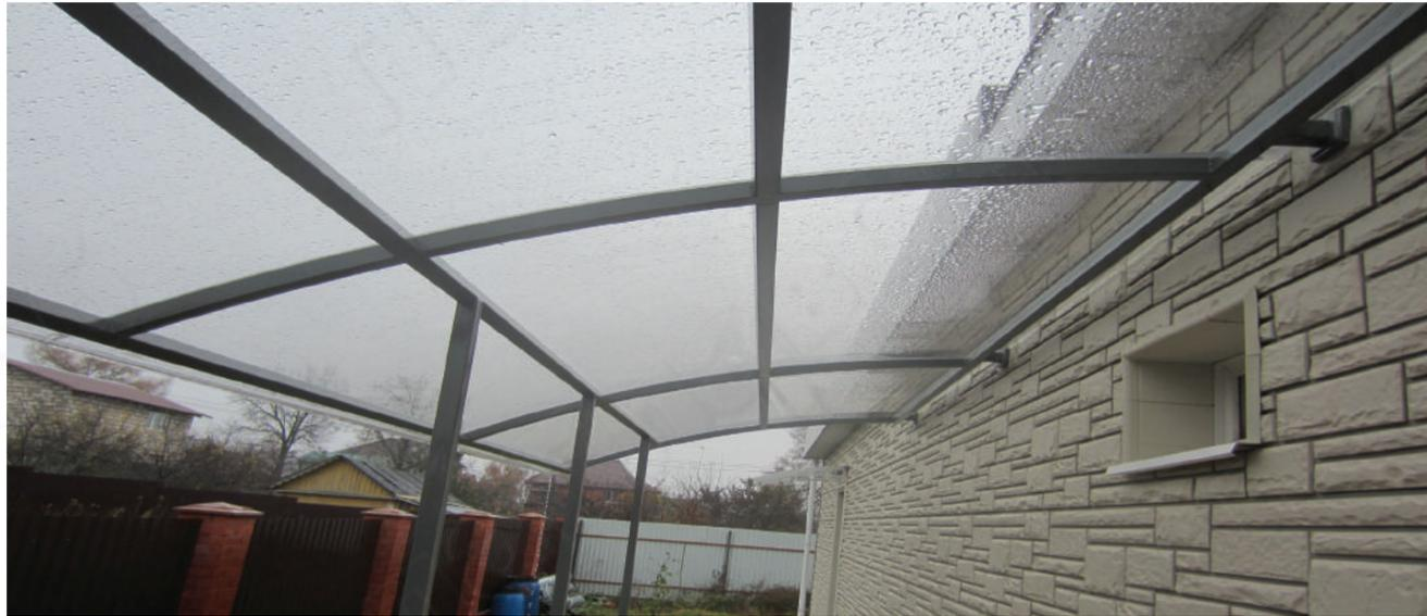
Навес для машины, примыкающий к дому. Каркас из черного металла, накрыт монолитным поликарбонатом толщиной 8 мм. Направляющие навеса прокатаны по радиусу для большей жесткости и схода снега.
