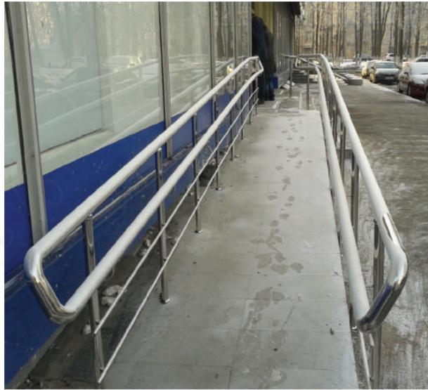
Перила на прямом пандусе при входе в магазин. Верхний поручень установлен сверху стойки на высоте 900 мм, нижний - на высоте относительно стойки на высоте 700 мм.
