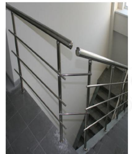
Выход на балкон лестничного марша, без завязки поручня и без завязки ригелей. Две перемычки внахлест для жесткости.
