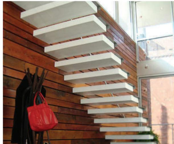
Консольная лестница без ограждений, металлокаркас обшит красными деревянными панелями.
