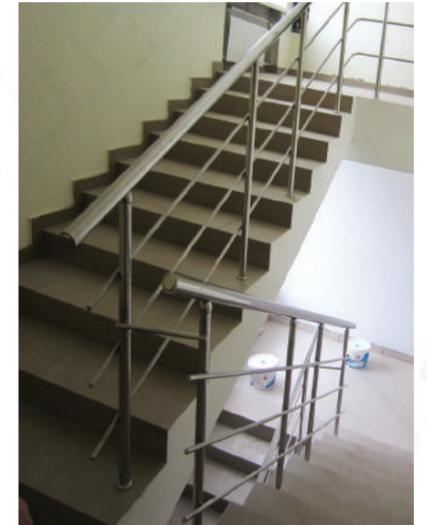
Стандартная лестница, ограждение с тремя ригелями, поручень и ригели развязаны между маршами. Стойки соединены одной перемычкой, выход на балкон завязан.
