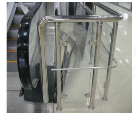
Примыкание к эскалатору. В данном случае бетонная плита подходит к механизму вплотную и крайнюю стойку удалось поставить поближе.
