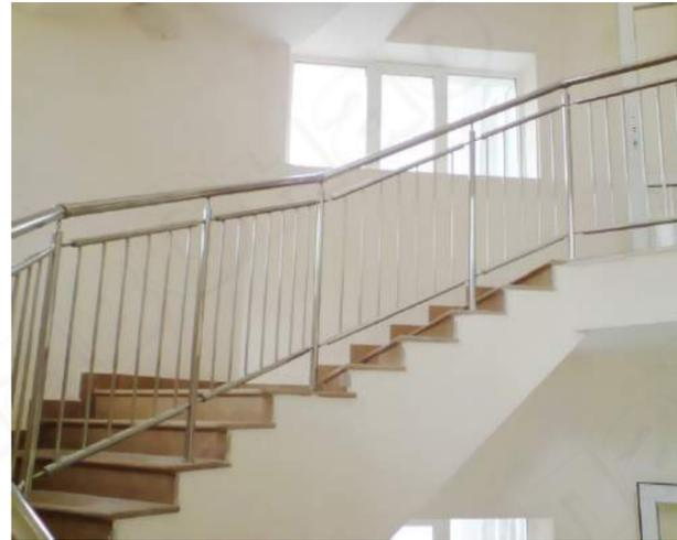
Ограждение в школе для старших классов с вертикальным заполнением, используется труба  $\Phi 25$ мм с перфорацией для горизонтального заполнения и  $\Phi 16$ мм для вертикального.
