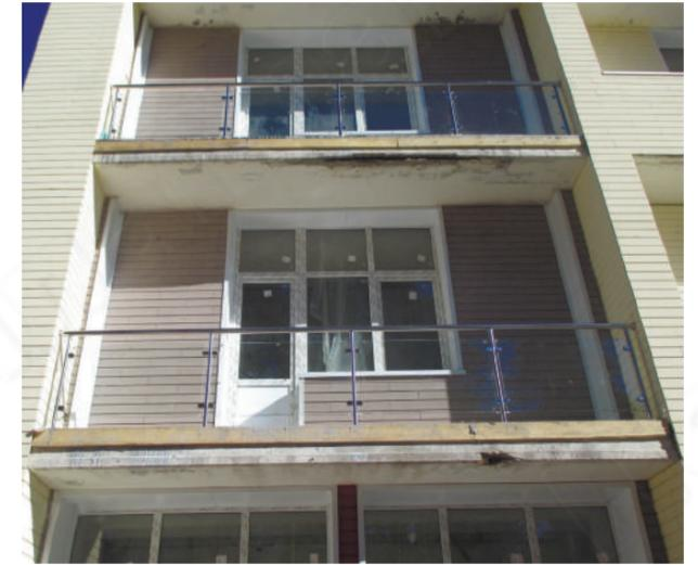
Ограждение балкона жилого дома со стеклом триплекс 4+4 мм. Стекло может крепиться в стену без стоек, но красивее устанавливать стойку вплотную к стене, как на этом проекте.
