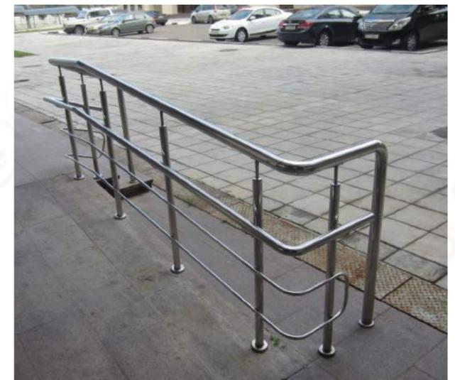
Ограждение входной группы скомбинировано с перилами на небольшом пандусе, уход поручня в пол придает дополнительную жесткость всей конструкции.
