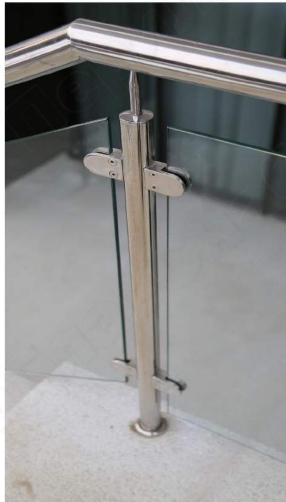
При изготовлении перил и ограждений из нержавеющей стали компания «ПерилаГлавСнаб» использует следующие марки нержавеющей стали: AISI201, AISI201 (PRIMA), AISI304, AISI304L (торговая марка SUPER), AISI316L (торговая марка Ultra).
