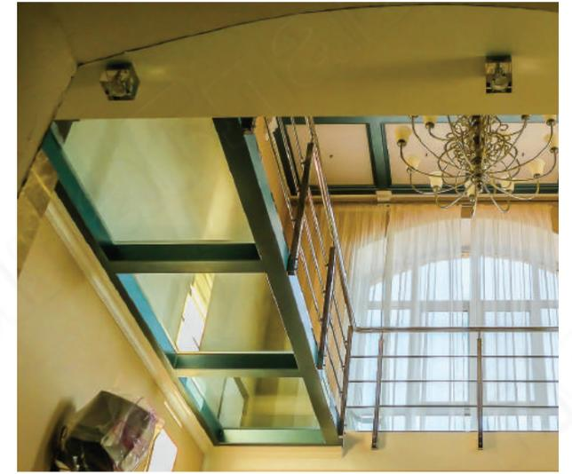
Снизу стеклнного пола проходит массивная подконструкция. При кажущейся хрупкости стеклнные полы очень мощные. Обычно их проектируют с расчетом на нагрузки от 500 кг/кв.м. и выше.
