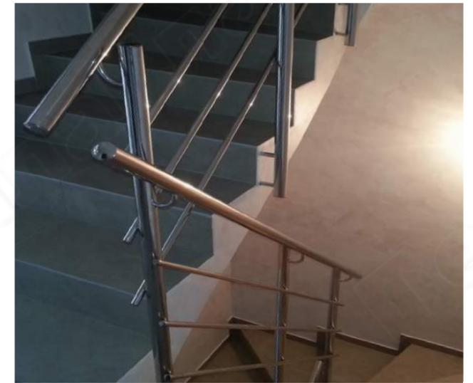
Боковой крепеж трехригельного ограждения в условиях малого просвета между маршами (70 мм). Вынос на прутках возвращает поручень в плоскость марша. Стойки вынесены на 50 мм относительно торца плоскости марша.
