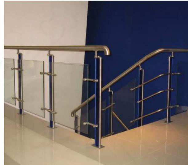
Ограждение со стойками с акриловыми вставками на спайдерных стеклодержателях в темно синем стиле дизайна банка. На поворотах красиво завязан тремя ригелями. Поручень шлифованный на микровыносах.
