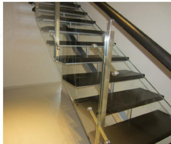
Ограждение на стойках со скрытым боковым крепежом и смыканием стеклянных панелей за стойкой. Стекло крепится на пластинчатых стеклодержателях.
