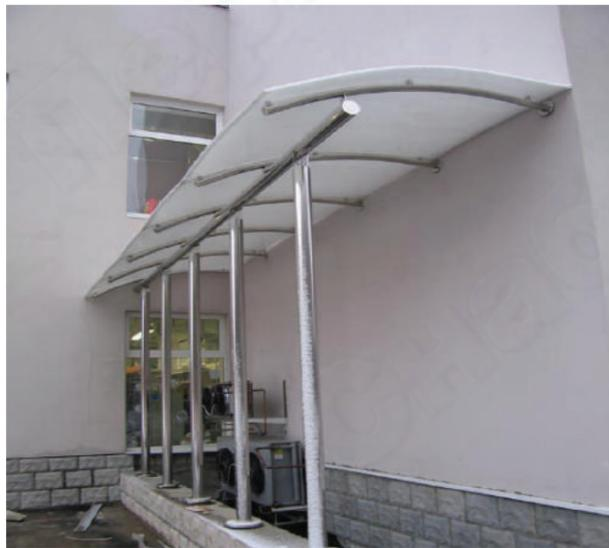
Навес над входом в подвал. Каркас из нержавейки накрыт монолитным поликарбонатом молочного цвета.
