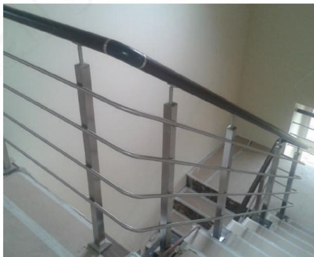
Чистовые полы укрыты картоном до начала монтажа четырехригельного ограждения на квадратных стойках 40 x 40 мм. Крышка k076, наконечник k239. Ригели приварены внахлест со стойкой завязаны между маршей.
