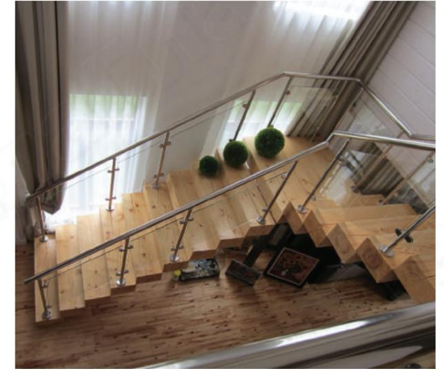
Ограждение со стеклом 8 мм на зажимных стеклодержателях k039, большие крышки k201 прикрывают треханкерные закладные k232.
