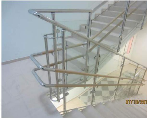
Ограждение в школе с торцевым креплением и большим выносом стоек относительно лестничного марша в целях сохранения ширины лестницы по пожарным нормам. Расстояние между стойками и торцом марша закрыто двумя ригелями.
