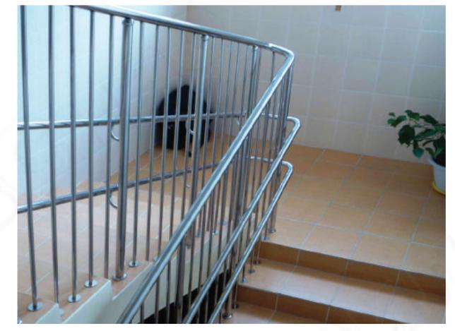
Ригельное ограждение в школе с креплением ригелей вертикально в плитку и большой шайбой-крышечкой. Поручни на высоте 500 мм, 700 мм, 1500 мм, завязаны между маршей.
