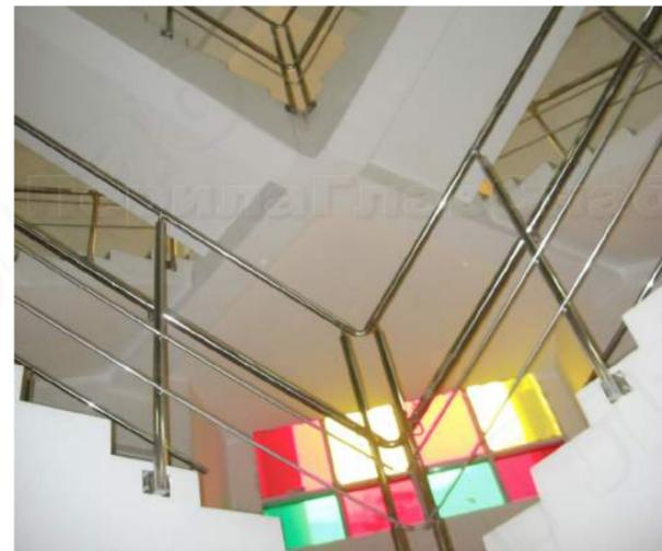
Ограждение колодезной лестницы с боковым креплением, с двумя ригелями д.16 мм, одним поручнем д. 38 мм на выносе 950 мм на выносе и вторым поручнем д.38 мм на высоте 1200мм.
