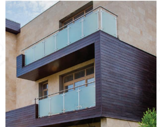
Ограждение балконов в таунхаусе. Обеспечена приватная зона за счет тонировки стекла химическим травлением
