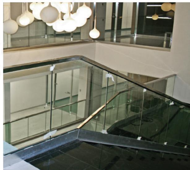
Ограждение в офисе без стоек с триплексом 8+8 мм, с прямоугольным поручнем с пазом k824 из полированной нержавеющей стали.
