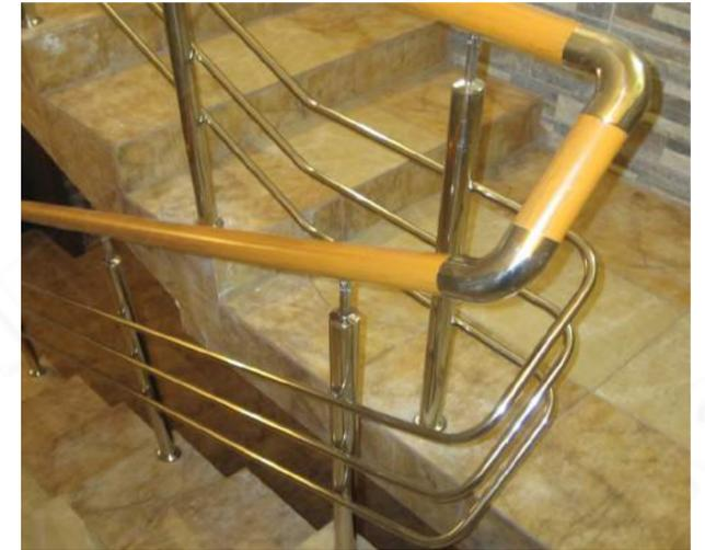
Ограждение с забегом площадки на верхний марш на 900 мм и выбегом нижнего марша на 2 ступени. Завязка круглого пластикового поручня и ригелей на повороте нержавеющей наискосок для компенсации перепада высоты в 2 ступени.
