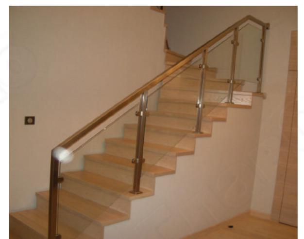
Ограждение из профиля 40x40 мм, с круглыми зажимными стеклодержателями k001. Окончание поручня в стену закрыто крышкой k076.
