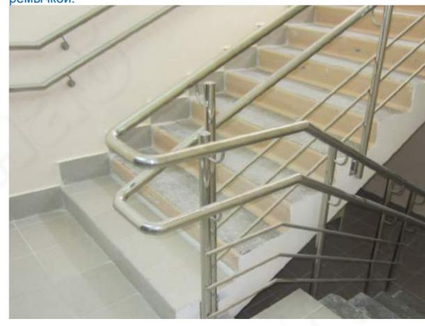
Ограждение в частной больнице с двумя поручнями д.38 мм на выносе. Стойки крепятся сбоку на пластине k056. На стене выполнен дублирующий пристенный поручень для облегчения подъема в обе стороны.
