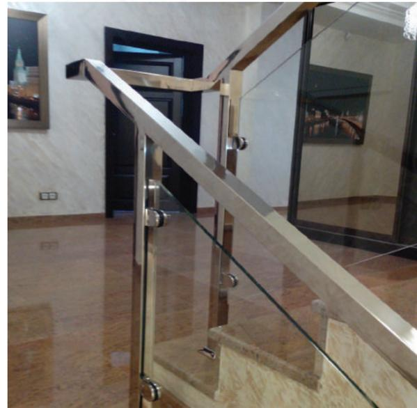
Ограждения лестницы на квадратных стойках 40x40 мм и квадратным поручнем 40x40 мм, со сложной завязкой на повороте, без наконечников.
