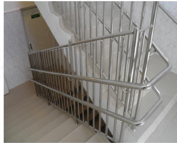
Ограждение в школе с маленьким межмаршевым расстоянием. Выполнено с тремя поручнями д.38 мм на высоте 500 мм, 900 мм и 1500 мм. Вертикальные ригели опираются на нижнюю балку д.25 с помощью деталей k212. Стойки завязаны между собой одной перемычкой.
