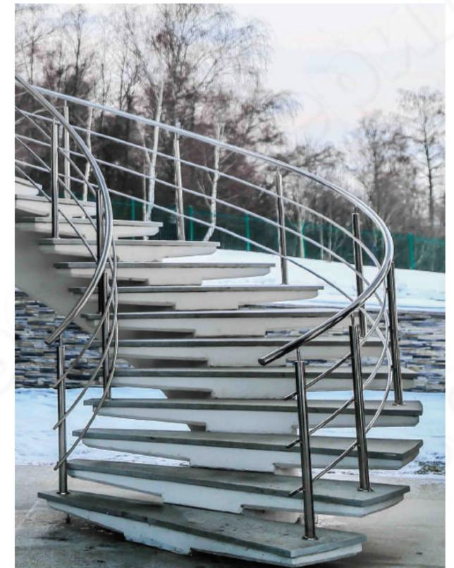
Уличное трехригельное ограждение забежной лестницы. Стойки диаметром 50 мм, наконечник k042.
