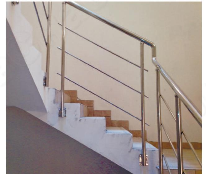
Иллюстрация стандартной проблемы при боковом крепеже: образование выхода на вертикаль из-за геометрии колодезных лестниц. Единственная возможность сохранить одинаковую высоту на соседних маршах - скомпенсировать перепад в 1 высоту ступени выходом поручня на вертикаль.
