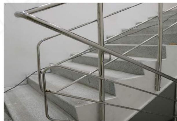
Боковой крепеж трехригельного ограждения в условиях отсутствия просвета между маршами. Поручень на наконечнике сфера k016 сверху и на выносе, крепится к той же стойке чуть ниже по пути на нижний марш. Ригели завязаны травмобезопасно и крепятся к одной и той же стойке с разных сторон.
