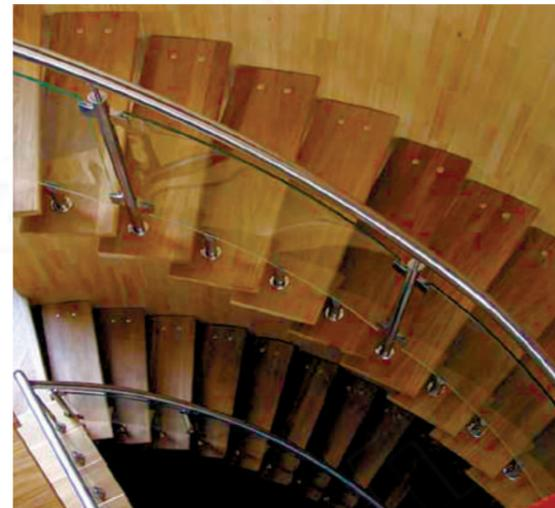
Ограждение забежной лестницы с прямым крепежом, через три ступени на четвертую. Для образования фермы стекло дополнительно связано с каждой ступенью.
