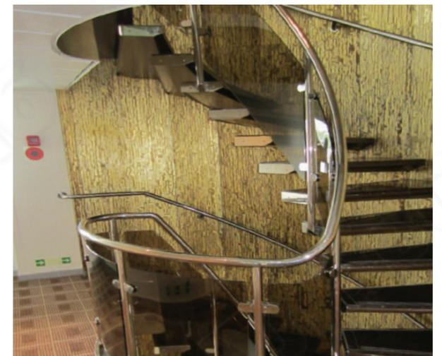
Стеклопанельное ограждение с монолитным гнутым поликарбонатом на зажимных стеклодержателях, стойки без наконечников.
