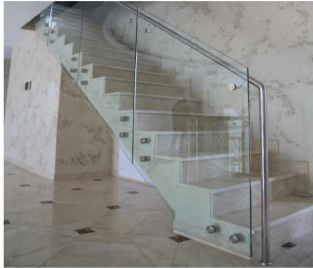
Ограждение без стоек с открытыми обработанными кромками стекла. Круглый поручень из нержавеющей стали Ф50мм уходит в пол дополнительно укрепляя конструкцию.
