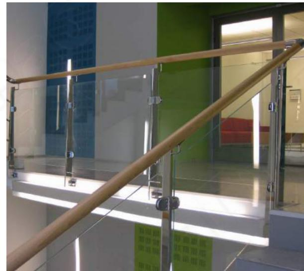
Ограждение с боковым крепежом, стойками из полированной нержавеющей стали и зажимными стеклодержателями. Стекло триплекс 4+4 мм, деревянный поручень бук на выносе.
