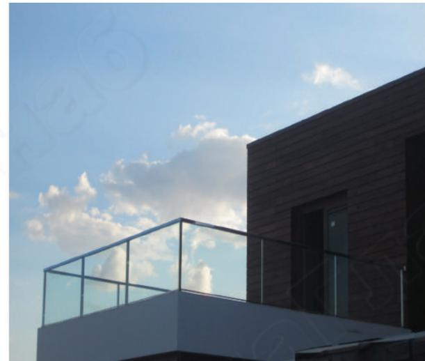
Ограждение балкона со стеклом триплекс 8+8 мм, без стоек с поручнем д. 48.3 мм.
