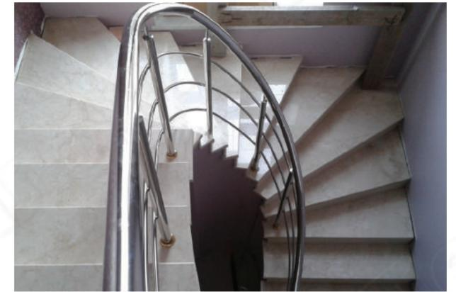
Ограждение забежной лестницы с крышками под золото, 3 ригеля. Наконечник k034, стойки д. 38 мм.
