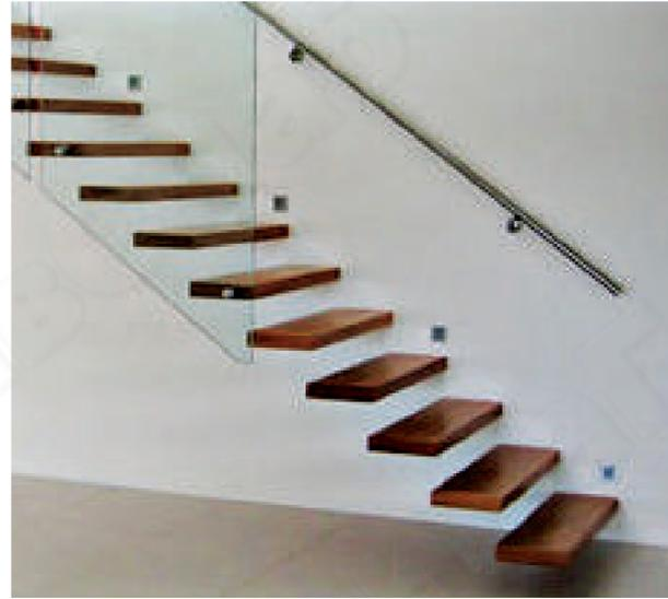
Консольная лестница в стиле минимализм с подсветкой и дублирующим пристенным поручнем. Ограждение без стоек из стекла толщиной 15 мм, закреплено в проеме потолка и в ступень.
