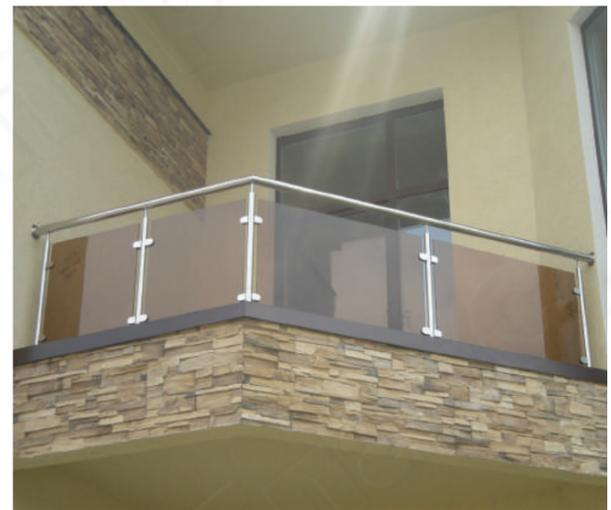
Ограждение балкона на зажимных стеклодержателях со стеклом 8 мм тонированным в массе под цвет "бронза".
