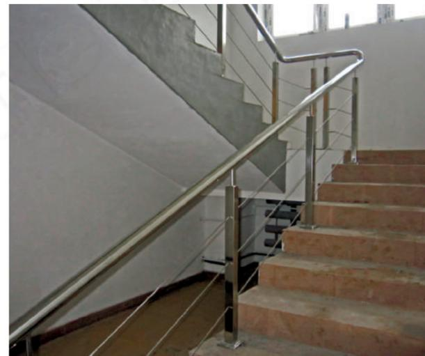
Ограждения из полированной нержавеющей стали с квадратными стойками 40x40 мм и завязкой на поворотах тремя тросами.
