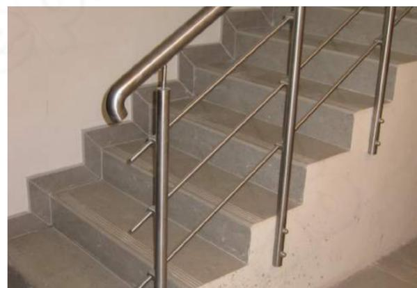
Простой боковой крепеж ограждения на узкой лестнице. Стойки крепятся на шпильках, 3 ригеля крепятся на ригеледержателях. Наконечник k006, круглый поручень заканчивается красивым оконечным отводом k020.
