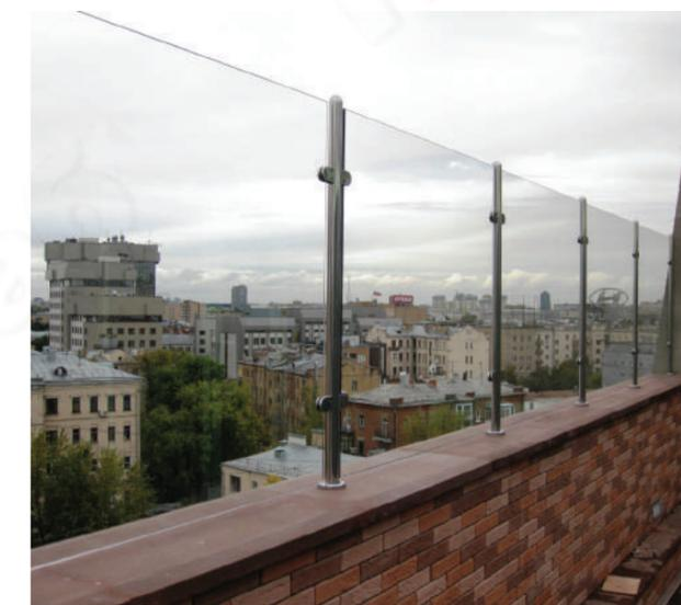
Ветрозащитное ограждение балкона с креплением сверху в парапетную крышку. Стойки круглые д.42 мм. Стеклодержатели литые k001. Гидроизоляция произведена специалистами компании.
