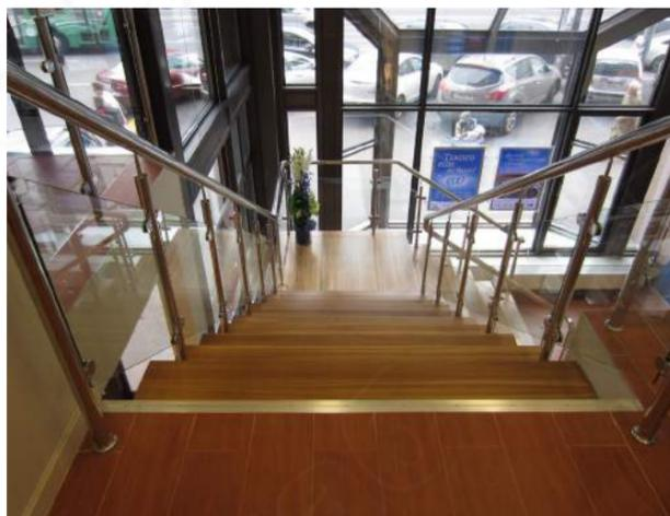
Ограждение со стеклом 8 мм с минимальным заполнением просвета между стойками стеклянным полотном. Левая линия выполняет функцию ограждения панорамного окна.
