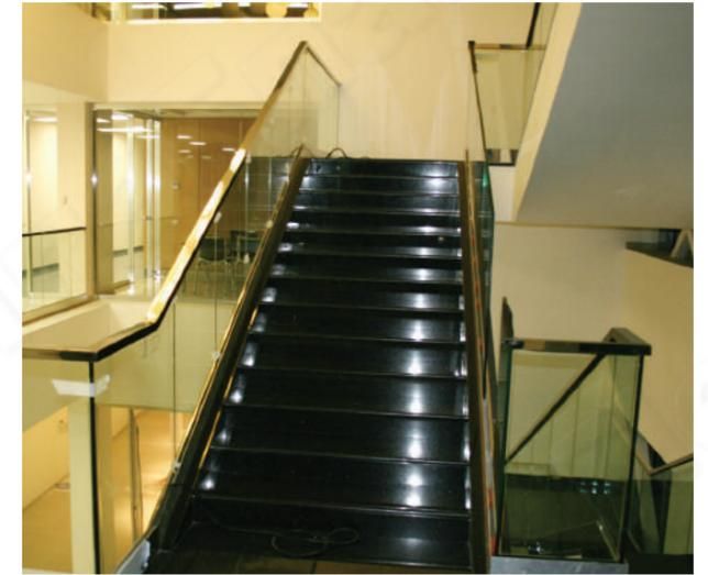
Ограждение в гостинице с полированным прямоугольным поручнем с пазом 40x60 и накладками из полированной нержавеющей стали внизу профиля.
