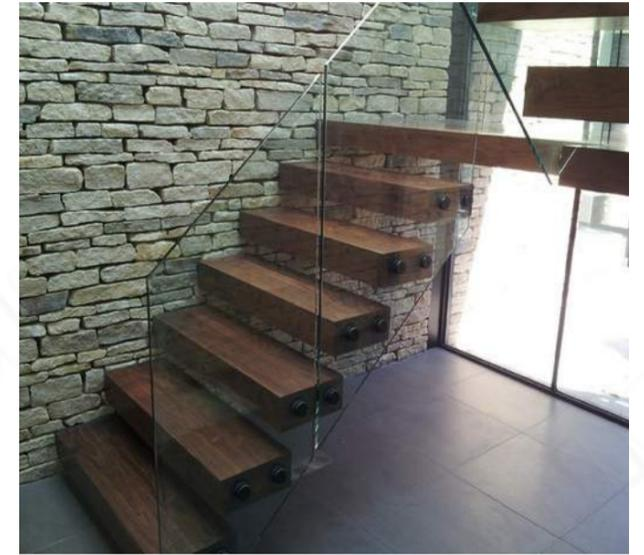
Ограждение без стоек с закаленным стеклом 15 мм без поручня, по 2 крепления стекла в каждую ступень надежно фиксируют стекло ограждений.
