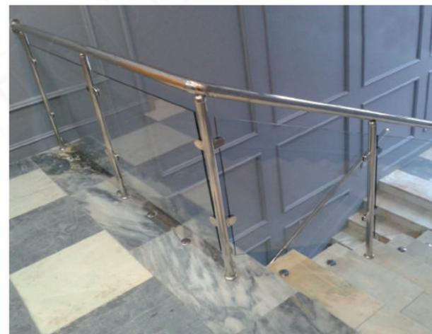
Реконструкция ВУЗа: демонтированы стойки в каждую ступень, старые отверстия закрыты заглушками. Одна стойка на углу с наконечником сфера.
