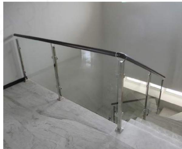
Ограждения лестницы на квадратных стойках 40x40 мм, деревянный поручень с пазом установлен сверху на стекло и непрерывен на повороте.
