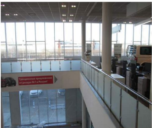
Ограждение высокого второго этажа в автомобильном ТЦ. Длинные прямые участки ограждений имеют идеальную прямолинейную геометрию.
