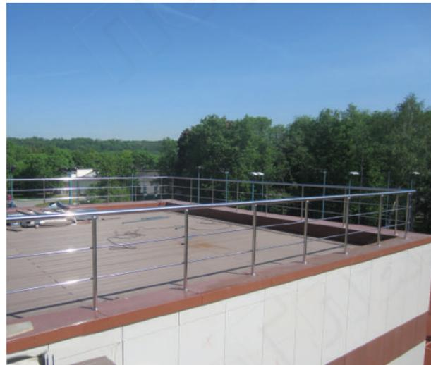
Самое простое ограждение обслуживаемой кровли в фитнес-центре: круглые стойки д.38 мм, 2 ригеля д.16 мм, наконечник стойки сфера k017, малый низ k015.
