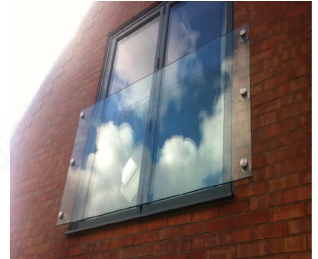
Ограждение французского балкона с креплением сбоку на точечных держателях. Без поручня, кромки стекла открыты.
