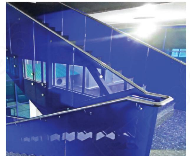
Ограждение в фирменном стиле из тонированного в массу синего стекла с нержавеющей полированным поручнем на выносах.
