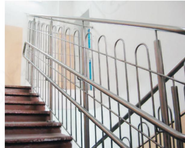
Самый бюджетный вариант детских ограждений с установкой стоек сверху в ступень. Горизонтальные направляющие из трубы  $\Phi 16$ мм, вертикальное заполнение - согнутая труба  $\Phi 16$ мм, приваренная внахлест с внутренней стороны марша.
