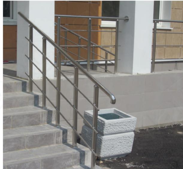
Ограждение входа в поликлинику. Стойки установлены в каждую ступень по просьбе заказчика, окончание поручня отвод k020.
