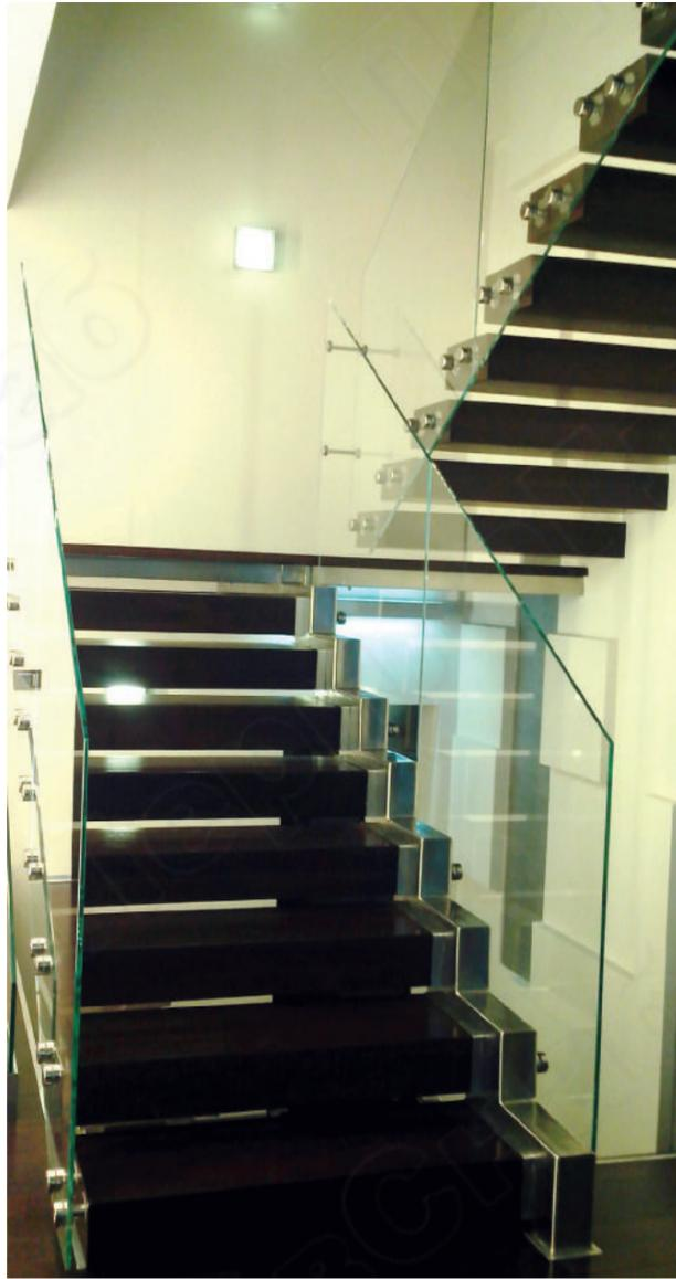
Ограждение без поручня со стеклом 12 мм, с боковым крепежом k277. Перемычки между маршами придают дополнительную жесткость.
