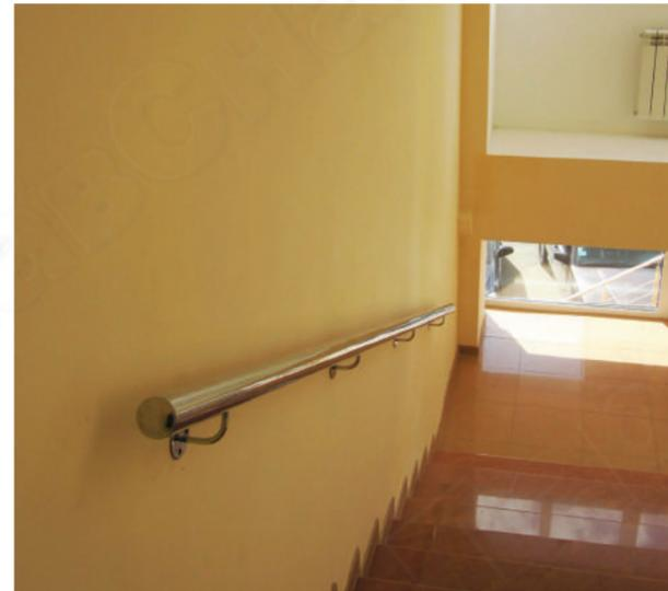
Классический простой пристенник. Диаметр поручня 50 мм, вынос 55 мм для обеспечения 25 мм зазора для свободного прохождения руки между поручнем и стеной. Крепление поручня снизу для удобного скольжения руки.
