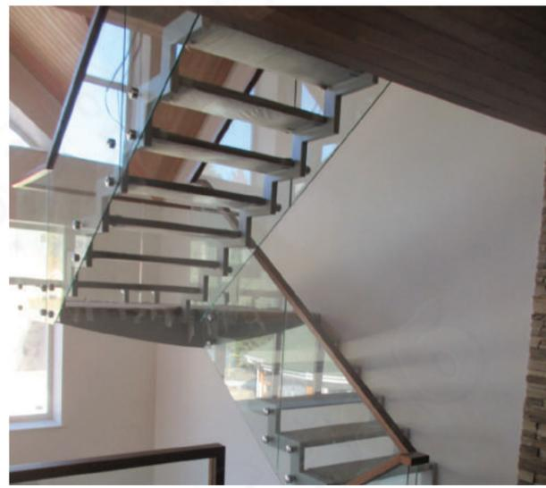
Лестница на двух металлических косоурах и площадке с опорой на стену. Ступени дуб 40 мм. Ограждение без стоек на точечных крепежах k277. Поручень дуб 40 x 80 мм с пазом завязан повторяя грани стекла.
