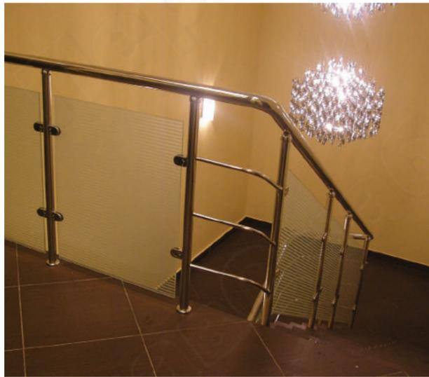
Стекло с матовой декоративной пленкой в полосочку. На углу завязка 3 ригеля диаметром 16 мм. Наконечник стойки сфера k017, крепление стойки сверху в ступень с малой крышкой k035.
