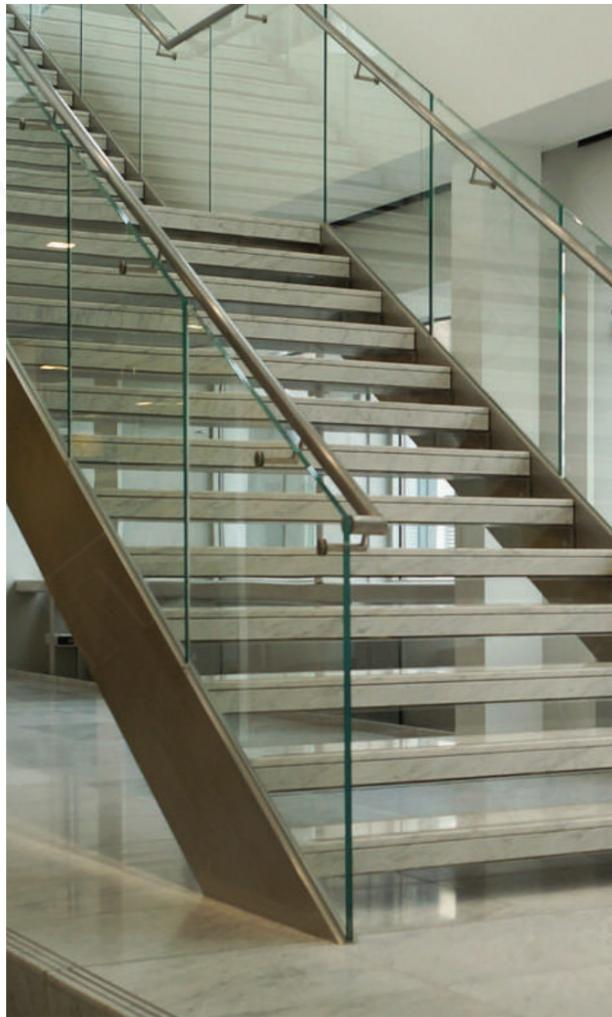
Ограждение без стоек с поручнем на выносе k241, с креплением в металлический косоур минимальной толщины.
