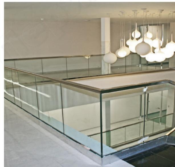
Ограждение в офисе без стоек с триплексом 8+8 мм, с прямоугольным поручнем с пазом k824 из полированной нержавеющей стали. Такое же ограждение установлено на лестничном марше с креплением профиля сверху в парапет.
