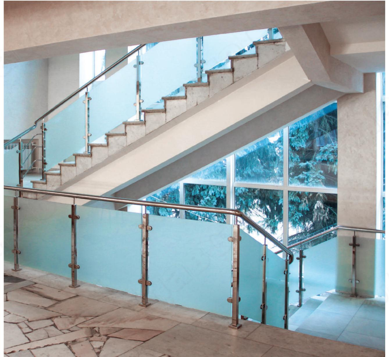
Ограждение колодезной лестницы из полированной нержавеющей стали на квадратных стойках 40x40 мм с наконечниками k239, крышками k076, штампованными стеклодержателями k039, со стеклом триплекс 4+4 мм с матовой пленкой. Поручень 50 мм завязан на повороте одной стойкой. На следующем марше поручень завязан «с подскоком». Просвет закрыт тремя ригелями д.16 мм.
