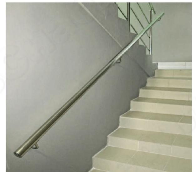
Бюджетный вариант выполнения спуска в подвал. Пристенник не завязан с основным ограждением марша. Для жесткости установлен с одной стороны на крайнюю стойку лестничного ограждения.
