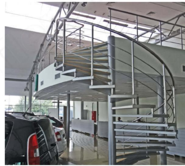
Винтовая лестница в автосалоне. Изготовлена из черного металла, на центральном столбе. Ступени слэбды из полированного гранита с наклееными яркими противоскользящими лентами на грани.
