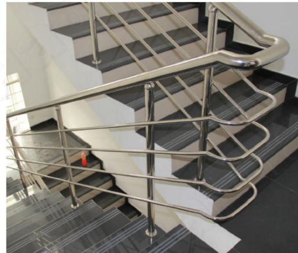
Ограждение лестницы, когда площадка набегае на оба марша сразу на глубину 200 мм, выход на горизонт этих ригелей и поручня на те же 200 мм для того, чтобы сохранить одинаковую общую высоту на соседних маршах. Наконечник сфера.
