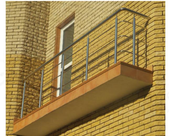
Недорогой вариант ограждения балкона. Трехригельное ограждение из нержавеющей стали, крепление сверху в бетонную плиту, ригель приварен внахлест на круглую стойку д. 38 мм, наконечник k006.
