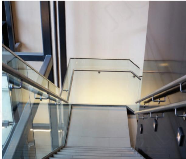
Ограждение без стоек с поручнем для детей на высоте 500 мм и поручнем для взрослых на высоте 900 мм. Комбинация дневного света, подсветки и глянцевых поверхностей заставляет свет струиться по всем плоскостям.
