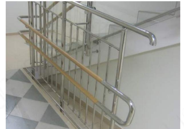
Нижний поручень детских ограждений завязан элементом из нержавеющей стали k051, разработанным специально для подобного вида ограждений, верхний поручень оканчивается отводом k067, чтобы никто не зацепился за выступающую часть поручня.
