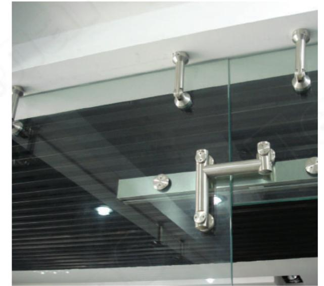
Фурнитура, используемая для цельностеклянных перегородок, представлена не только в серии классика в виде зажимных профилей и коннекторов. Цельностеклянные перегородки часто устанавливаются на точечной фурнитуре из нержавеющей стали.
