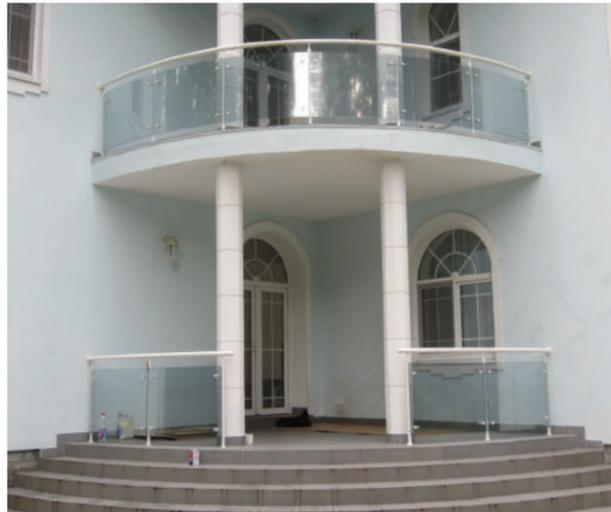
Ограждение балкона на круглых стойках со спайдерными стеклодержателями. Стекло 8 мм гнутое по радиусу тонировано серо-голубой пленкой в цвет фасада.
