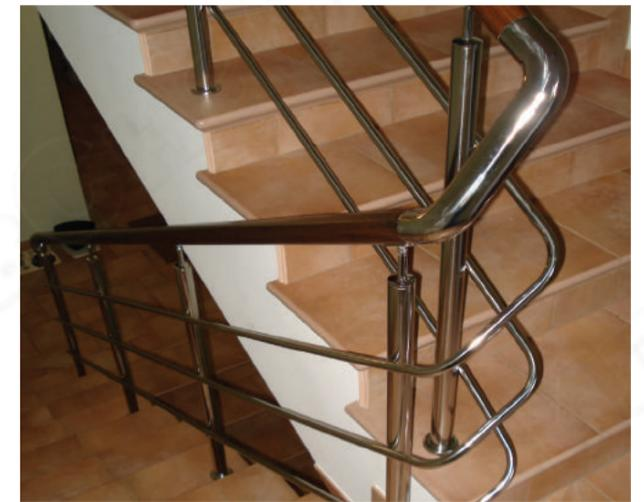
"Кошмар монтажника": завязка деревянного поручня нержавеющей трубой на узком марше с двумя забежными ступенями наискосок для сохранения одинаковой высоты на обоих маршах.
