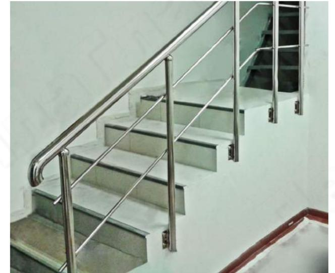
Комплектация эконом: боковой крепеж круглых стоек k056, 2 ригеля диаметром 16 мм внахлест на стойке. Наконечник k017. Окончание поручня отвод с плоской заглушкой k067. Крепление поручня через фланец k022.
