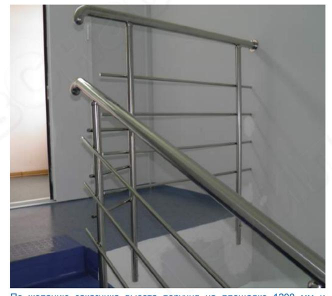
По желанию заказчика высота поручня на площадке 1200 мм и 4 ригеля, несмотря на то, что высота поручня на марше 950 мм и там всего три ригеля. Ригели и поручень на повороте не завязаны, перемычки соединяют стойки для жесткости.
