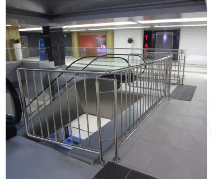
Ограждения с вертикальным заполнением относятся к ограждениям экранного типа и являются более безопасными по сравнению с перилами с ригелями. Конструкции таких ограждений устанавливаются в общественных учреждениях, местах с повышенной проходимостью, где высоковероятно присутствие детей разного возраста. Ограждения с вертикальным заполнением являются более дешевым аналогом ограждений со стеклом, что нашло свое применение в жилых комплексах при установке защитных перил на балконе.
