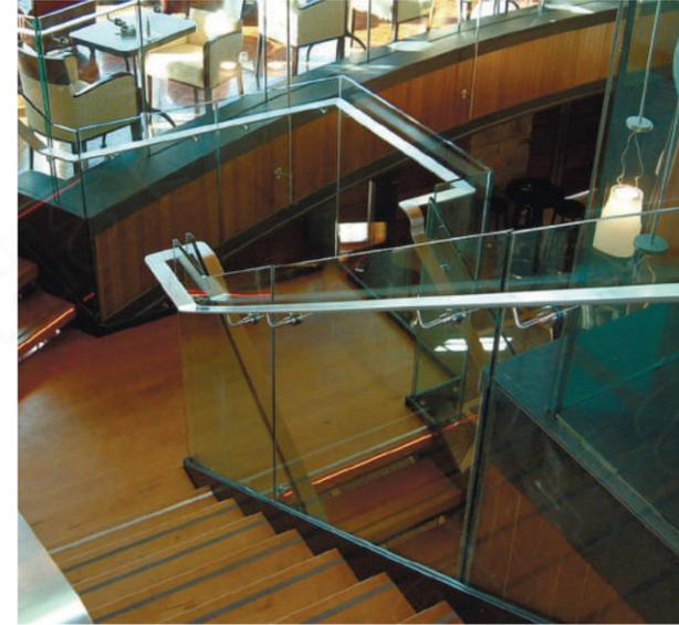
Ограждение ресторана без стоек высотой 1200 мм, без защиты кромок, с ультрапрямоугольным поручнем 10x80 мм, плавно переходящим с марша на марш.
