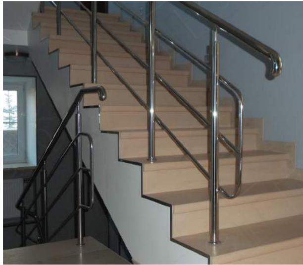
Поручень уменьшенного диаметра (38 мм) для удобного хвата, ригели завязаны травмобезопасно. Наконечник k006, минимальная крышка основания стойки k035. Отвод оконечный с полукруглой заглушкой.
