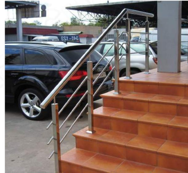
Входная группа с выходом на балкон первого этажа. Стойки 40x40 мм с креплением 3-х ригелей. При выходе на площадку поручень и ригель непрерывны.
