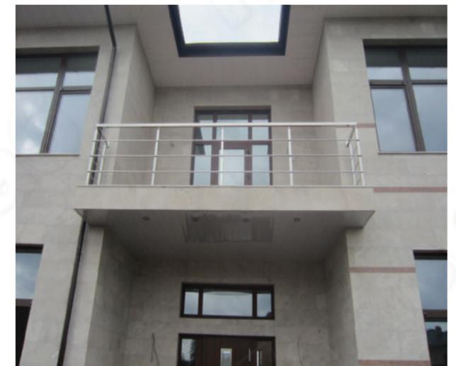
Ограждение балкона на квадратных стойках 40x40 мм с 4 ригелями диаметром 16 мм, приваренными внахлест снаружи балкона, квадратный поручень 40x40 мм. Наконечник k239.
