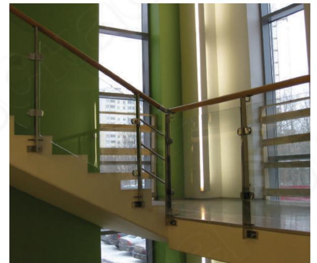
Стеклопанельное ограждение со стойками из полированной нержавеющей стали 10 мм, с минималистичным боковым крепежом и деревянным поручнем, завязанным нержавеющей на поворотах.
