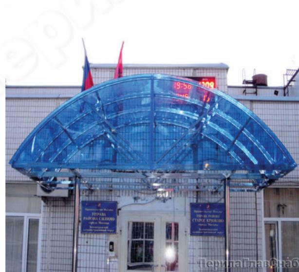
Козырек на нержавеющей металлокаркасе, облицованный голубым монолитным поликарбонатом.
