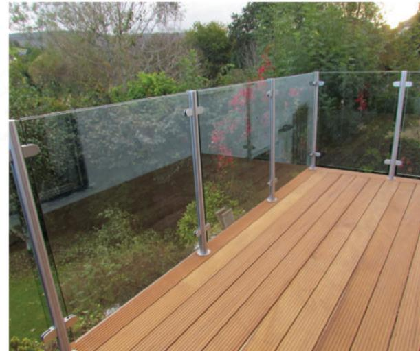
Ограждение балкона с круглыми стойками д.38 мм с креплением через декинг в бетонное основание. Стекло триплекс 4+4 мм крепится на зажимных стеклодержателях.
