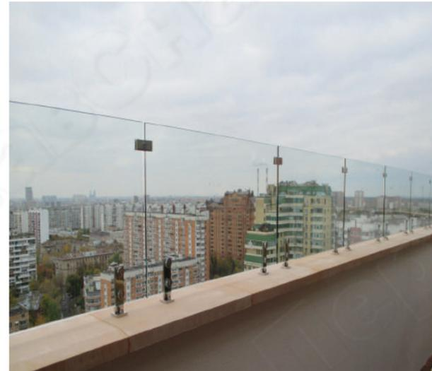
Ветрозащитное ограждение балкона с креплением сверху в parapетную крышку с помощью мини-стоек k276.
