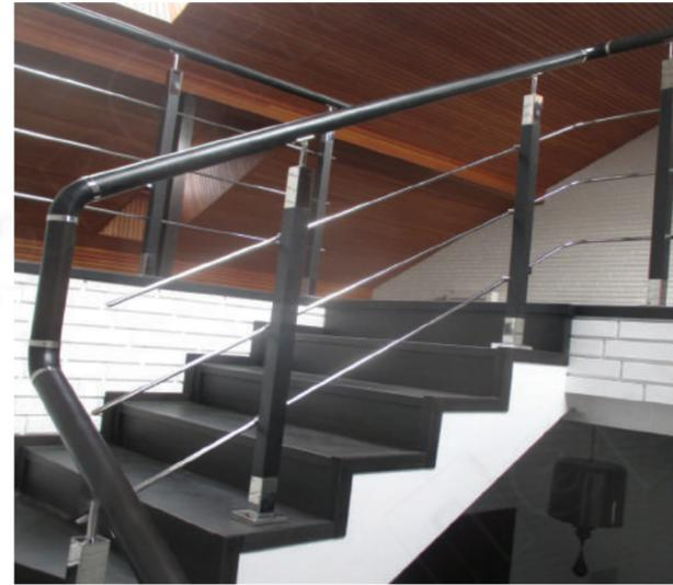
Ограждение лестницы в частном доме: стойки 40\*40мм с дубовыми вставками, поручень и вставки идеально тонированы в цвет ступеней. Поручень имеет сложную геометрию на повороте и соединен элементами из дуба и нержавеющей стали.
