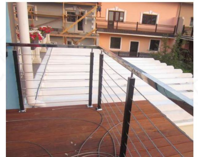
Ограждения балкона из полированной нержавеющей стали с 8 тросиками в морском стиле, стойки покрашены в RAL.
