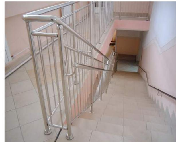
Поручень для самых маленьких установлен на стене на пристенных держателях на высоте 500мм, на основном ограждении верхний поручень на высоте 950мм, нижний 700мм. Вертикальное заполнение соответствует требованиям ГОСТ.
