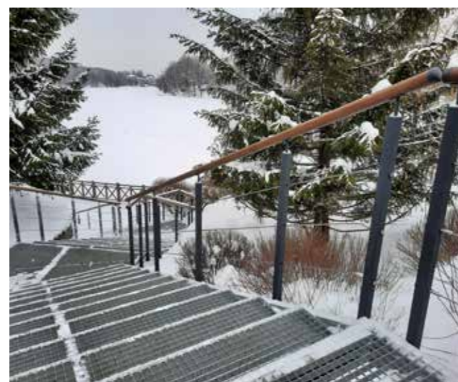
Ограждения с тросами частной территории дома, спуска к водоему и набережной. Поручень круглого сечения из дуба, будет теплым круглый год.
