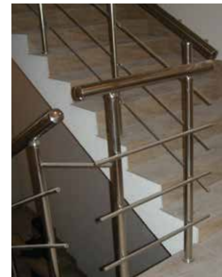
Лестница с большим межмаршевым расстоянием, поручень и ригели развязаны. Для жесткости соседние стойки завязаны одной перемычкой, торцы с заглушками.
