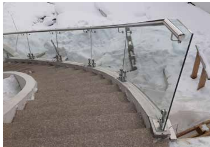
Радиусные уличные стеклянные ограждения на министойках, изготовленных из листа нержавеющей стали с точечными креплениями специально для данного проекта.
