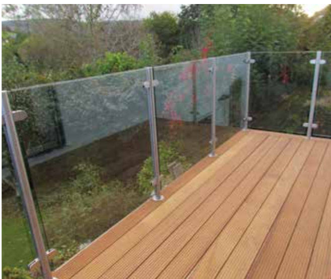
Крепление стоек ограждения через террасную доску к подконструкции, ограждения без поручня для сохранения красивого открывающегося вида.
