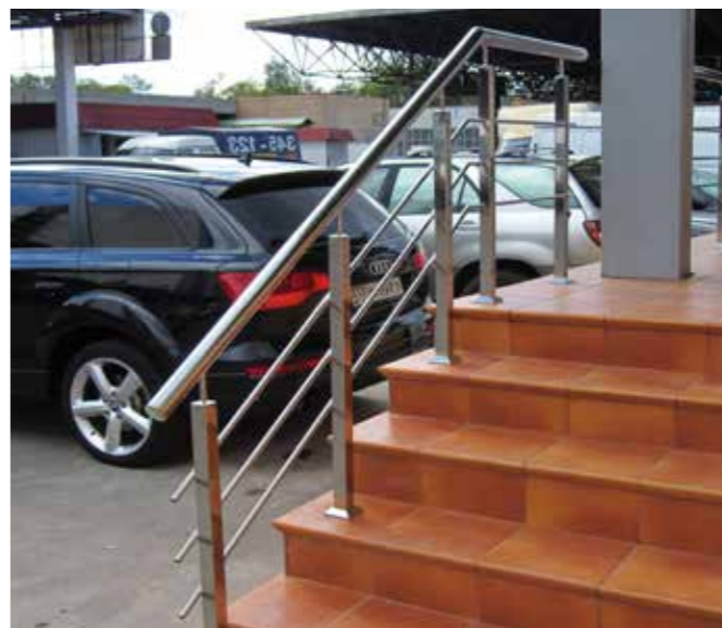
Входная группа с выходом на балкон первого этажа. Стойки 40x40 мм с креплением 3-х ригелей. При выходе на площадку поручень и ригель непрерывны.
