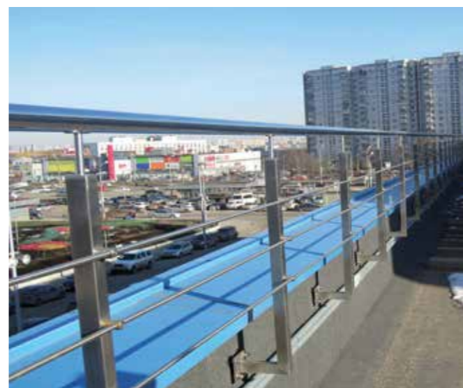
Ограждение кровли торгового центра из шлифованной нержавеющей стали на основе квадратной трубы 40x40 мм и тремя ригелями, закрепленными к стойке через ригеледержатель. Крепеж стойки сбоку в парапет. Наконечник K239.
