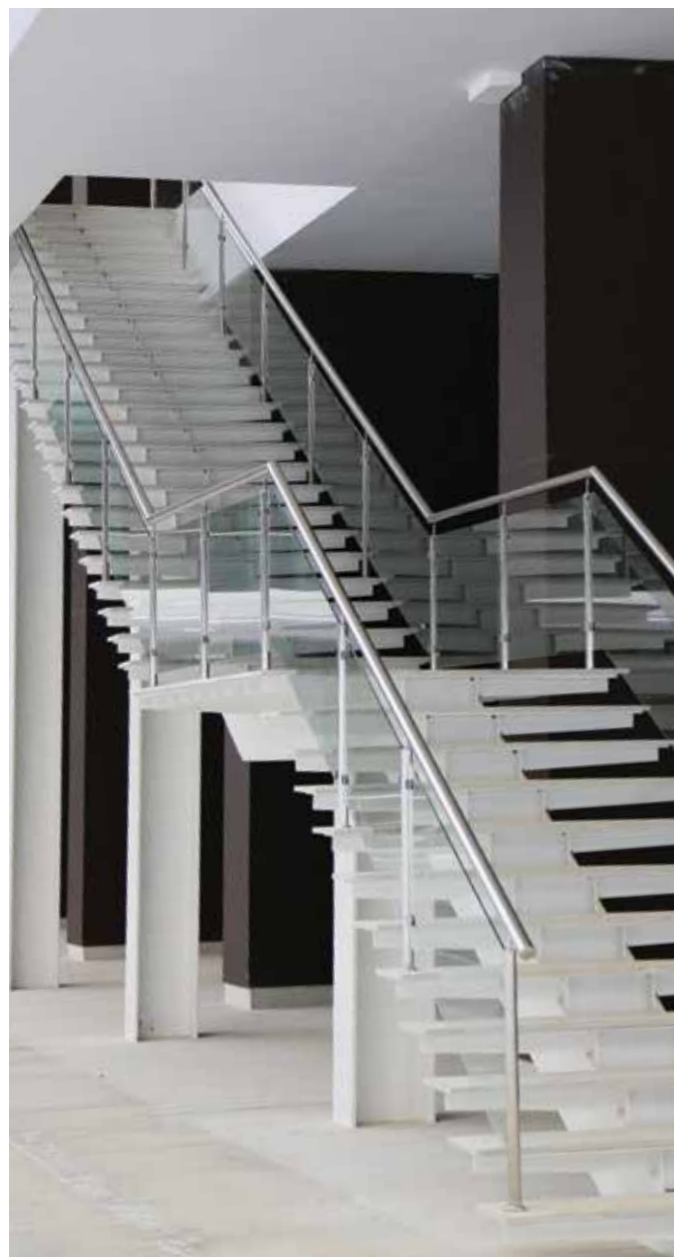
Ограждение с осветленным стеклом 8 мм на зажимных стеклодержателях. Стойки установлены через 3 ступени на 4-ю для ощущения пространства.
