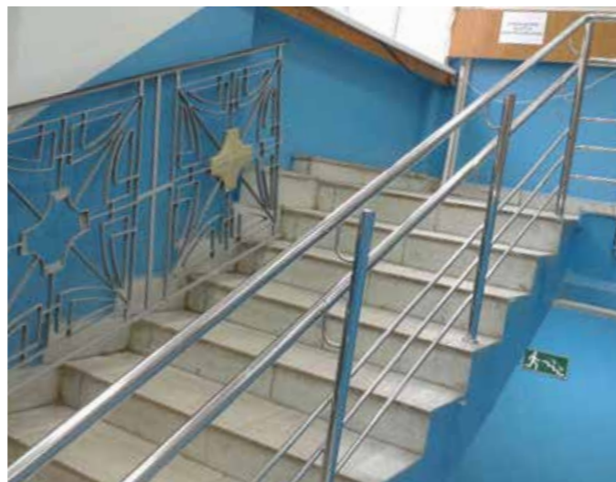
Ограждение в муниципальном учреждении, оборудованное дополнительным поручнем для детей 6-10 лет на высоте 700 мм. Оба поручня выполнены на выносе.
