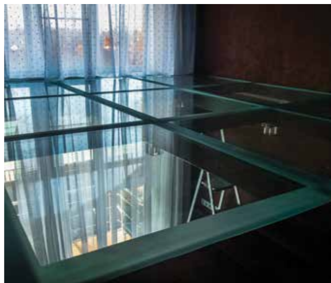
Стекланный пол из осветленного стекл. Когда свет падает снизу вверх такое стекл практически не заметно. Да, ходить страшно :) Но ведь стекланные полы для этого и делают.
