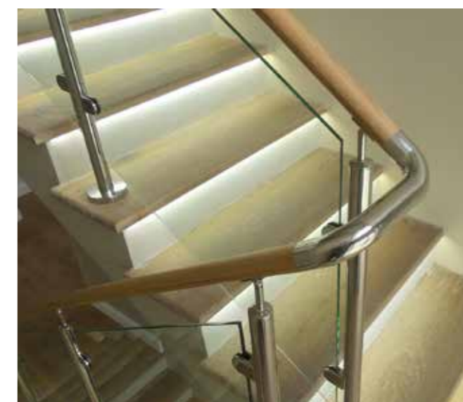
Деревянный поручень цвета вишня непрерывен на поворотах и соединен сегментами из нержавеющей трубы Ф50,8мм.
