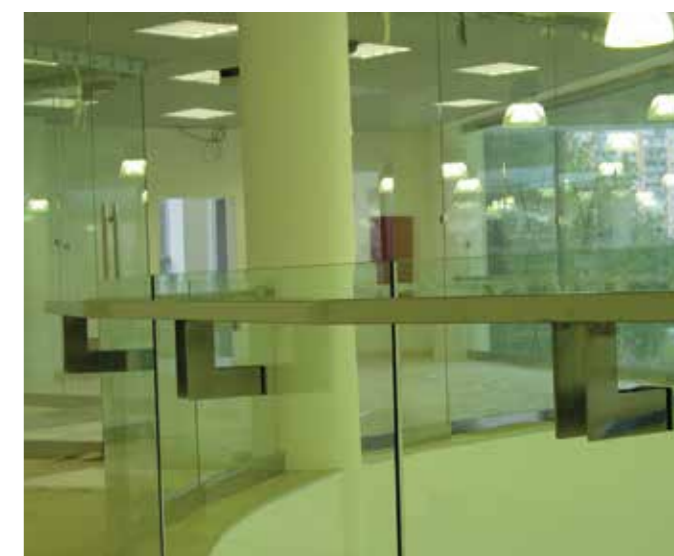
Ограждение атриума с использованием триплекса 8+8 мм, в алюминиевом профиле k601 и с поручнем 40 мм x 80 мм на выносах. Такой поручень можно использовать как полочку для сумочки или подставку под кофе.
