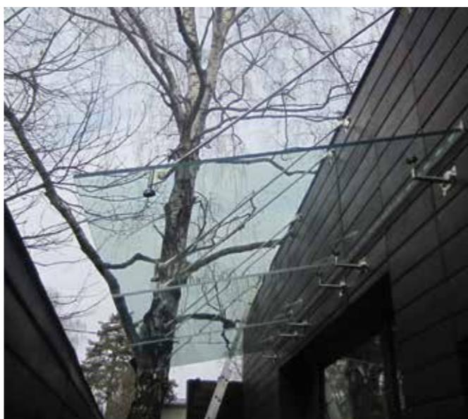
Большой козырек на вантах вынос 1,5 метра, длина 5 метров. Стекло триплекс 8+8 мм. Стекло прозрачное не осветленное.
