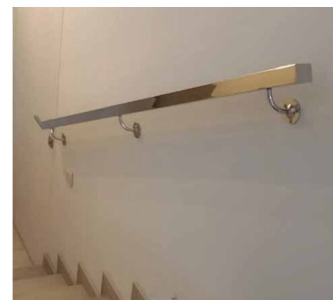
Пристенный поручень из нержавеющей зеркальной трубы 40x40мм, при выходе на площадку не прерывается.
