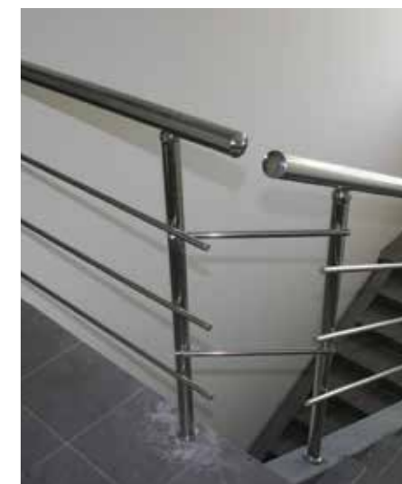
Выход на балкон лестничного марша, без завязки поручня и без завязки ригелей. Две перемычки внахлест для жесткости.
