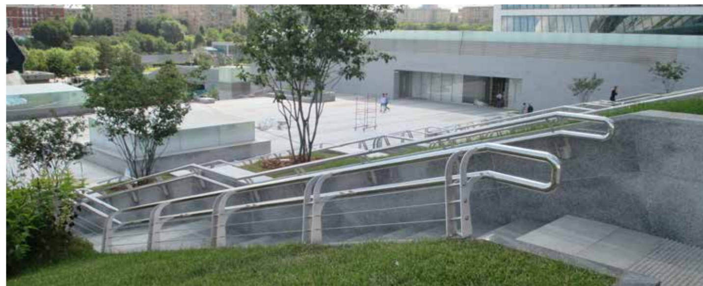
Ограждения общественной зоны с двойными стойками из листа нержавеющей стали и натянутыми между ними тросами. Двойной поручень установлен по обе стороны лестничного марша, что обеспечивает удобство передвижения пешеходов.
