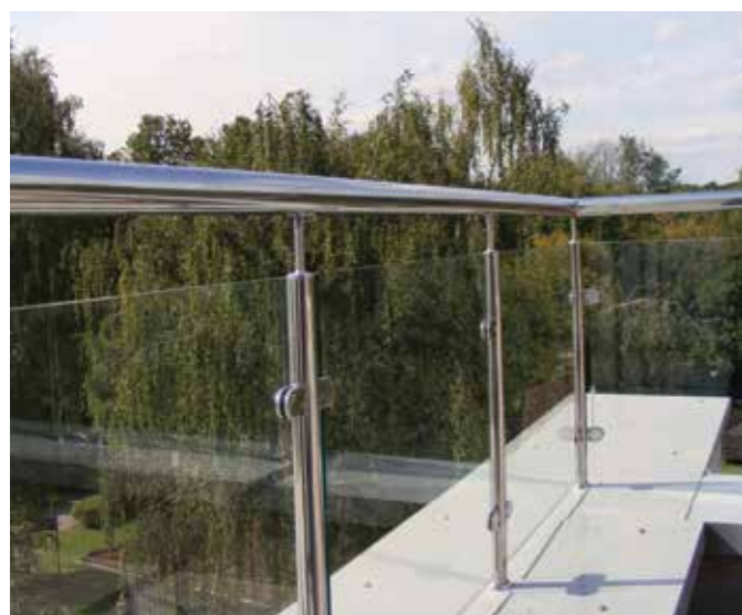
Ограждение балкона с круглыми стойками д.38 мм. Стекло 8 мм крепится на зажимных стеклодержателях.
