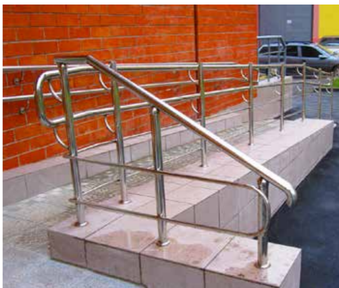
Ограждение парапета входной группы. Поручень повторяет конструкцию ступеней благодаря разной высоте стоек. Ригель непрерывен с ригелем пандуса.
