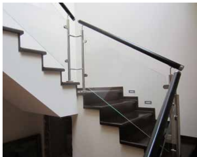
Ограждение без завязки пластикового поручня с двумя перемычками на поворотах. Осветленное стекло дает голубоватый оттенок.
