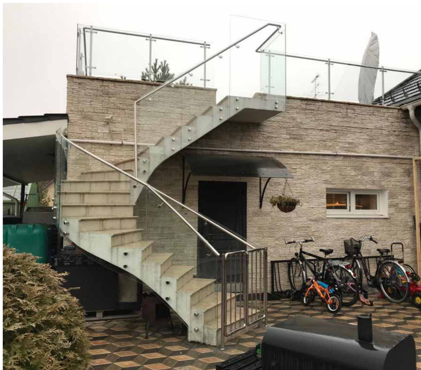
Калитка из нержавеющей стали была дополнительно установлена при входе на забежную уличную лестницу со стеклянными перилами, чтобы обеспечить безопасность передвижения для маленьких детей. Кромки стекол ограждений притуплены, поэтому перила полностью безопасны.
