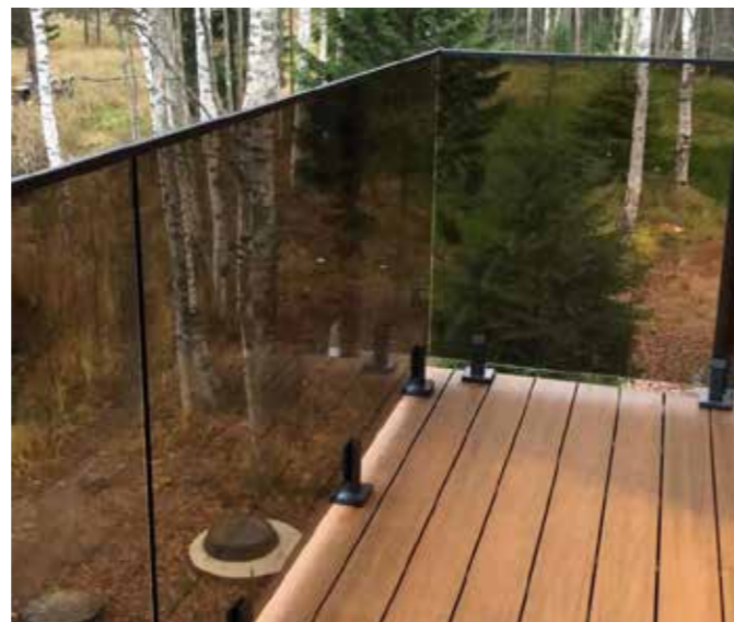
Ограждение из бронзового стекла 12мм на министойках с П-профилем, крашеным в черный цвет по проекту.
