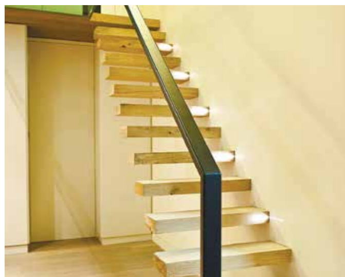
Консольная лестница без ограждений, ступени 100 мм из искусственно состаренного, текстурированного дуба. Поручень металлический, облицован деревом с вставками из черной кожи. Ступени оборудованы подсветкой.
