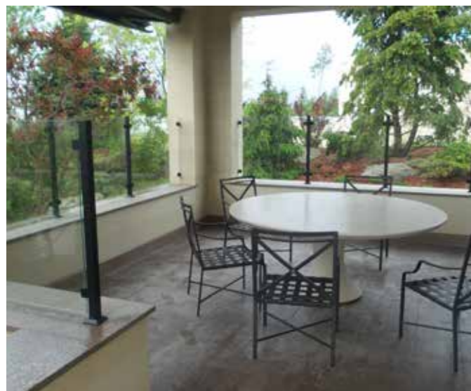
Ветрозащитное ограждение террасы с осветленным стеклом со стойками 40x40мм, квадратными стеклодержателями без поручня. Вся фурнитура покрашена в черный цвет идеально сочетается с уличной мебелью.
