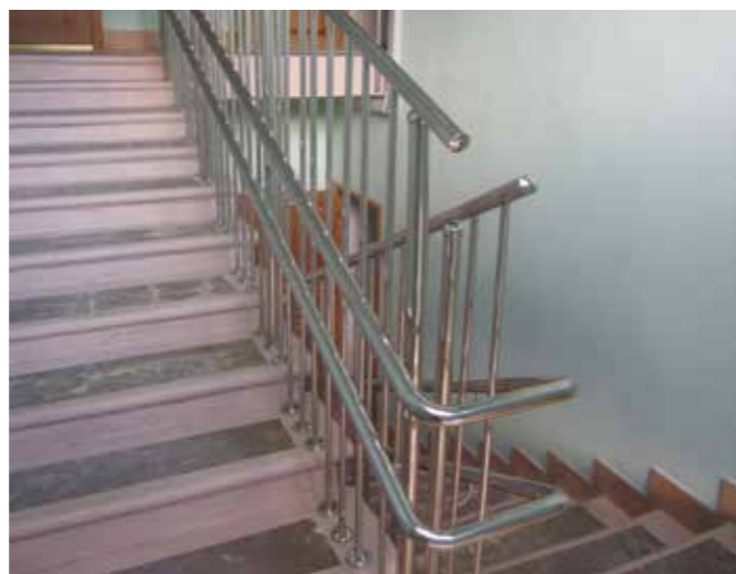
Ограждение с ригелями в школе. Выполнено с тремя поручнями д.38 мм на высоте 500 мм, 700 мм и 1500 мм по ГОСТу. Поручни завязаны между маршами. Верхний поручень не завязан для экономии. Каждый вертикальный ригель забурен в лестницу.
