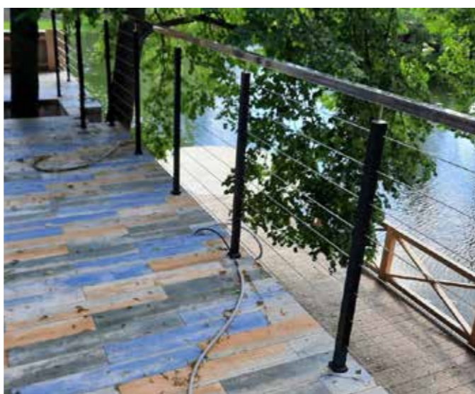
Современное ограждение террасы со стойками 40x40мм из нержавеющей стали, окрашенной в черный цвет и 8-ю тросиками.
