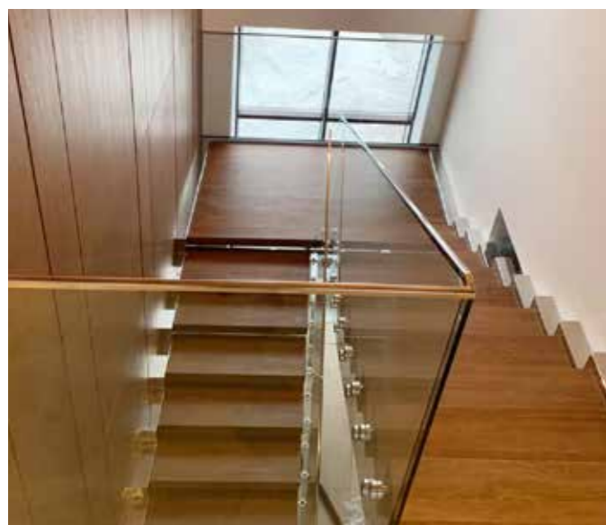
Ограждение из стекла с торцевым креплением и П-образным профилем вместо поручня, установленным сверху на стекло.
