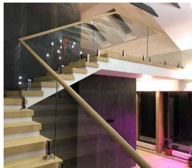
Несущее стекло с креплением на министойках из нержавеющей стали, поручень из бука круглого сечения в тон ступеней лестницы непрерывен на поворотах марша.
