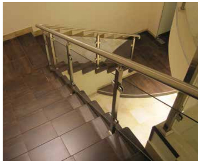
Ограждение из шлифованной нержавеющей стали на квадратных стойках, со стеклянным наполнением между стойками.
