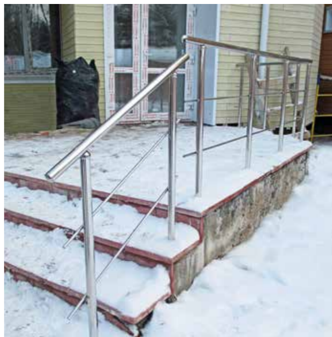
Ограждение входной группы эконом вариант с двумя ригелями. При выходе на площадку поручень и ригель прерывается.
