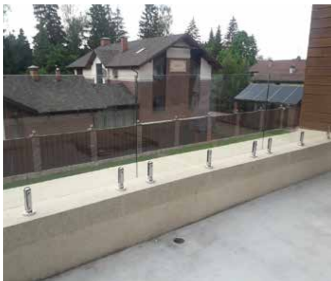
Стеклянные ограждения террасы на нержавеющих круглых министойках, стекло серое в массе закаленное 12мм.
