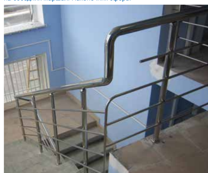
Завязка поручня и ригелей, когда марш забегает на площадку на 2 ступени. Поручень выходит на вертикаль на высоту этих двух ступеней, ригели завязаны оригинально, чтобы компенсировать не кратный высоте ступени шаг.
