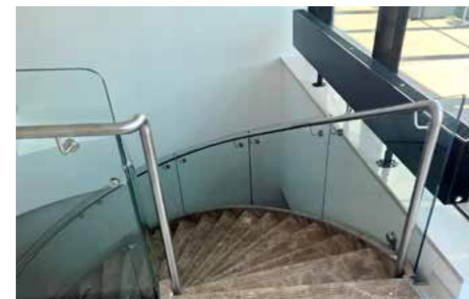
Ограждение забежной лестницы с несущими моллированными стеклами. Углы стекол имеют большой радиус скругления для большей безопасности эксплуатации.
