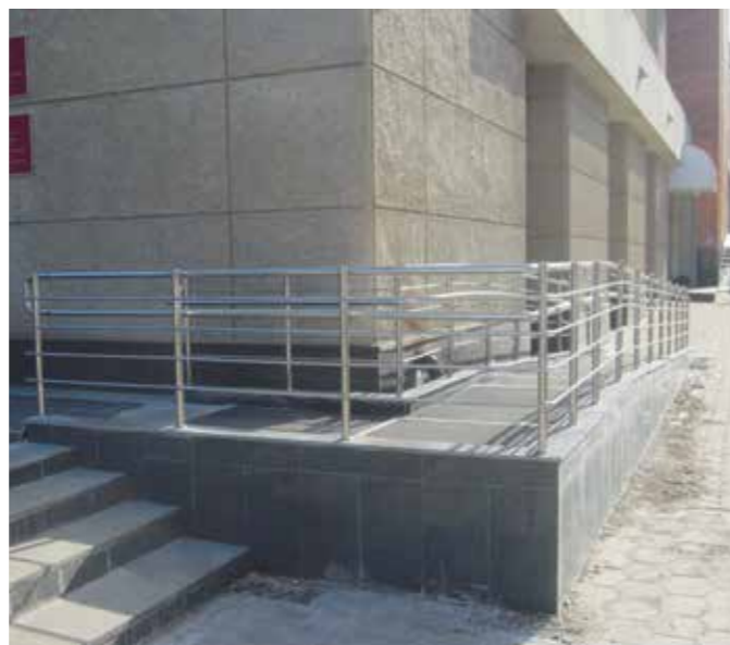
Ограждения «Г-образного» пандуса при входе в ФНС г.Тула. Бюджет позволил сделать дополнительные 4 ограничителя в виде ригелей Ф16мм помимо наличия небольшого парапета.
