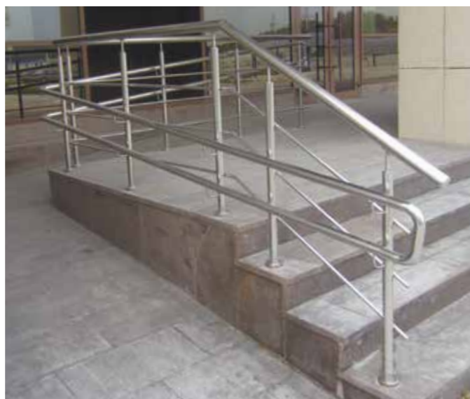
Комбинированное ограждение входной группы и пандуса. Стойки входной группы служат также опорами для двойного поручня перил пандуса.
