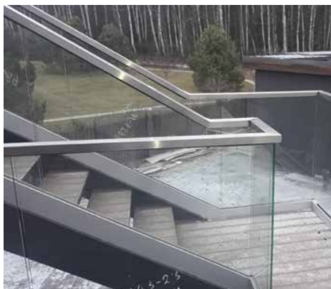
Ограждение из стекла уличной лестницы с креплением в несущий профиль и поручнем 60x40мм из нержавеющей стали AISI304.
