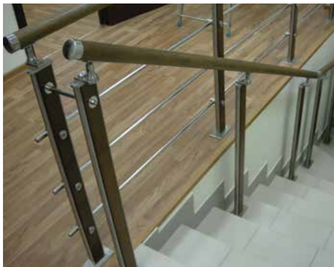
Стойки из шлифованной стали с деревянными вставками и деревянным поручнем диаметром 50 мм в цвет вставок. Поручень и ригели не завязанным на повороте.
