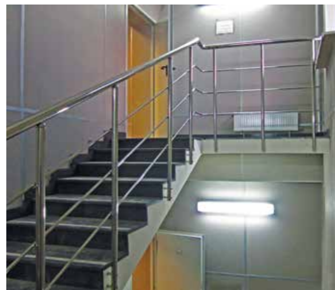
Боковой крепеж трехригельного ограждения на шпильках с выносом 30 мм от марша и завязкой с выходом в горизонт на длину выбегания площадки на марш. 3 стойки на горизонтальной площадке для большей мощности.
