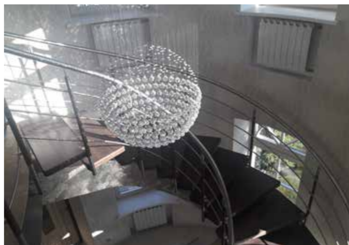
Перила из нержавеющей стали по винту с обеих сторон забежной лестницы. Комбинированные стойки из нержавейки и дуба в тон ступеней с креплением с торца для сохранения ширины и без того узкого марша.
