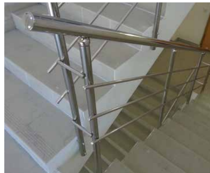
Стандартное 3-х ригельное ограждение с торцевым креплением через шпильку вплотную к лестничному маршу. Поручень и ригель прерывается.
