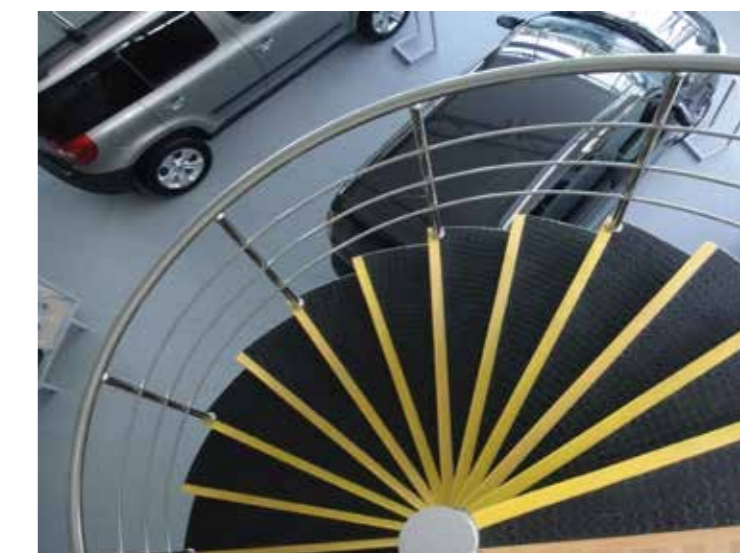
Винтовая лестница на центральном столбе. Ступени оклеены противоскользящими полосами и текстурированными накладками из резины.
