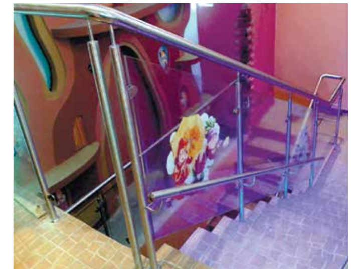
Ограждение для коммерческого детского центра высотой 1200 мм с безопасным стеклом триплекс 4+4 мм и поручнем д. 38 мм на выносах от стойки на высоте 500 мм. Наконечник k006, стеклодержатели k001, крепление сверху в ступень с маленькой крышкой k015.
