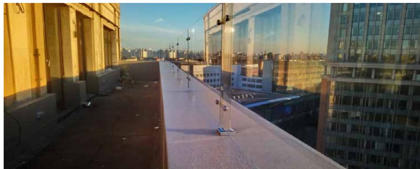
Ограждение парапета эксплуатируемой кровли в реконструируемом доме. Стекло относительно стоек закреплено на пластинчатых держателях, что обеспечивает минимальные зазоры между стеклами и лучшую ветрозащиту и безопасность.
