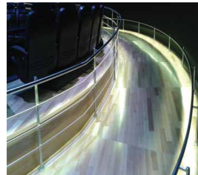
Освещение пандуса светильниками, встроенными в поручень.
