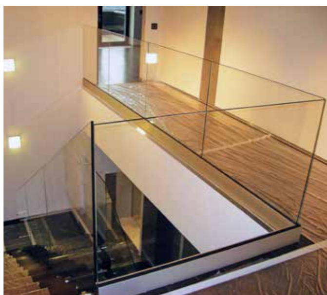
Ограждение без поручня со стеклом 12 мм в алюминиевом профиле, с переходом на боковой крепеж на марше.
