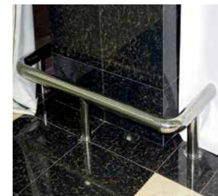
Защита колонны от тележек в гипермаркете.
