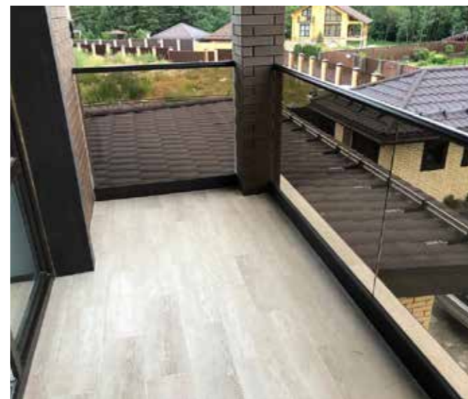
Несущее стекло бронза 12мм в зажимном профиле с поручнем из нержавеющей стали, крашенным как и профиль по каталогу RAL.
