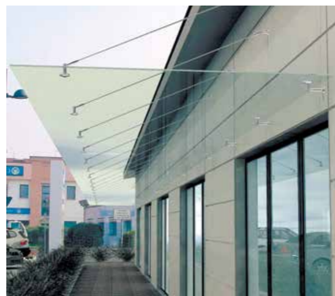
Козырек длиной 15 метров на вантах с осветленным стеклом 8+8 мм.
