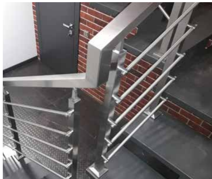
Ограждение колодезной лестницы с поручнем 60x40мм, имеет сложную геометрию на повороте лестницы.
