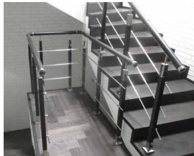
Ограждение с комбинированными стойками 40*40мм и дубовым деревянным поручнем. Для большей жесткости ограждение на площадке второго этажа установлено П-образно.
