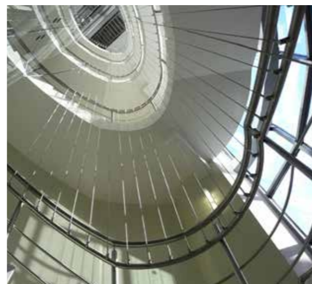
Ограждение забежной лестницы в жилом доме с оригинальным решением - вертикальным частотолом из нержавеющей тросиков.
