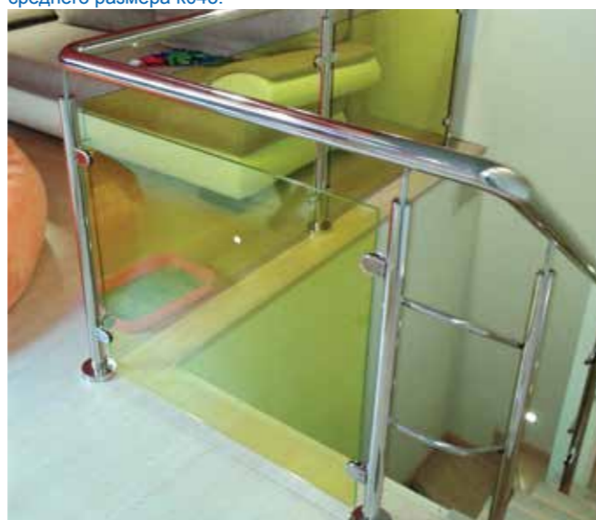
Стекло с желтой декоративной пленкой. На углу завязка 2 ригеля диаметром 16 мм. наконечник стойки сфера k034, крепление стойки сверху в ступень с большой крышкой k201.
