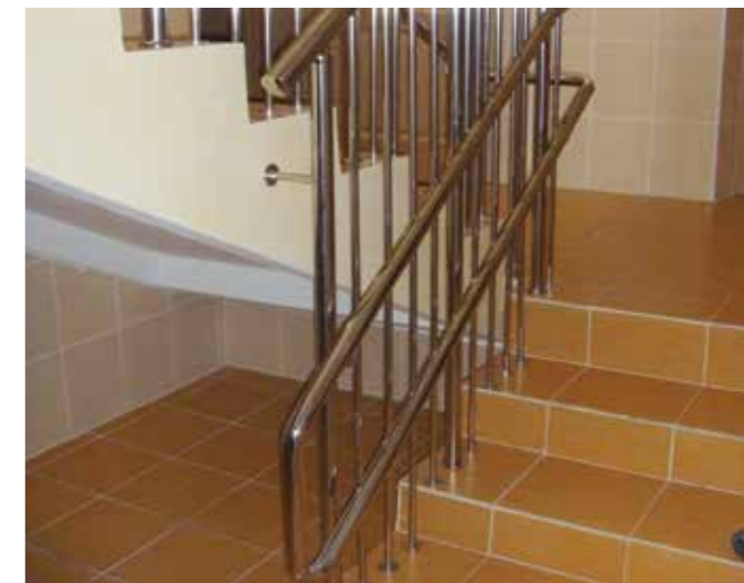
Ригельное ограждение в школе с креплением ригелей вертикально в плитку и дополнительным укреплением стойки в соседний марш. Поручни на высоте 500 мм, 700 мм, 1500 мм.
