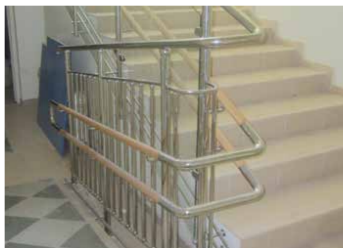
Комбинированное детское ограждение, пандус на первом этаже с вертикальным заполнением каждые 100мм, по лестничному маршу заполнение из каленого стекла, двойной деревянный поручень непрерывен на поворотах.
