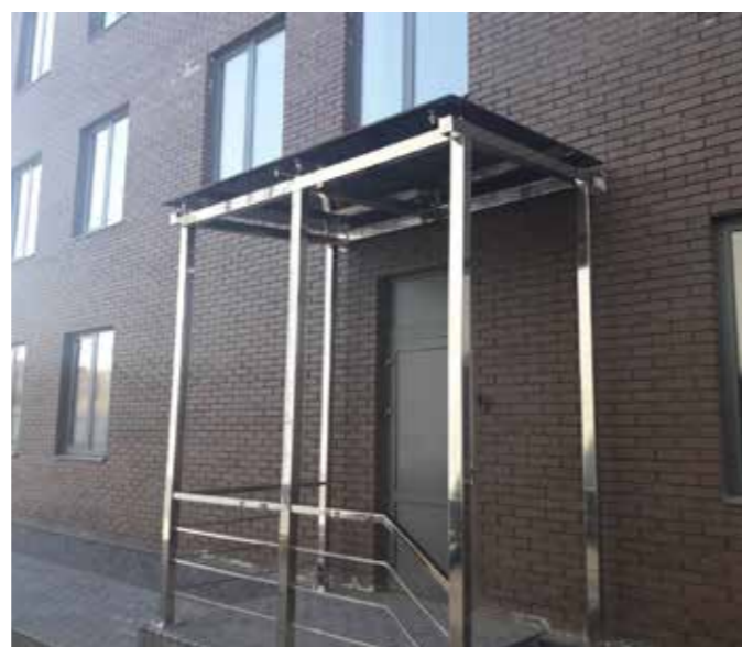
Входная группа из нержавеющей стали и навесом из черного стекла триплекс на слайдерной системе.
