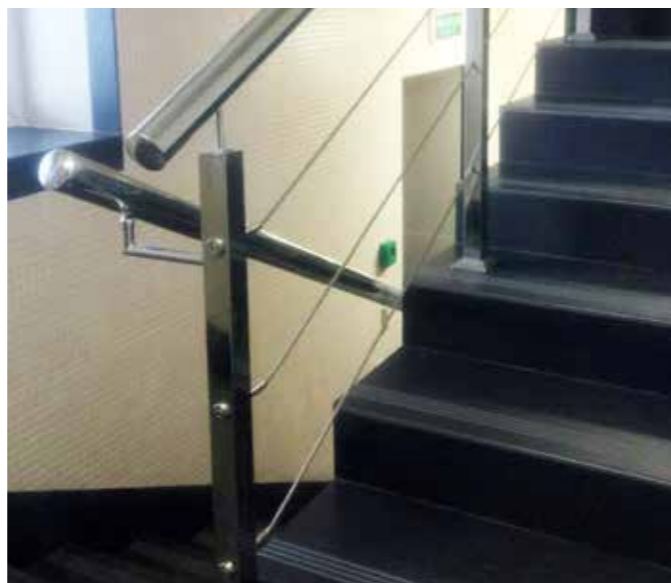
Ограждения из шлифованной нержавеющей стали с тремя тросиками на квадратных стойках 40x40 мм с круглым поручнем 50 мм.
