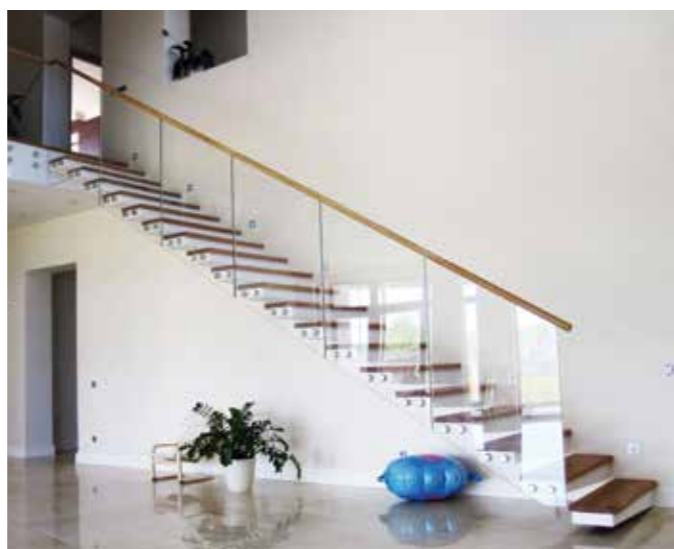
Консольная лестница и ограждение без стоек - классическое сочетание. Комбинация глянцевых боковых креплений и деревянного поручня с глянцевым лаком и осветленным стеклом 12 мм.
