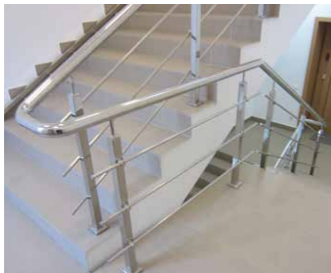
Ограждение лестницы на квадратных стойках 40x40 мм, с тремя ригелями диаметром 16 мм, на ригеледержателях, без завязки на поворотах. Поручень круглый, завязан между маршей, выходит на горизонт на всю длину выбега площадки.
