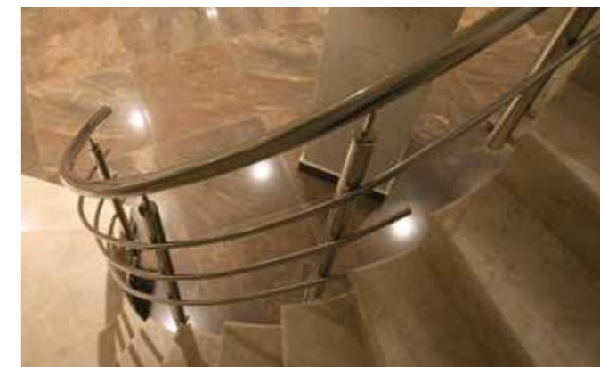
Ограждение забежной лестницы гнутое по спирали с ригелями в частном доме с торцевым креплением с выносом относительно марша.
