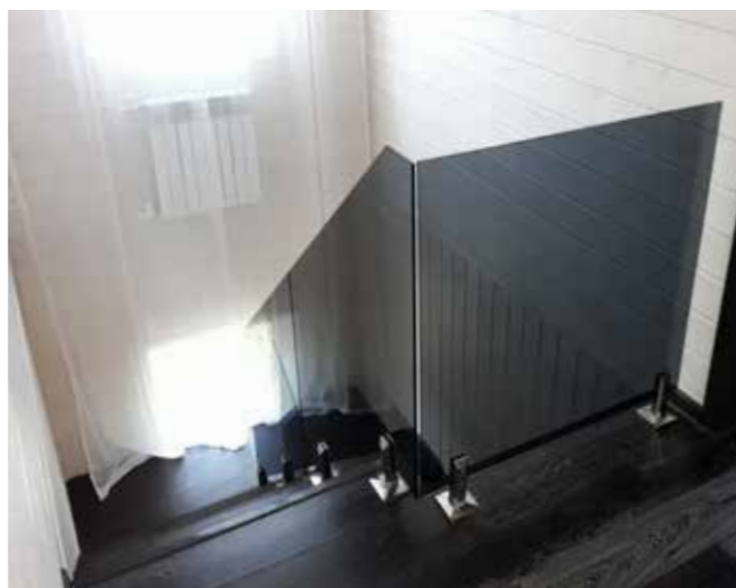
Ограждения из тонированного в массе черного стекла с креплением на министойках без поручня.
