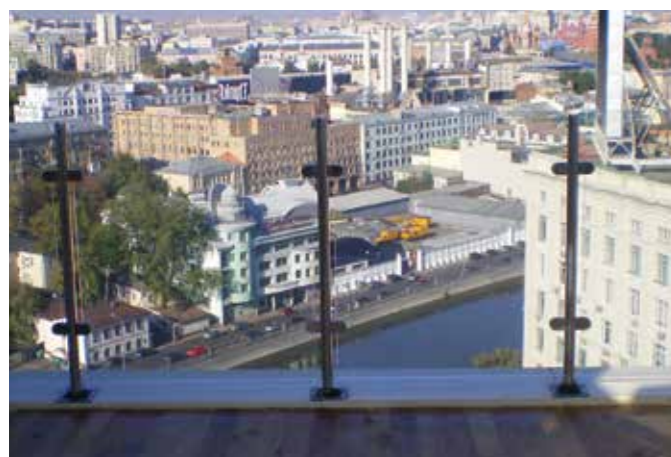
Экономичный вариант ограждения в ресторане на обслуживаемой кровле. Высота ограждения 900 мм, без поручня. Стойки круглые д.42 мм. Осветленное стекло установлено на зажимных стеклодержателях.
