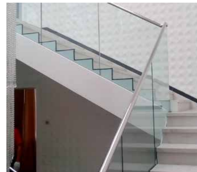
Колодезная лестница со скрытым торцевым точечным креплением несущего стекла ограждений.
