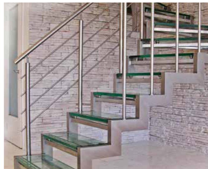
Лестница на двух параллельных косоурах из нержавеющей стали со стеклянными ступенями из триплекса 8+8+8 мм. Ограждение из шлифованной нержавеющей стали с четырьмя ригелями.
