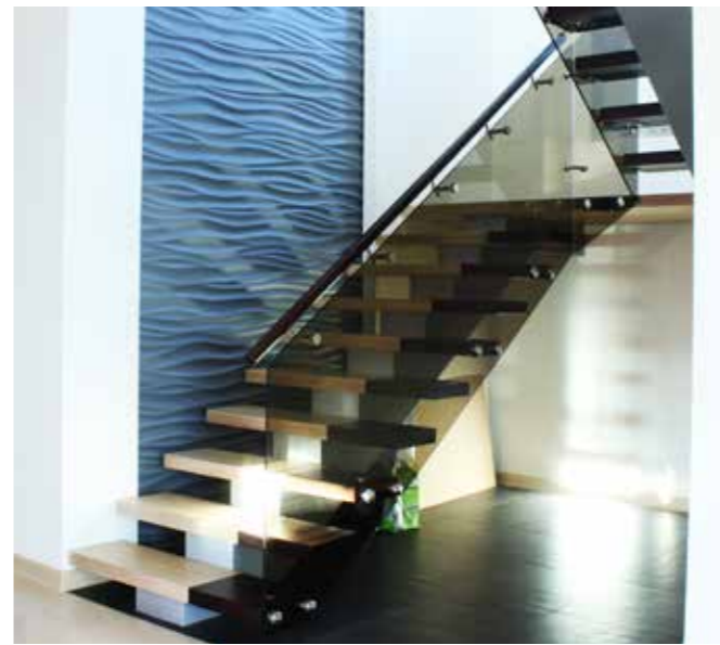
Ограждение без стоек с серым дымчатым стеклом 12мм с боковым креплением в деревянные ступени консольной лестницы и поручнем из тонированного дуба на выносных держателях k241.
