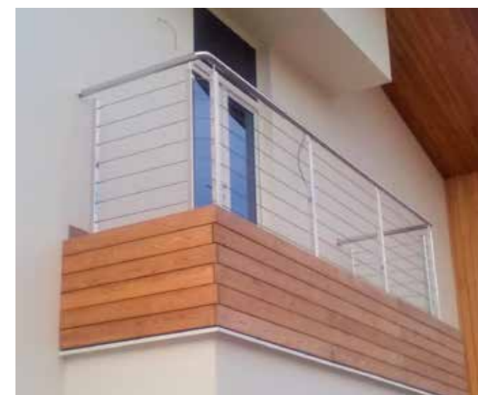
Стильное ограждение балкона из нержавеющей стали с тросами. Расстояние между тросами такое же как ширина облицовочных деревянных ламелей фасада дома.
