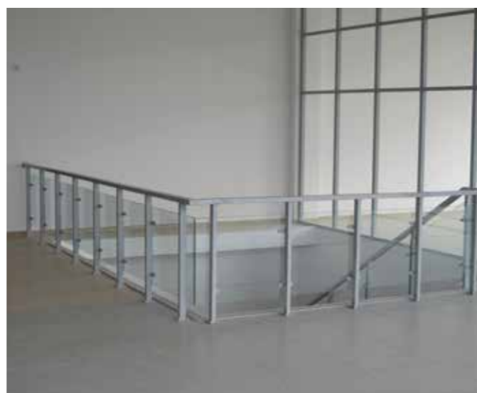
Ограждение в автосалоне. Мощные стойки из черного металла в цвет пола и стеклопакетов, по заданию от архитекторов должны удерживать машины от падения вниз.
