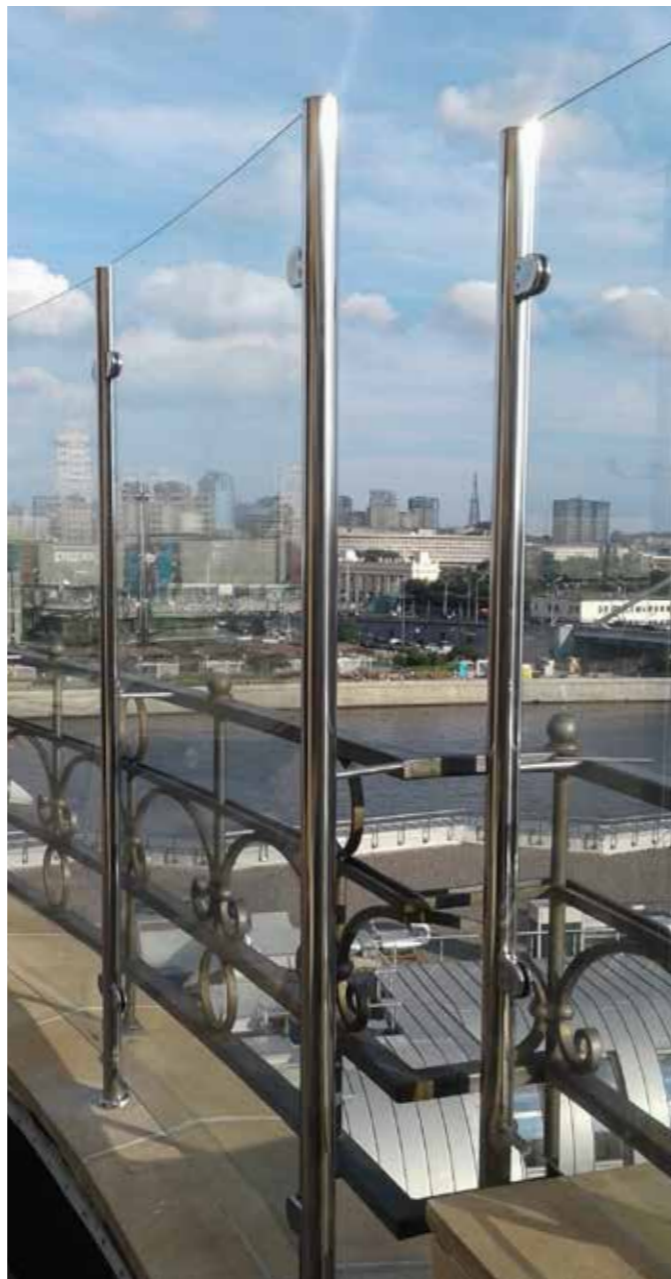
Ветрозащитное ограждение общей высотой 1800мм вместе с парапетом. Крайние стойки для жесткости закреплены к уже существующим ограждениям из черного металла.
