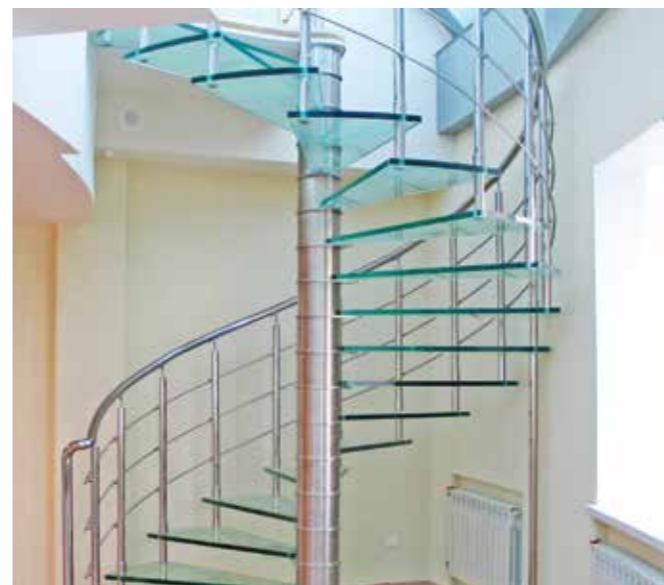
Больцевая винтовая лестница на наборном центральном столбе с трехригельным ограждением.
