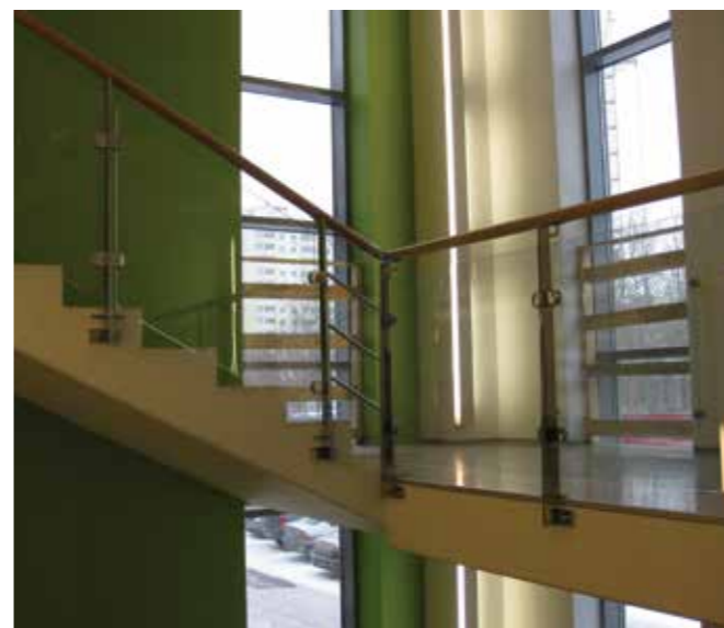
Стекло ограждение со стойками из полированной нержавеющей стали 10 мм, с минималистичным боковым крепежом и деревянным поручнем, завязанным нержавеющей сталью на поворотах.
