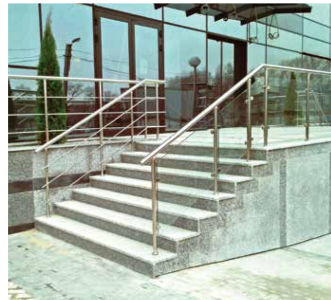
Ограждение входной группы комбинированное: с внешней стороны со стеклом на стойках, с ригелями ближе к фасаду.
