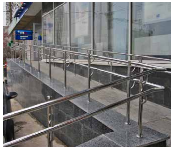
Ограждения «Г-образного» пандуса отделения банка. Ограничителем с внешней стороны служит парапет, в который сверху закреплены стойки с двойным поручнем на высоте 700 мм и 900 мм.
