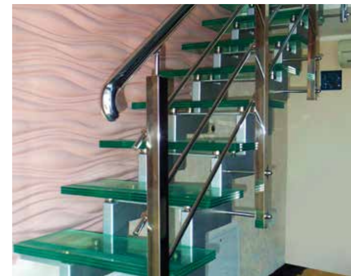
Лестница на двух косоурах из черного металла. Ступени из триплекса 10+10+10 мм.
