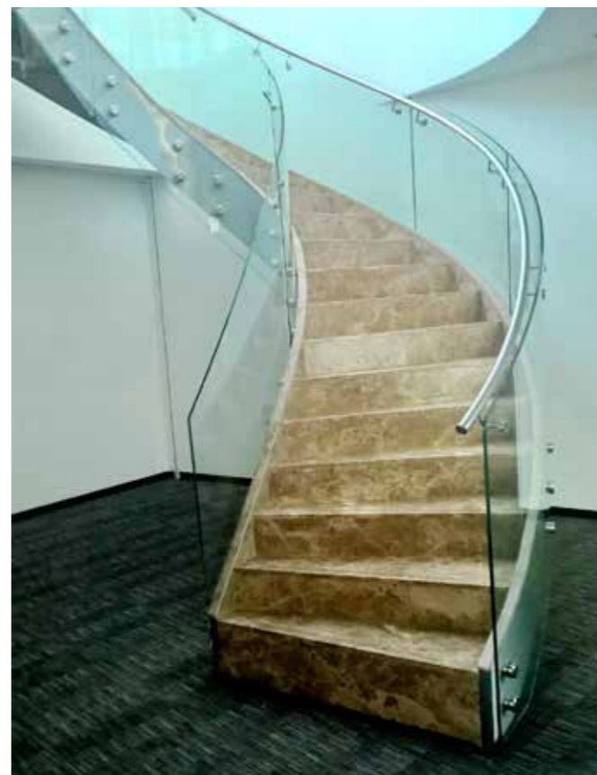
Моллированные несущие стекла ограждения закреплены в торец лестницы на точечные крепления, поручень из нержавеющей стали на выносе.
