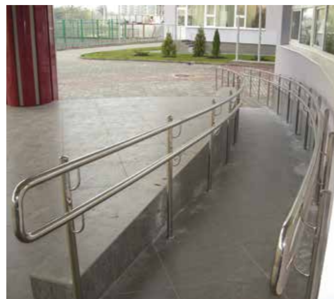
Перила пандуса радиусные. Крепление стоек в парапет было не возможно из-за отсутствия «тела» парапета. Правая линия ограждений могла быть заменена на двойной пристенный поручень.
