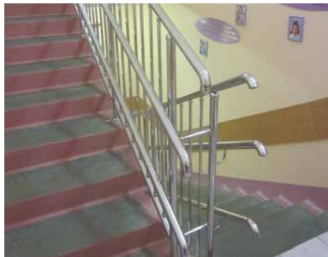
Ограждение с ригелями и тремя поручнями по чертежу заказчика. Поручни не завязаны между маршами с отводами оконечными на конце каждого поручня. Стойки на соседних маршах связаны перемычками.
