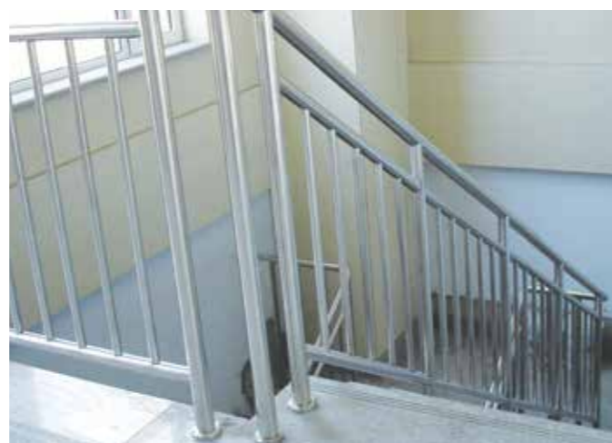
Ограждение школьного учреждения со стойками Ф38мм, заполнение между стоек фрезерованная труба Ф38мм и вертикальное заполнение из трубы Ф25мм с фрезой. Повышенная трудоемкость фрезеровки увеличивает стоимость таких ограждений.
