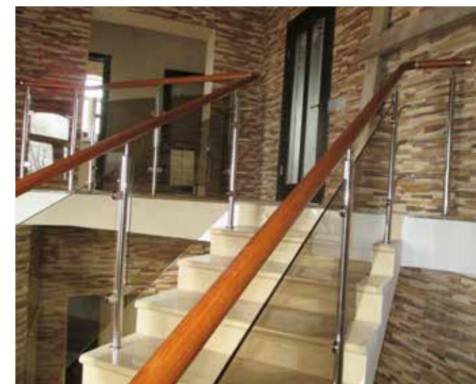
Ограждение частного дома с бронзовым стеклом 8мм и деревянным поручнем цвета вишня, отлично сочетающимся с декоративной внутренней отделкой.
