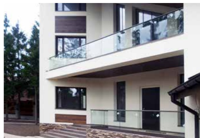
Стеклянные ограждение балконов первого и второго этажа. Профиль для стекла и поручень из нержавеющей стали покрашены в цвет по каталогу RAL.
