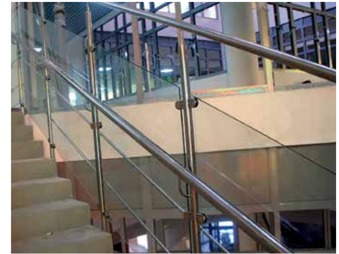
Ограждение для муниципальной школы с безопасным стеклом триплекс 4+4 мм и одним поручнем д.38 мм на выносе от стойки на высоте 900 мм. Крепление стоек сбоку от марша. Наконечник k006, стеклодержатели k038.
