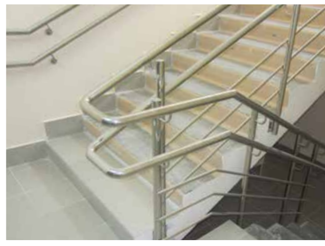
Ограждение в частной больнице с двумя поручнями д.38 мм на выносе. Стойки крепятся сбоку на пластине к056. На стене выполнен дублирующий пристенный поручень для облегчения подъема в обе стороны.
