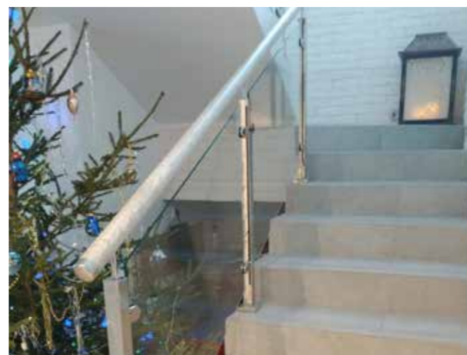
Ограждения со стеклом и стойками 40x40мм, поручень дубовый, тонированный в белый цвет с сохранением текстуры дерева.
