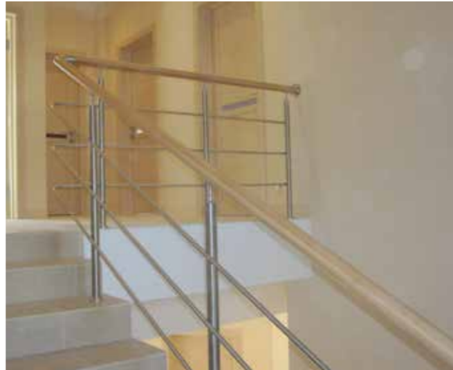
Ограждение из шлифованной нержавеющей стали с тремя ригелями и деревянным поручнем цвета натур, с окончанием в стену через фланец с открытым крепежом k022.
