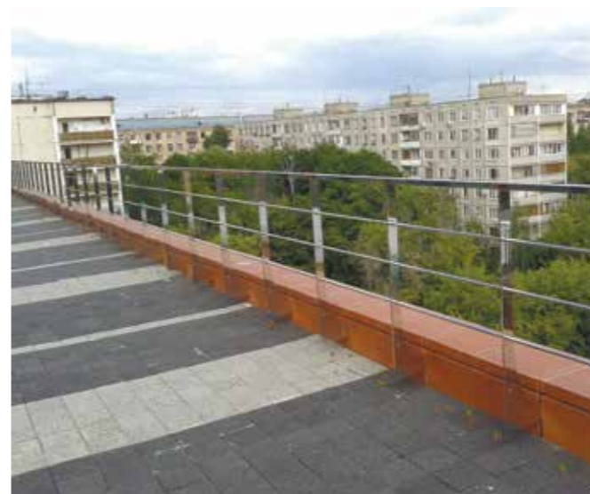
Пластинчатое ограждение обслуживаемой кровли из нержавеющей стали. 3 ригеля 16 мм. Каждая стойка обеспечена отверстиями для крепления люльки промышленных альпинистов в расчете 500 кг нагрузки. Стойки имеют зеркальную поверхность и малозаметны.
