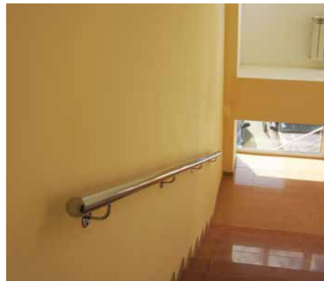
Классический простой пристенок. Диаметр поручня 50 мм, вынос 55 мм для обеспечения 25 мм зазора для свободного прохождения руки между поручнем и стеной. Крепление поручня снизу для удобного скольжения руки.
