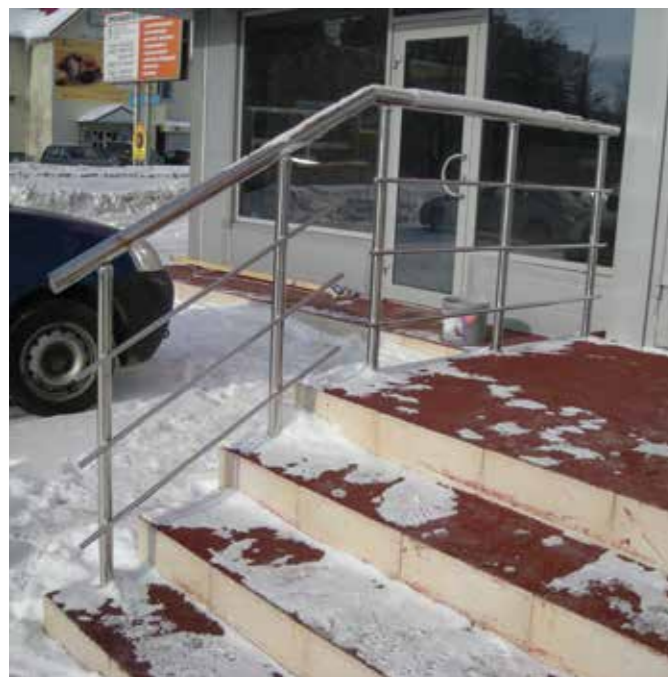
Ограждение входной группы с тремя ригелями. При выходе на площадку поручень непрерывен, а ригель прерывается.
