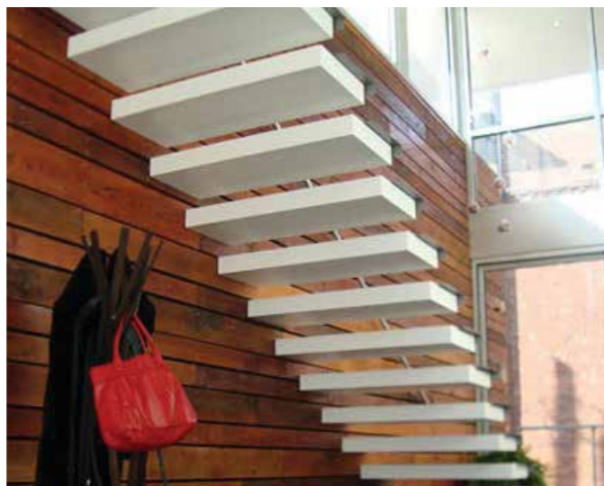
Консольная лестница без ограждений, металлокаркас обшит крашенными деревянными панелями.
