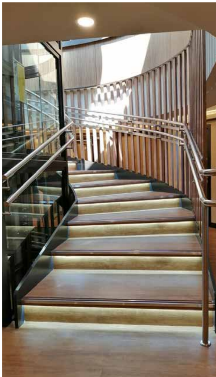
Двойной поручень из нержавеющей стали. Крепление держателей поручня с одной стороны к профильной системе стеклянной облицовки шахты лифта и к декоративной вертикальной обрешетке из дерева с другой.
