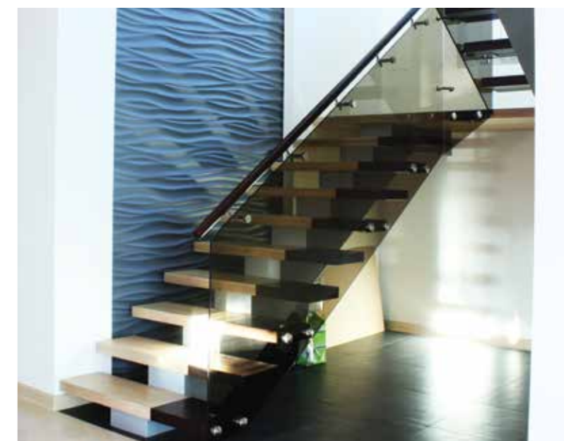
Боковой крепеж несущего стекла на точечных держателях.
