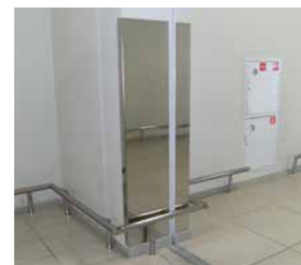
Отбойник вдоль стен крепление сверху в пол.
