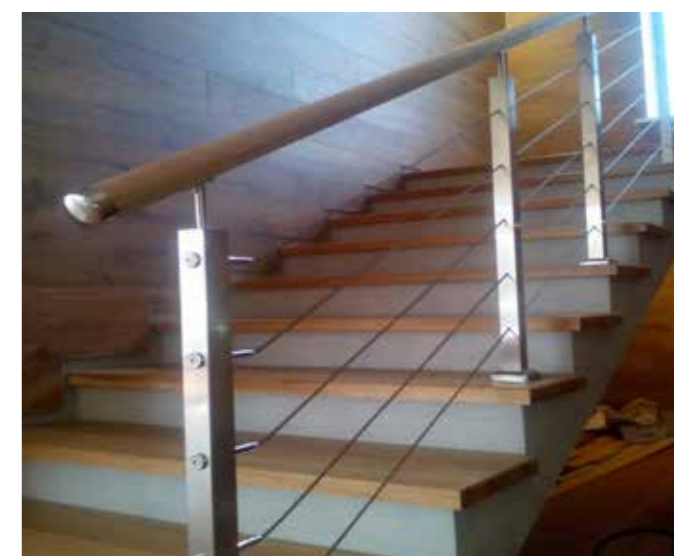
Перила с тросиками на лестницу с дубовым поручнем цвета натур под цвет ступеней
