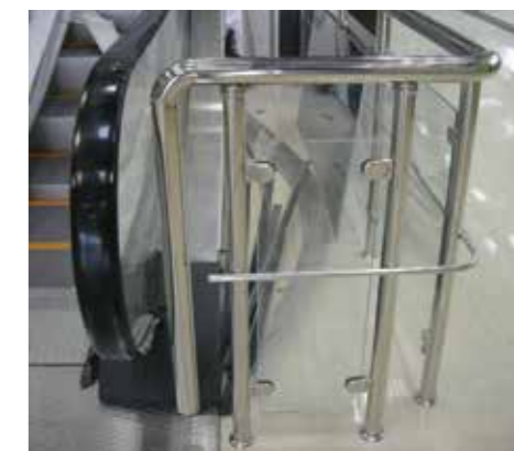
Примыкание к эскалатору. В данном случае бетонная плита подходит к механизму вплотную и крайнюю стойку удалось поставить поближе.
