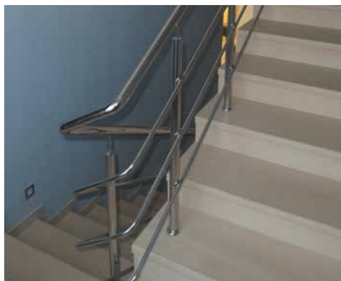
Стандартные ограждения лестницы с 3-мя ригелями и наконечником штырь k041.
