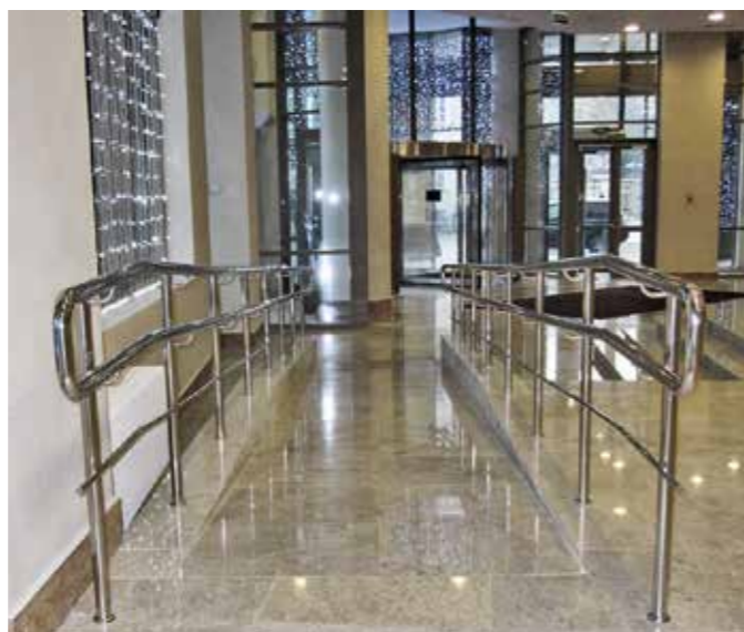
Ограждения пандуса внутри торгового центра. Крепление стоек осуществлялось методом бурения дорогостоящего керамогранита и бетона и последующей вклейкой на специальный состав.
