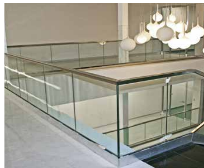
Ограждение в офисе без стоек с триплексом 8+8 мм, с прямоугольным поручнем с пазом k824 из полированной нержавеющей стали. Такое же ограждение установлено на лестничном марше с креплением профиля сверху в парапет.
