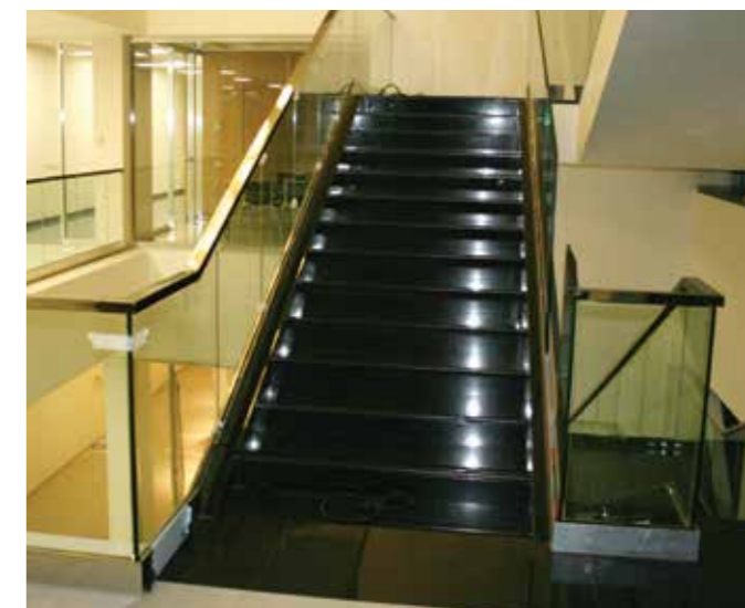
Ограждение в офисе без стоек с триплексом 8+8 мм, с прямоугольным поручнем с пазом k824 из полированной нержавеющей стали. Такое же ограждение установлено на лестничном марше с креплением профиля сверху в парапет.
