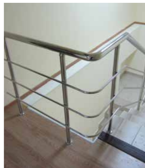
Выход на балкон лестничного марша, площадка забегает на марш и, чтобы сохранить высоту поручня, поворачивает в горизонте на длину вылета.
