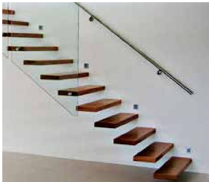
Консольная лестница в стиле минимализм с подсветкой и дублирующим пристенным поручнем. Ограждение без стоек из стекла толщиной 15 мм, закреплено в проеме потолка и в ступень.
