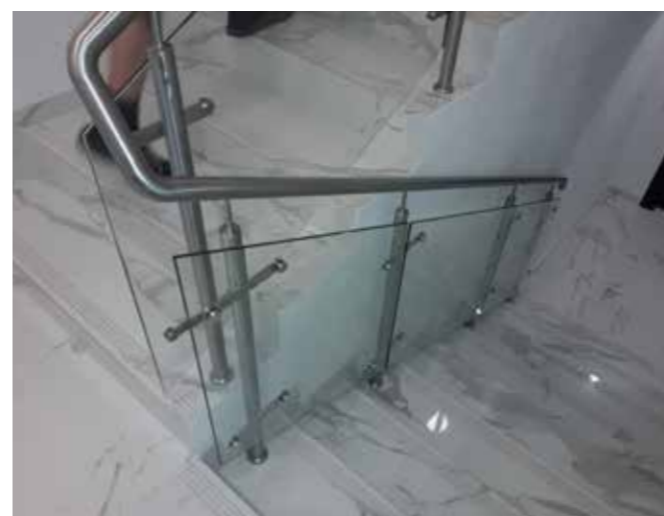
Ограждения со стеклом марки M1, установленным через пластинчатые держатели к круглым стойкам из нержавеющей стали Ф38,1мм.
