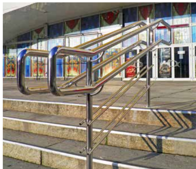
Потокоразделитель на лестнице при входе в кинотеатр. Поручень на выносных держателях расположен по обе стороны от стоек.
