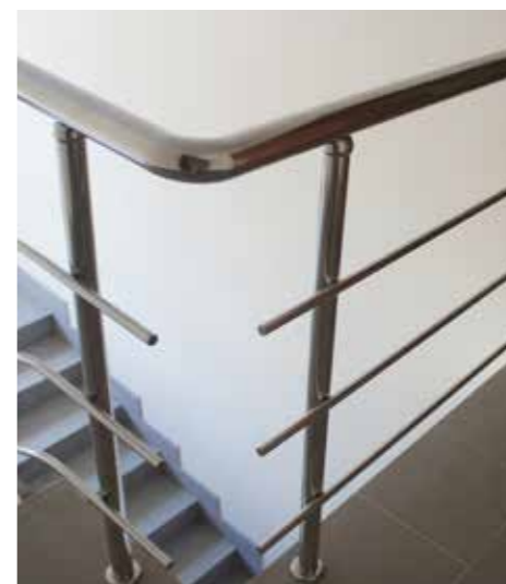
Выход на балкон лестничного марша, с завязкой только поручня, без завязки ригелей.
