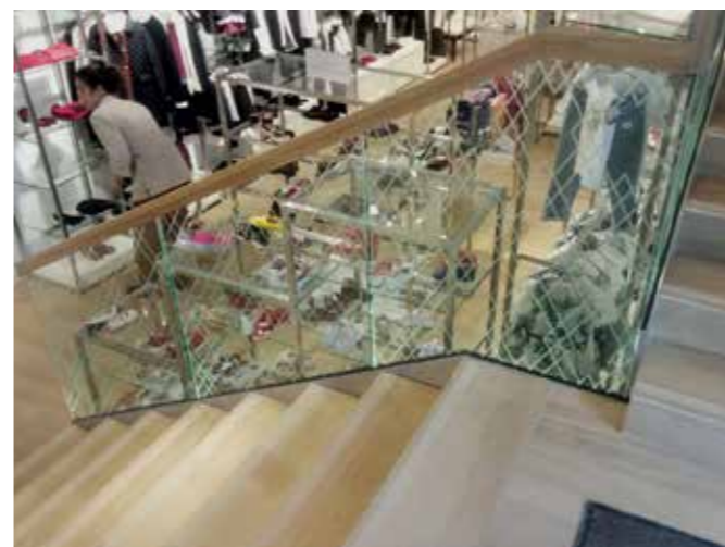
Ограждения стеклянные с пескоструйным рисунком и профильным поручнем из дуба со встроенной LED подсветкой.
