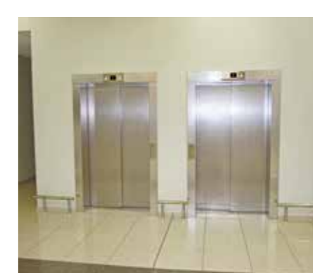
Защита отделки вокруг лифтового портала.
