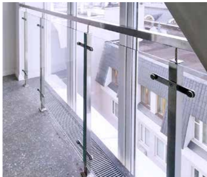
Ограждение проема окна для защиты от падения детей в нишу между стеклопакетом и площадкой.
