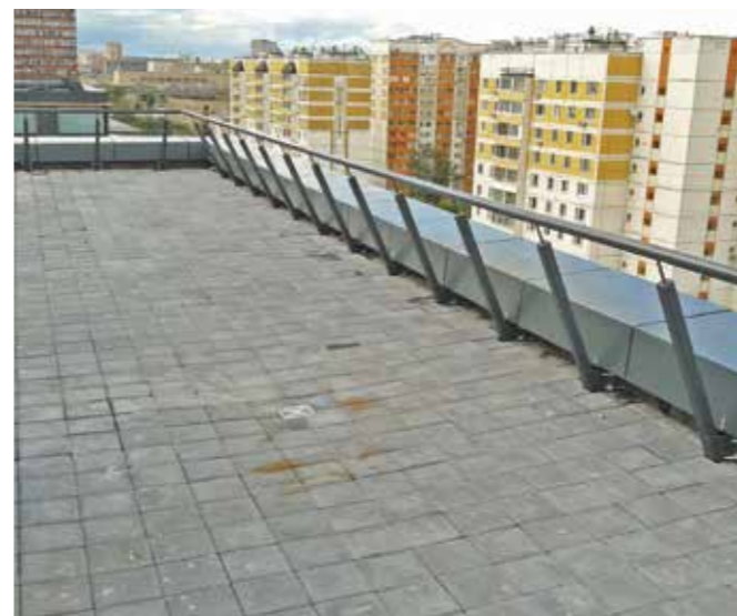
Черновое ограждение балкона в бизнес центре. Крепление стоек сбоку в парапет для сохранения архитектурного замысла: с земли ограждение не заметно за счет наклона стоек в площадь кровли.
