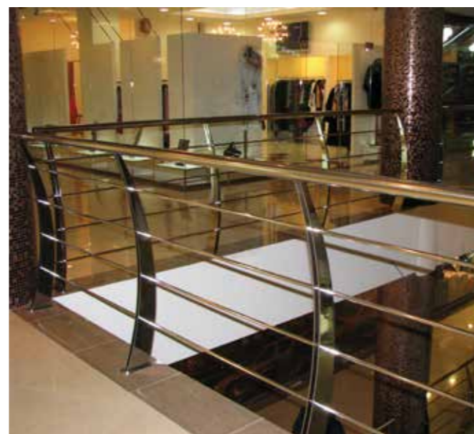
Ограждение атриума с четырьмя ригелями на стойках из полированной нержавеющей стали. Стойки изогнуты полукругом затрудняя детям использовать ограждение как лестницу.
