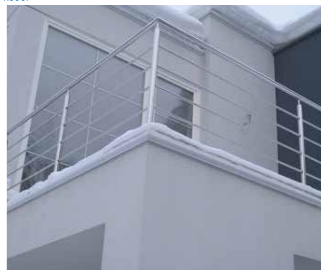
Ограждение балкона с 4 ригелями д.16 мм, закрепленными сквозь стойку. Наконечник K006.
