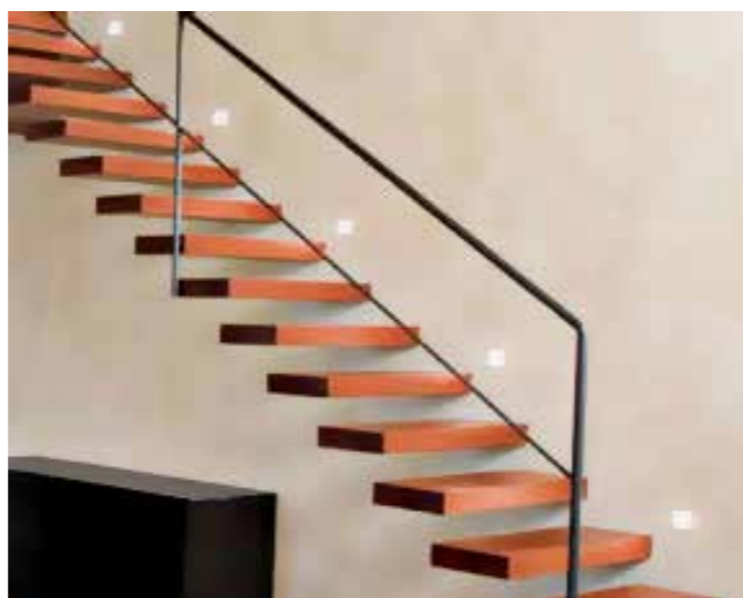
Консольная лестница с подсветкой. Ступени толщиной 80 мм. Минималистичное ограждение из черного металла.
