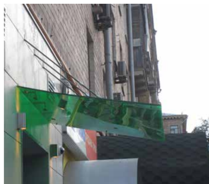
Козырек на вантах с монолитным зеленым поликарбонатом фирменного цвета заказчика.
