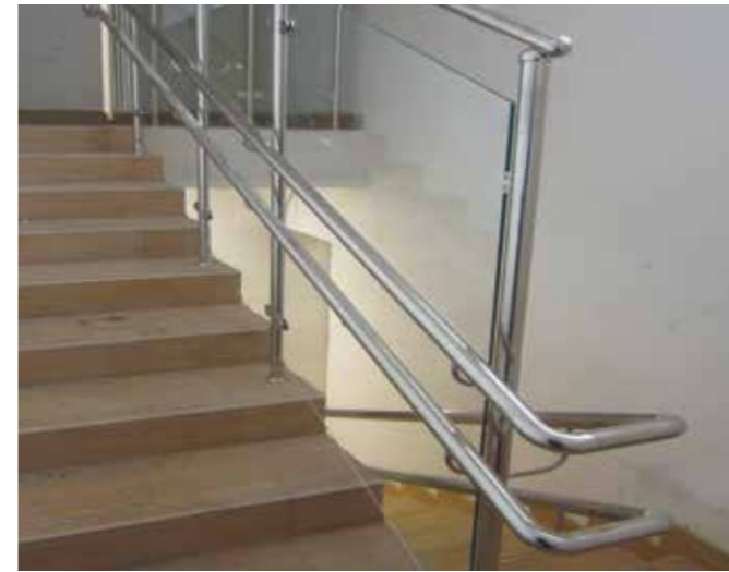
Ограждение для детского учреждения с безопасным стеклом триплекс 4+4 мм и 2-мя поручнями д. 38 мм на выносах от стойки на высоте 500 и 700 мм. Наконечник сфера k016, стеклодержатели k001, крепление сверху в ступень с маленькой крышкой k015.
