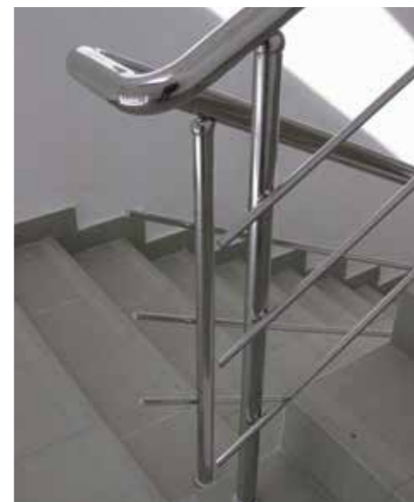
Стандартная лестница, ограждение с тремя ригелями, поручень завязан между маршами, ригели обрываются.
