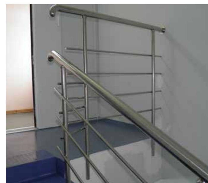
По желанию заказчика высота поручня на площадке 1200 мм и 4 ригеля, несмотря на то, что высота поручня на марше 950 мм и там всего три ригеля. Ригели и поручень на повороте не завязаны, перемычки соединяют стойки для жесткости.
