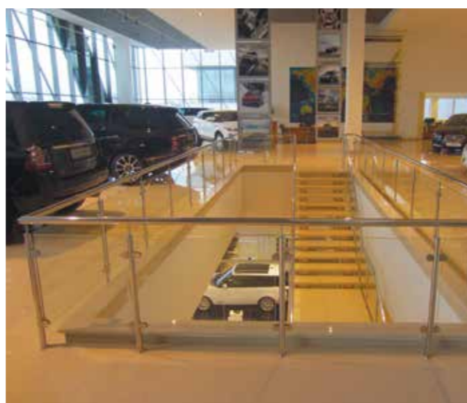
Ограждение экранного типа в автосалоне. Через стеклянные экраны стекла видны машины на первом этаже. Недорого и практично.
