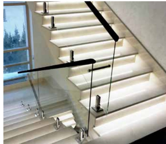
Стекланные ограждения на мини-стойках прямоугольной формы. Крайние стекла для жесткости соединены нержавеющей элементом.
