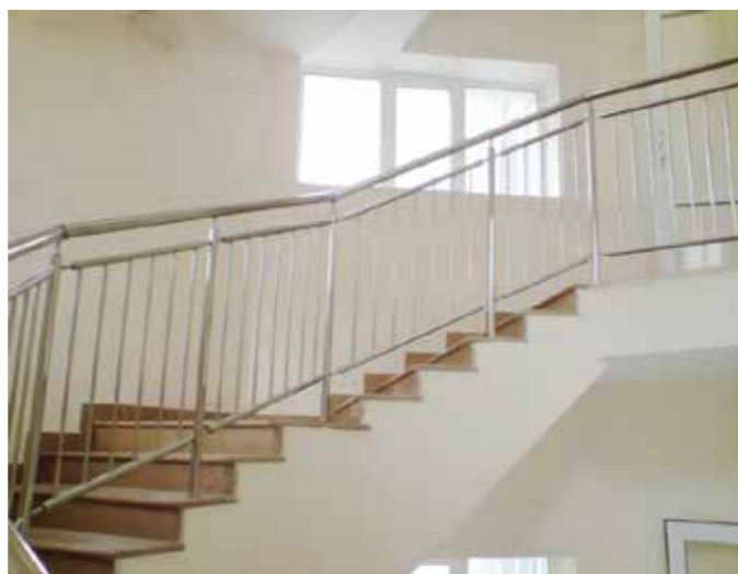
Ограждение в школе для старших классов с вертикальным заполнением, используется труба Ф25мм с перфорацией для горизонтального заполнения и Ф16мм для вертикального.
