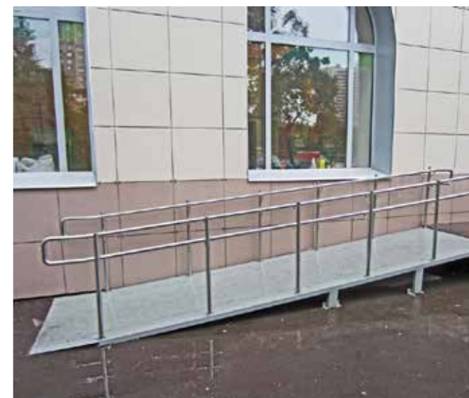
Экономичный вариант пандуса из черного металла с покраской и ограждениями из нержавеющей стали в соответствии с требованиями ГОСТа.
