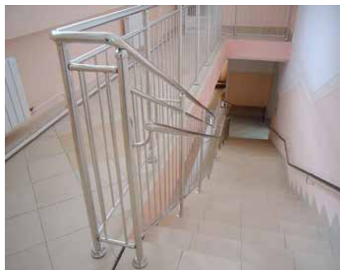
Поручень для самых маленьких установлен на стене на пристенных держателях на высоте 500мм, на основном ограждении верхний поручень на высоте 950мм, нижний 700мм. Вертикальное заполнение соответствует требованиям ГОСТ.
