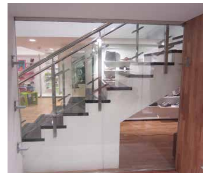
Ограждение из нержавеющей полированной стали с квадратными стойками и боковым крепежом на шпильках и наконечниками k239. Стеклодержатели удлиненные k047. Поручень круглый 50 мм.
