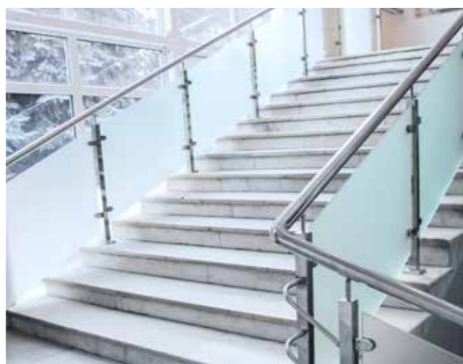
Ограждение на квадратных стойках 40x40 мм, стекло с ультра-матовой пленкой. На углах завязка 3 ригеля по 16 мм каждый. Зажимные стеклодержатели k039.
