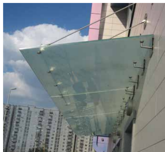
Большой козырек на вантах вынос 1,5 метра, длина 8 метров. Стекло триплекс 8+8 мм с матовой пленкой внутри.
