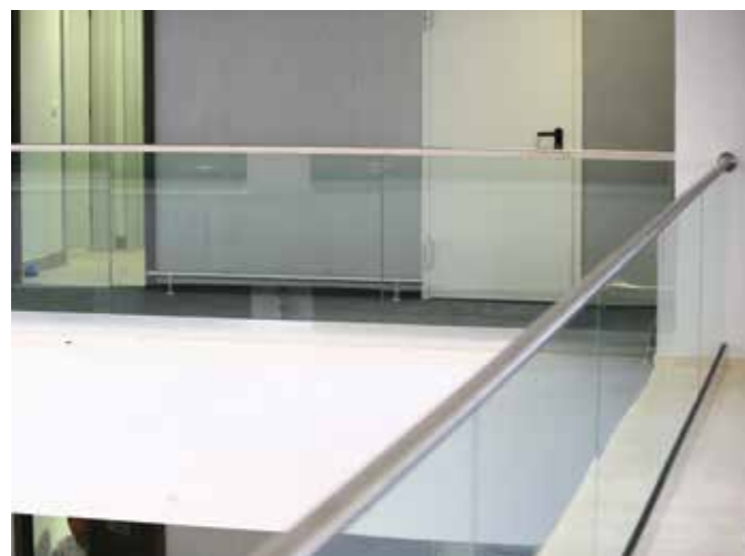
Ограждение со стеклом триплекс 8+8 мм в зажимном алюминиевом профиле k601 и поручнем с пазом диаметром 48,3 мм. Окончание поручня в колонну фланцем k238.
