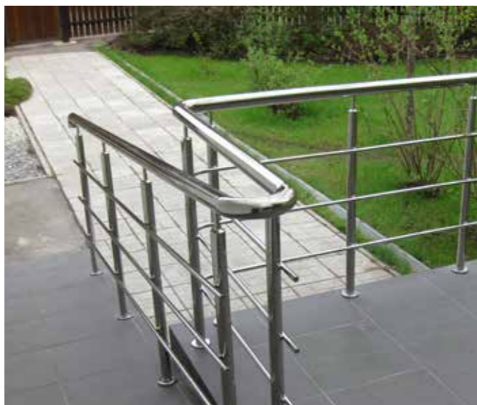
Ограждение парапета и балкона с тремя ригелями, наконечник k034. При повороте на площадку поручень непрерывен, ригель прерывается.
