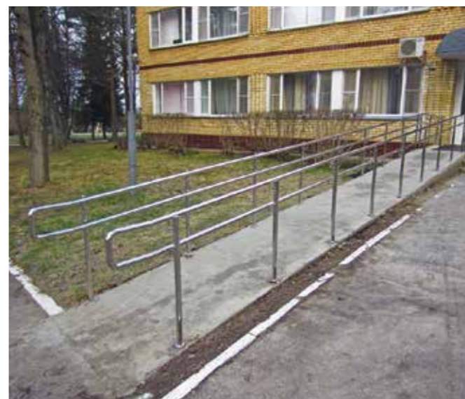
Асфальтированный пандус при входе в поликлинику. В местах крепления стоек на всю глубину залита песко-цементная смесь для надежности конструкции.
