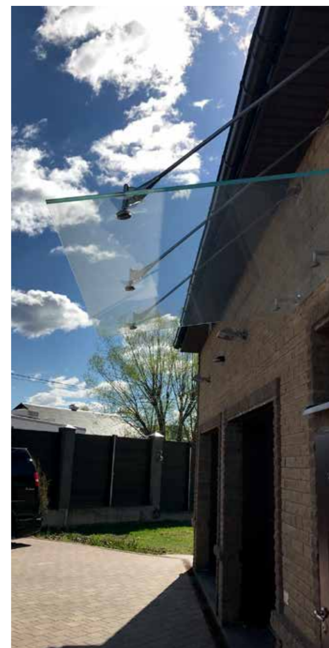
Козырек на вантах с креплением через декоративный облицовочный кирпич фасада, стекло осветленное оптивайт триплекс.
