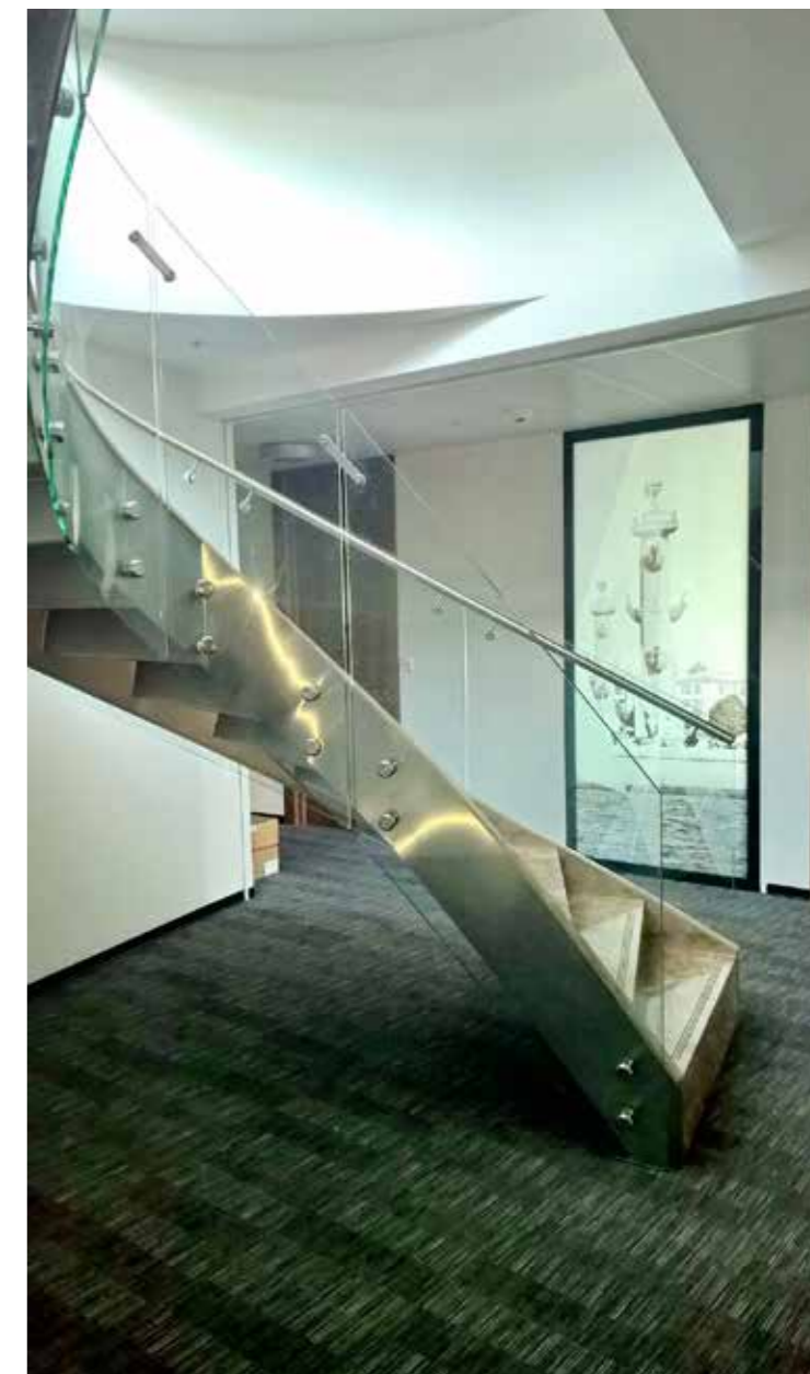
Несущие моллированные стекла по винтовой лестнице, для жесткости соединены пластинами из нержавеющей стали.
