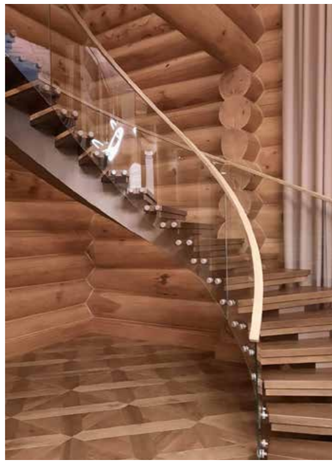
Стр. 23 каталога. Реализованный проект забежной лестницы в частном доме. Технически сложная, эксклюзивная лестница с моллированными стеклянными перилами и поручнем по винту, установленным сверху на стекла. Лестница идеально вписывается в общий стиль деревянного добротного дорогого дома.
