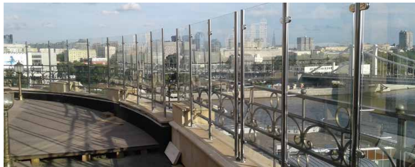
Дополнительное к существующему ветрозащитное ограждение эксплуатируемой кровли в центре Москвы. Шаг стоек был рассчитан исходя из общей ветровой нагрузки на стекло, а также с учетом общей симметрии всех секций ограждений. Такое ограждение защищает от ветра даже если человек стоит в полный рост, можно наслаждаться прекрасным открывающимся видом.
