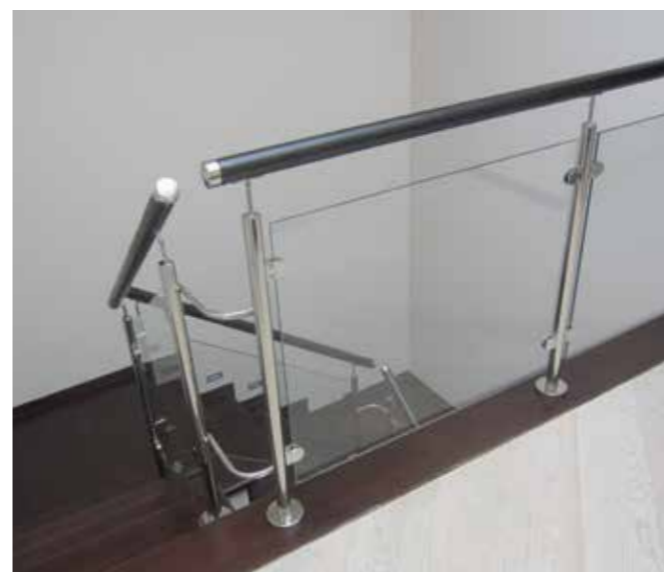
Пластиковый черный поручень не завязан на поворотах. Заполнение 2 ригеля диаметром 16 мм. Большая крышка основания стойки диаметром 100 мм, арт. k201.
