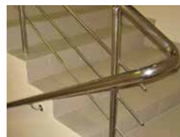
Переход поручня ограждений в пристенный поручень.
