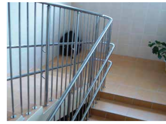
Ригельное ограждение в школе с креплением ригелей вертикально в плитку и большой шайбой-крышечкой. Поручни на высоте 500 мм, 700 мм, 1500 мм, завязаны между маршами.
