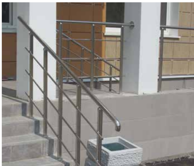
Ограждение входа в поликлинику. Стойки установлены в каждую ступень по просьбе заказчика, окончание поручня отвод k020.
