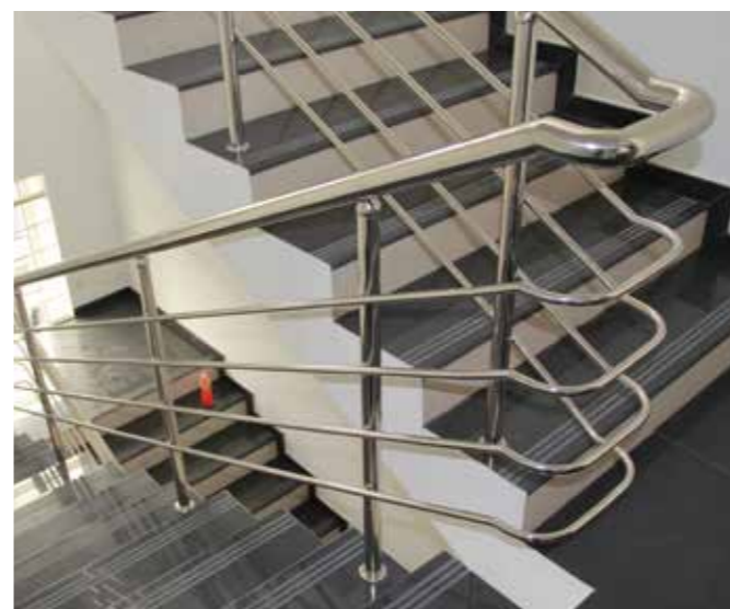
Ограждение лестницы, когда площадка набегает на оба марша сразу на глубину 200 мм, выход на горизонт этих ригелей и поручня на те же 200 мм для того, чтобы сохранить одинаковую общую высоту на соседних маршах. Наконечник сфера.
