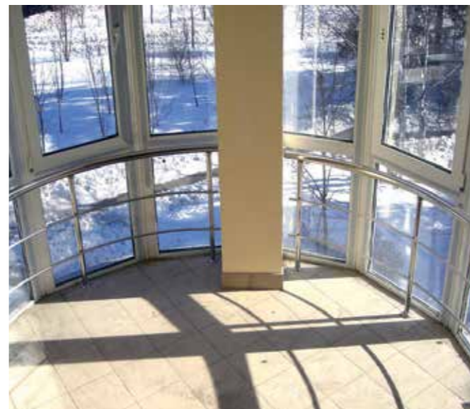
Ограждение в санатории с двумя ригелями гнущее по радиусу, предназначено для любования красивым пейзажем, открыв окно и облокотившись на поручень.
