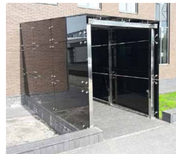
Входная группа-навес. Каркас из нержавеющей стали накрыт черным стеклом смонтированным на слайдерах.
