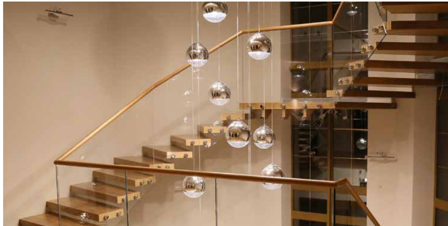
Стр. 6-7 каталога. Реализованный проект забежной лестницы в эркере частного дома с 1-го на 3-й этаж. Лестница консольного типа без опорок, парящая в воздухе. Цельностеклянные перила из осветленного стекла оптивайт толщиной 12мм. Поручень дубовый подобран в тон ступеней. Проектирование и монтаж такой лестницы необходимо начинать на этапе черновых работ в доме. Результат превзойдет все ваши ожидания.
