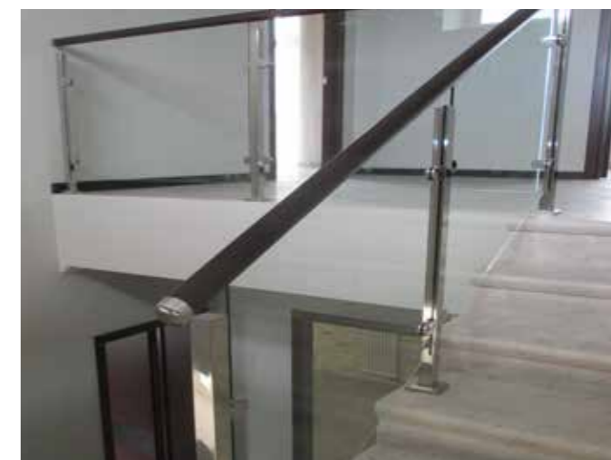
Ограждение со стеклом на стойках. Высота стекла выше уровня стоек, сверху установлен дубовый поручень с пазом, благодаря чему отсутствует зазор между стеклом и поручнем.
