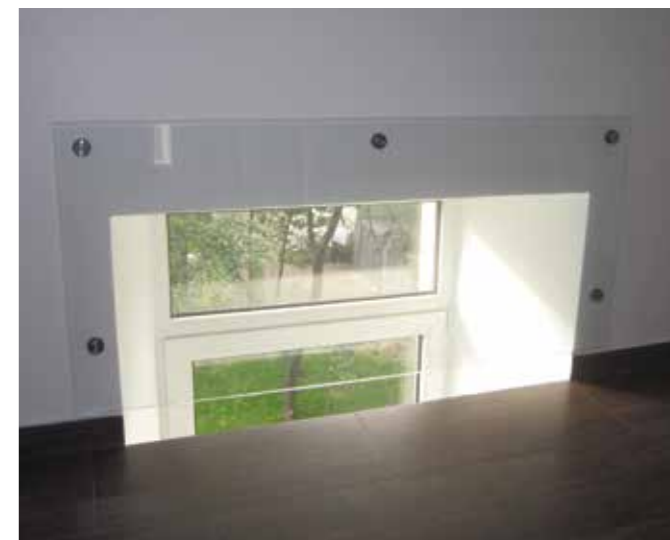
Ограждение окна стеклянным экраном в частной клинике. Зазор между стеклом и полом позволяет осуществлять мытье пола на площадке и, при желании, окон. Стекло 10 мм крепится на точечных держателях. На лестницу проникает максимум света. Очень красиво.
