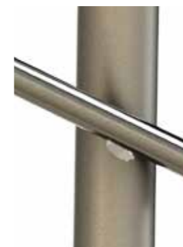
Приварка ригеля снизу (декоративный вариант).
