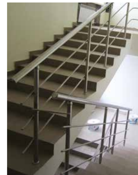
Стандартная лестница, ограждение с тремя ригелями, поручень и ригели развязаны между маршами. Стойки соединены одной перемычкой, выход на балкон завязан.
