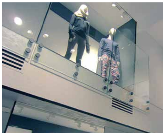
Ограждение, наряду с функцией защиты от падения, не мешает рассматривать витрину с одеждой на втором этаже. Точки бокового крепежа дополнительно окрашены в серый цвет.
