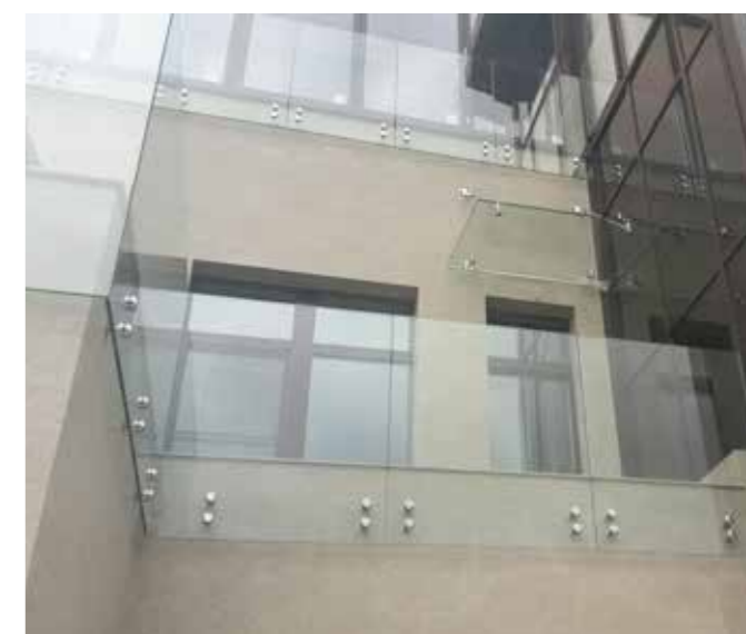
Ансамбль из стеклянных перил на точечном торцевом креплении и стеклянного козырька на вантах в частном коттедже.
