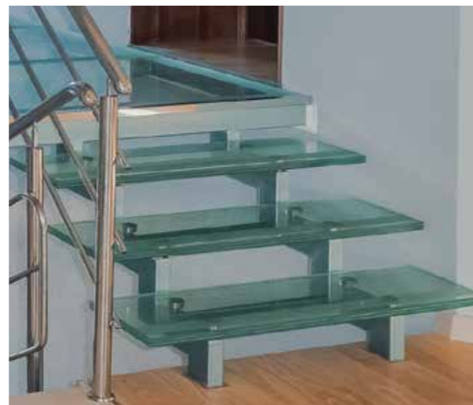
Стекланные ступени для выхода на стеклнную площадку. На торце ступеней хорошо видна структура стеклнной панели из трех листов.
