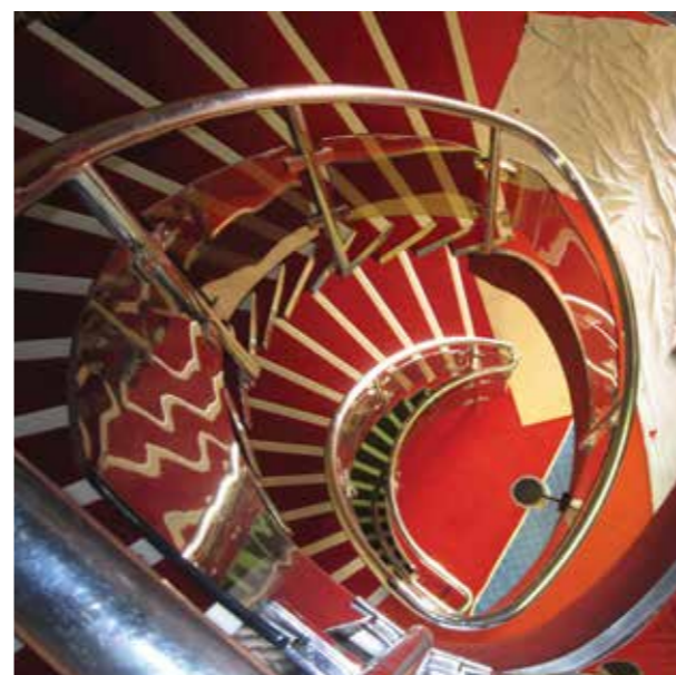
Ограждение с переменным радиусом. Заполнение - поликарбонат, который крепится к стойкам через зажимные стеклодержатели.
