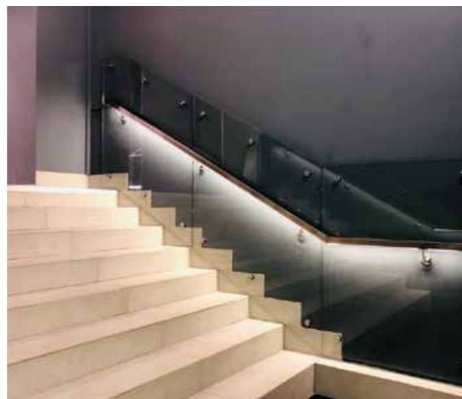
Поручень с подсветкой смонтирован на стеклянные полотна, закрепленные на точечном креплении к стене.
