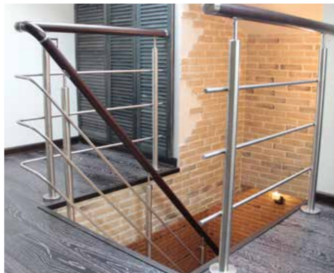
Круглые стойки диаметром 38 мм с большой крышкой k201, прикрывающей фланец трехканерной закладной с креплением в деревянный пол. Лестница с наклоном 60 градусов к горизонту забирет у дома мало площади, но ходить по ней не слишком комфортно. Поручень деревянный завязан с маршем.
