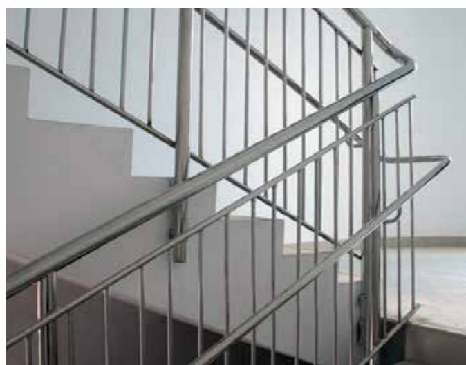
Бюджетный вариант ограждений для детского сада. Труба Ф16мм варится горизонтально внахлест к стойкам, установленным в торец лестничного марша, а к ней со стороны стоек привариваются внахлест вертикальные трубки Ф16мм с заглушками сверху и снизу.
