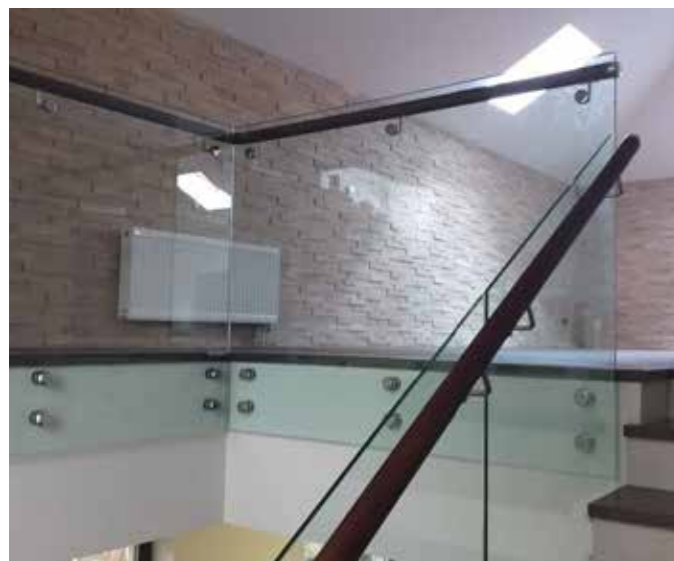
Стеклянные ограждения с дубовым поручнем на выносе, затонированным под цвет ступеней. Стекло закаленное 12мм марки М1 с зеленоватым отливом.
