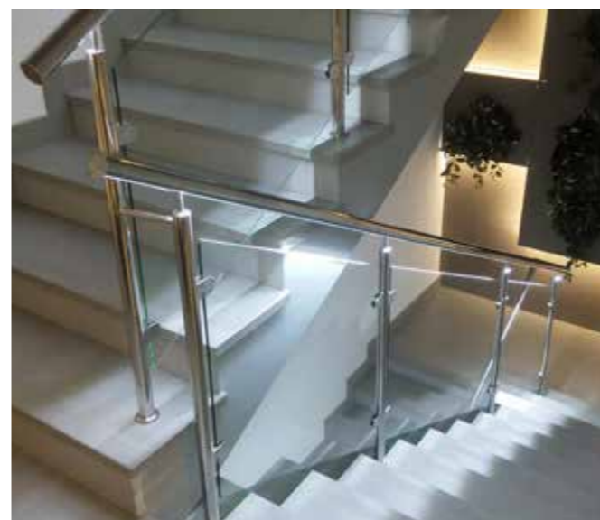
Простое ограждение на зажимных стеклодержателях. Освещение лестницы только с помощью подсветки внутри поручня ограждений.
