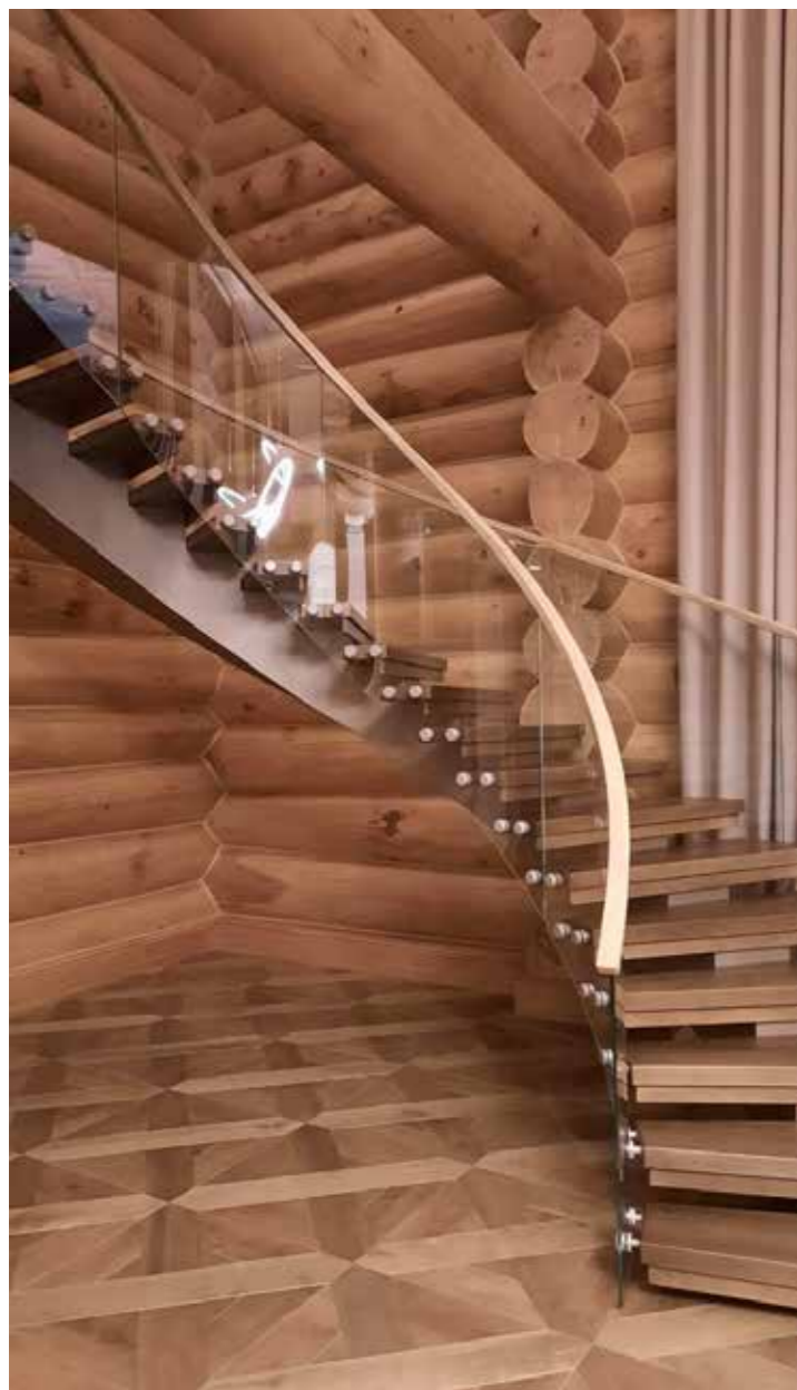
Цельностеклянные ограждения забежной лестницы с профильным дубовым винтовым поручнем. В каждой ступени по два крепления для стекла – красивое дизайнерское, но сложное техническое реализованное решение.
