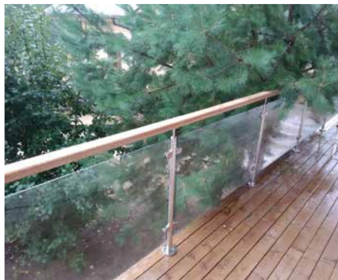
Ограждение террасы с увеличенным расстоянием между стоек и большими стеклами, поручень из лиственницы фигурного сечения.
