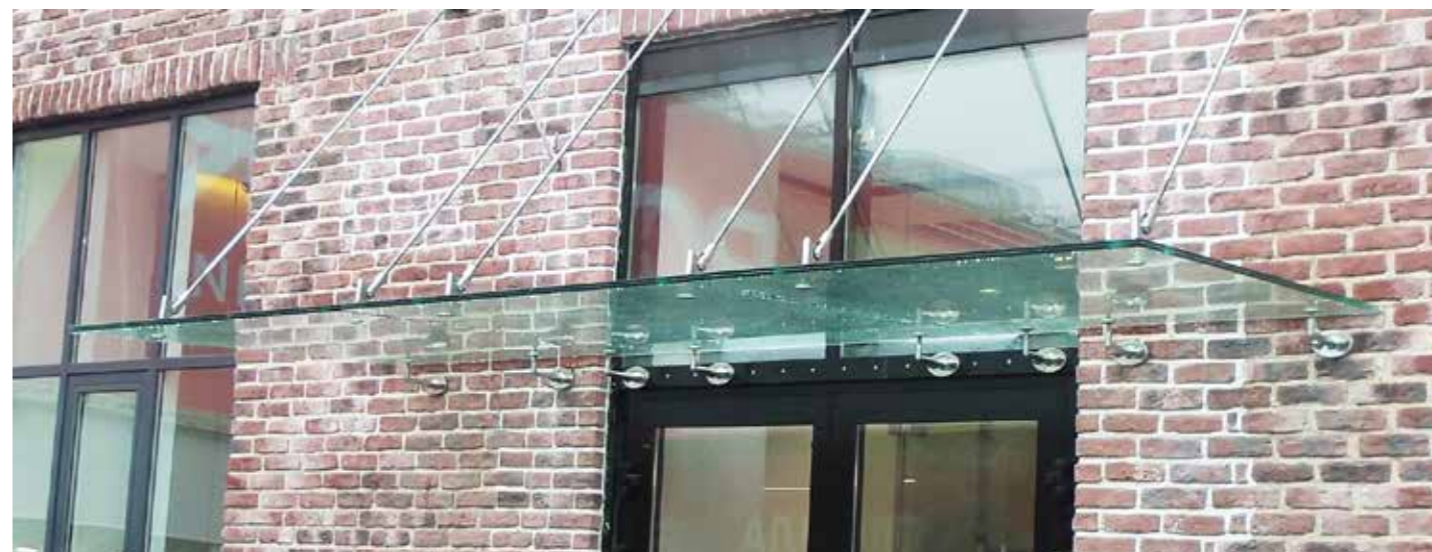
Козырек на вантах из стекла триплекс 8+8мм, смонтированный на кирпичную стену и закладную на фрамуге входной двери.
