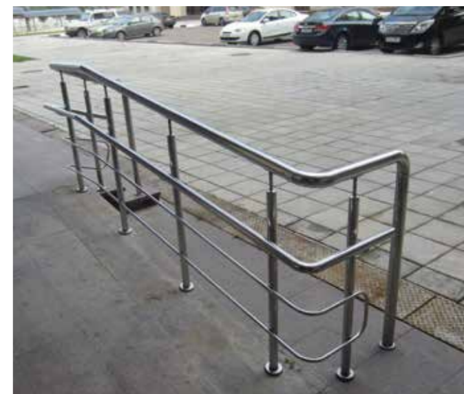
Ограждение входной группы скомбинировано с перилами на большом пандусе, уход поручня в пол придает дополнительную жесткость всей конструкции.
