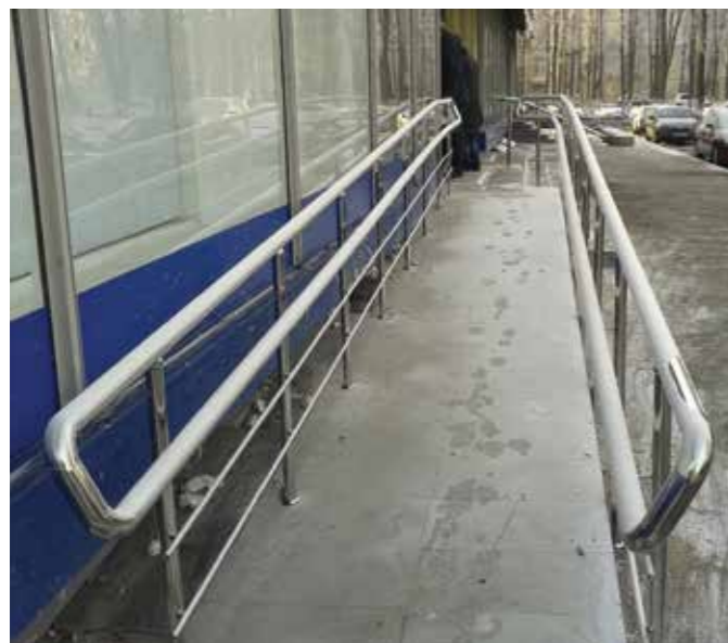
Перила на прямом пандусе при входе в магазин. Верхний поручень установлен сверху стойки на высоте 900 мм, нижний - на вынос относительно стойки на высоте 700 мм.
