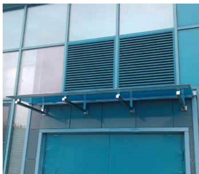
Навес консольного типа из нержавеющей стали и сотового поликарбоната над погрузочно-разгрузочной зоной ТЦ.
