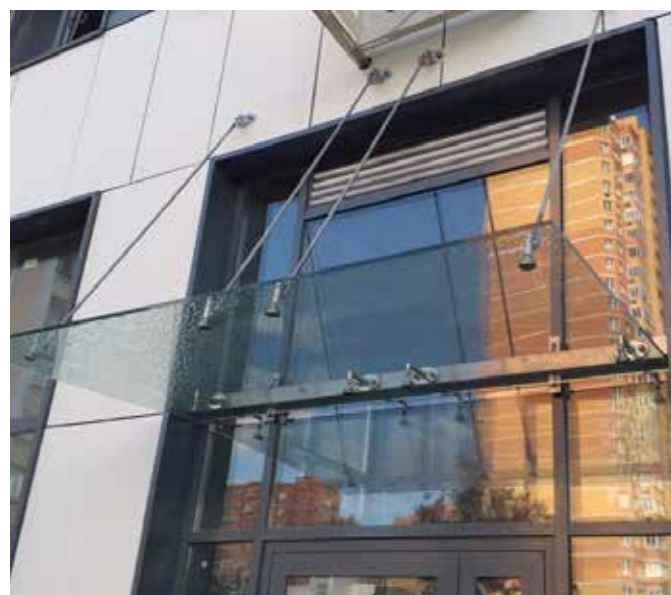
Козырек на вантовом креплении, смонтированный на закладную из нержавеющей трубы к стойкам алюминиевого фасада.
