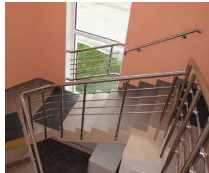
Ограждение с боковым крепежом, ригеледержателем K018 и четырьмя ригелями диаметром 16 мм.
