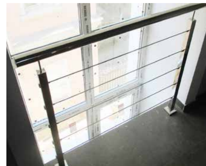
Ограждение с пятью тросами из нержавеющей стали и стойками 40x40мм, поручень круглый для удобства - очень современное решение.
