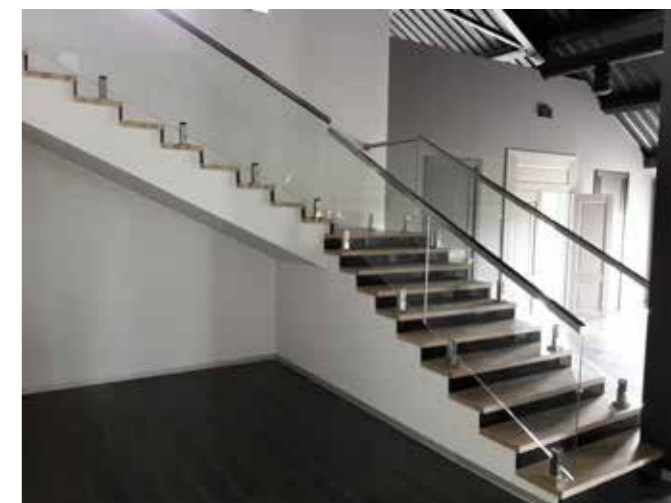
Стильные ограждения из стекла, закрепленного в мини-стойки из нержавеющей стали и профильным поручнем 60x40мм.
