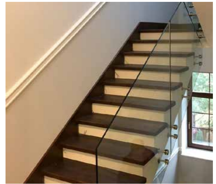
Ограждение без стоек с закаленным стеклом 12 мм без поручня, крепления стекла на дистансерах относительно марша из-за нависания ступеней.
