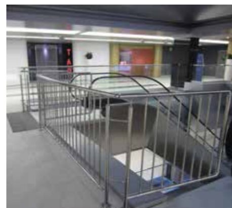
Экономичное примыкание к эскалатору. Устанавливать стойку в нишу электромоторов нельзя, поэтому консольное крепление на выносе. Стойки д. 38 мм, вертикальное заполнение ригелями 16 мм.
