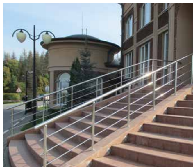
Ограждение парапета входной группы с тремя ригелями элитного частного дома. Благодаря полировке нержавейки 800GRIT конструкция ограждений растворяется в пространстве.
