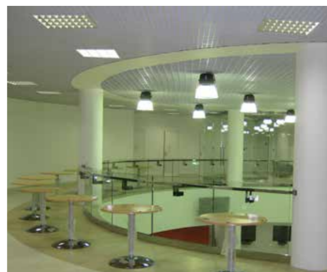
Ограждение атриума с использованием триплекса 8+8 мм, в алюминиевом профиле k601 и с поручнем 40 мм x 80 мм на выносах. Такой поручень можно использовать как полочку для сумочки или подставку под кофе.
