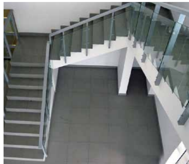
Ограждение со стойками из черного металла с покраской в RAL и пластинчатыми стеклодержателями в автосалоне.
