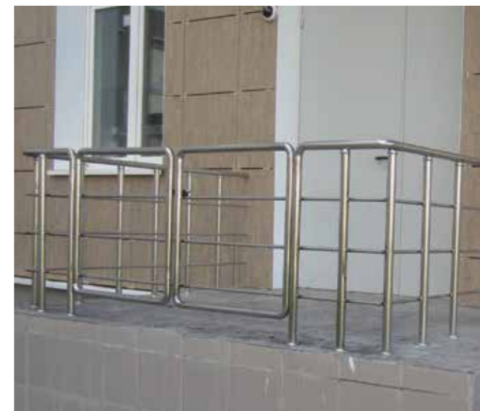
Ограждение входной группы погрузочно-разгрузочной зоны магазина. Специально оборудовано калиткой из нержавеющей стали с замком.
