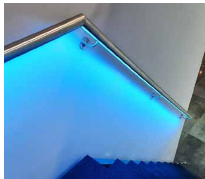
Пристенный поручень со встроенной LED-подсветкой голубого свечения, выбранного заказчиком как элемент фирменного стиля.
