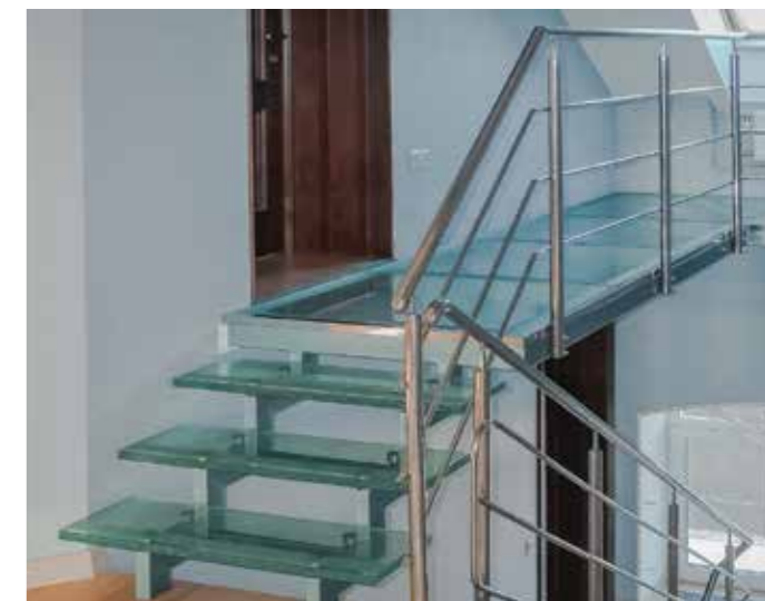
Ступени и площадка из триплекса 8+8+8 мм. Ступени приклеены на точки с помощью ультрафиолетового клея.
