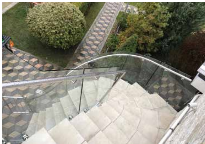
Моллированные стеклянные ограждения уличной лестницы. Чтобы не утяжелять бетонное основание лестницы использовали стекло толщиной 10 мм. Для жесткости всей конструкции установлен поручень из нержавеющей стали на выносных держателях.
