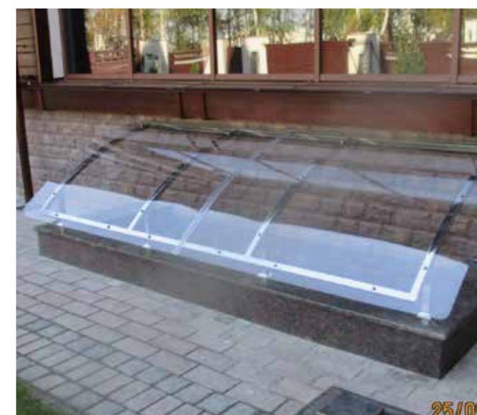
Гнутый навес прямка из прозрачного монолитного поликарбоната на каркасе из нержавеющей стали.
