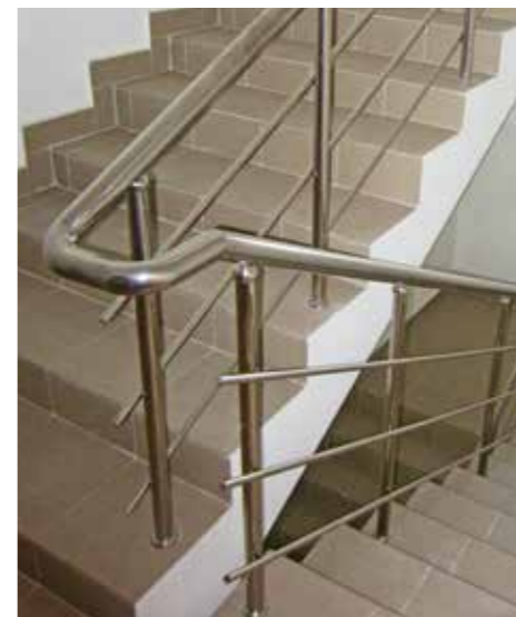
Ограждение лестницы с выходящей ступенью, из-за этого поручень выходит в горизонт на длину вылета ступени.
