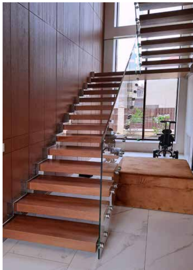
Стр. 8-9 каталога. Реализованный проект консольной маршевой лестницы с первого на второй этаж частного дома. Тон дубовых ступеней подобран под цвет декоративных облицовочных панелей. Стеклопакетные ограждения без поручня, с П-образным профилем из нержавеющей стали, установленным сверху на стекло.
