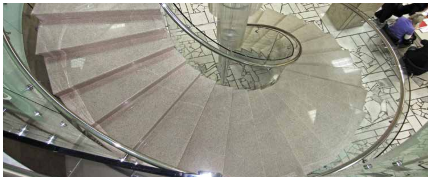
Ограждение забежной лестницы со стеклом 12 мм, гнутым по радиусу в двух плоскостях.
