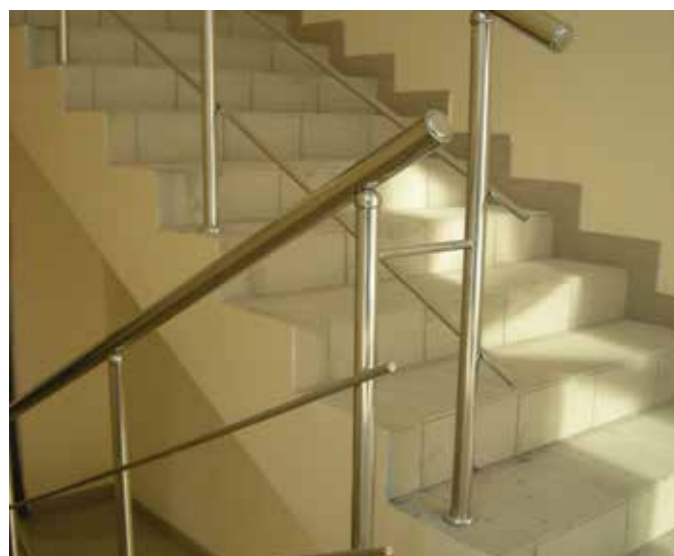
Самый экономичный вариант ограждений с 2-мя ригелями. Поручень и ригели развязаны. Для жесткости установлена перемычка между крайними стойками.
