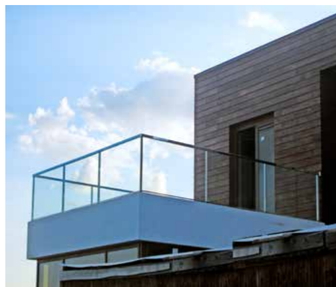
Ограждение балкона со стеклом 12мм, установленным в рамную конструкцию из нержавеющей стали.
