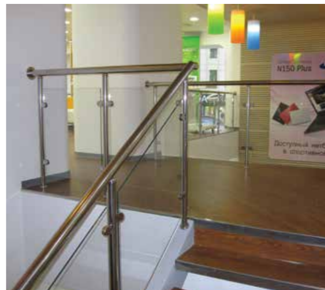
Ограждение в магазине с закаленным стеклом 8 мм и архитектурной пленкой для большей прочности на разбитие с наклонным креплением в парапет. Окончание поручня - фланец арт. k022.
