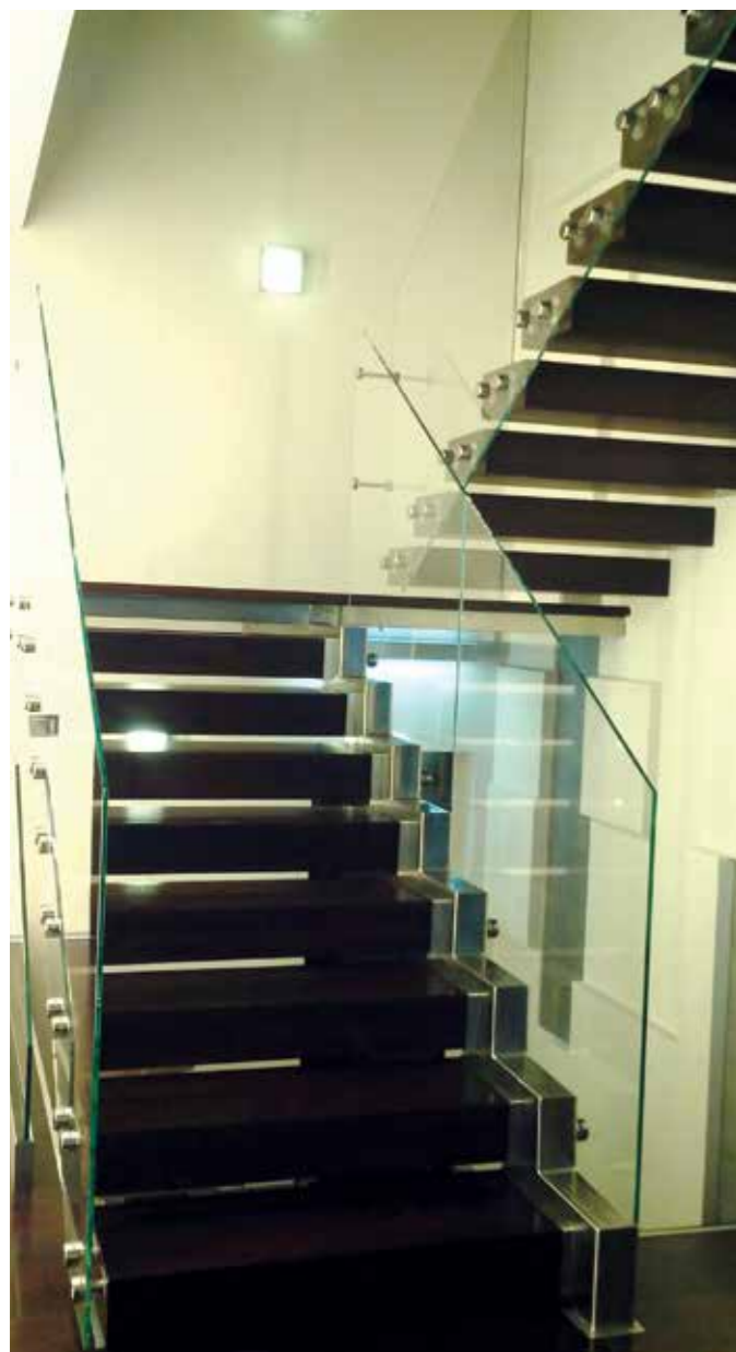
Ограждение без поручня со стеклом 12 мм, с боковым крепежом K277. Перегородки между маршами придают дополнительную жесткость.
