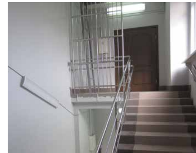
Ограждение площадки лестницы в здании управы. Дополнительный детский поручень на высоте 700 мм.
