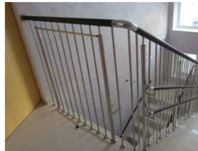
Ригельное ограждение элитного детского сада высотой 1500 мм с тремя круглыми деревянными поручнями, крашеными под венге и завязанными нержавеющей сталью отводами. Поручни установлены на выносах k243.
