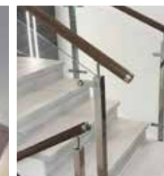
Деревянный поручень не завязан. Жесткость придается перемычками
