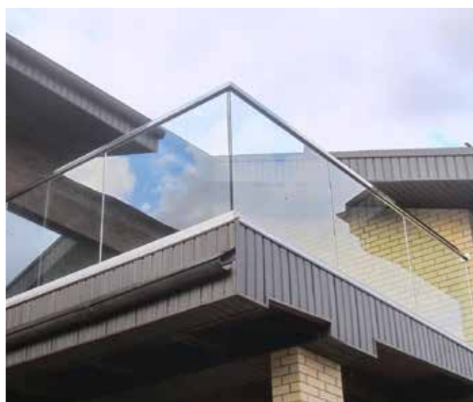
Угловая терраса и ограждения из стекла в зажимном алюминиевом профиле, поручень труба нержавеющая 60x40мм с пазом под установку на стекле.
