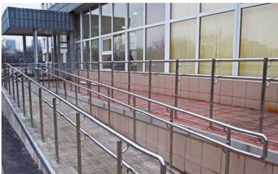
Вариант исполнения ограждений №2: поручни на высоте 900 мм сверху на стойке, поручень 700 мм на выносе относительно стойки.
