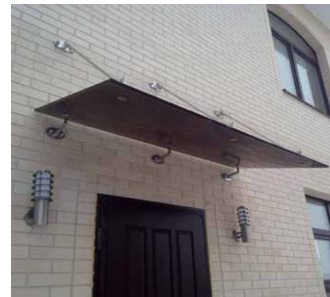
Козырек в частном доме на вантах с затонированным стеклом триплекс 8+8 мм.
