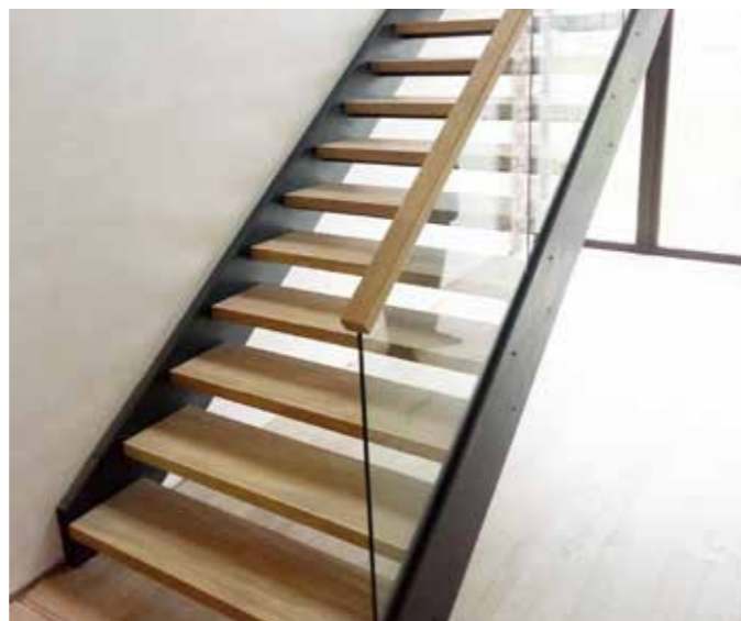
Несущее стекло с профильным дубовым поручнем с пазом. Крепление в торец лестницы скрыто декоративными накладками.
