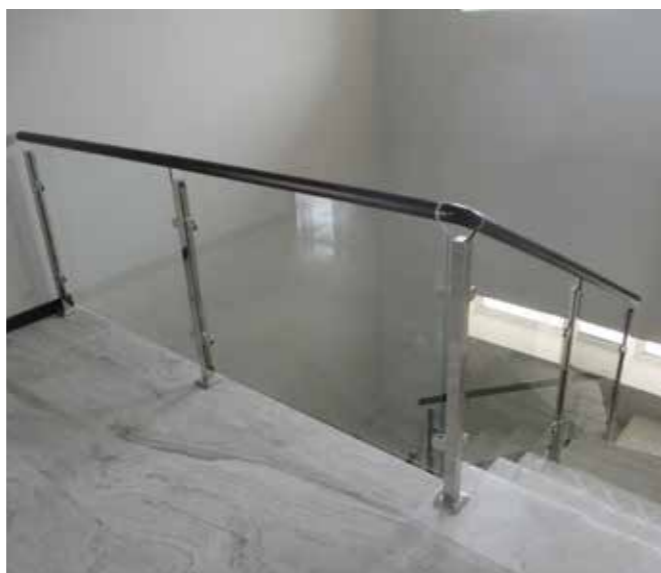
Ограждения лестницы на квадратных стойках 40x40 мм, деревянный поручень с пазом установлен сверху на стекло и непрерывен на повороте.
