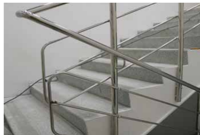
Боковой крепеж трехригельного ограждения в условиях отсутствия пролета между маршами. Поручень на наконечнике сфера k016 сверху и на выносе, крепится к той же стойке чуть ниже по пути на нижний марш. Ригели завязаны травмобезопасно и крепятся к одной и той же стойке с разных сторон.
