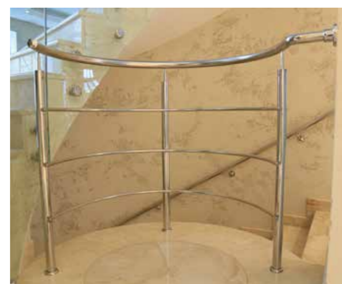
Трехригельное ограждение без ригеледержателей, прокатанное по радиусу. Ригели оканчиваются сразу после стойки без вылета, круглый поручень диаметром 38 мм оканчивается во фланец k026 с закрытым крепежом.
