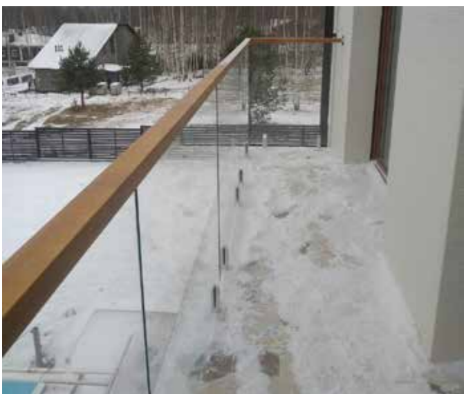
Ограждение из стекла закаленного марки М1 12мм на министойках из нержавеющей стали и поручнем из лиственницы 40x60мм.
