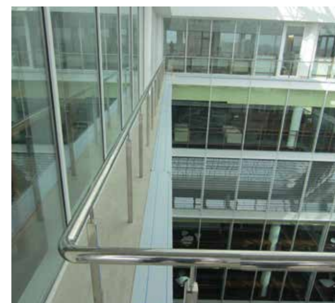
Техническое ограждение атриума вдоль стеклянных перегородок. Квадратные стойки 40x40 мм в стиле квадратных стоек алюминиевых перегородок, круглый поручень 50 мм, завязан на поворотах.
