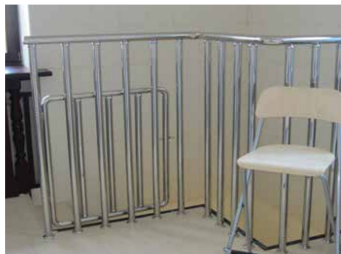
Ограждение детского этажа в коттедже. Оборудовано вертикальным заполнением - стойками д.38 мм и калиткой по чертежам заказчика.
