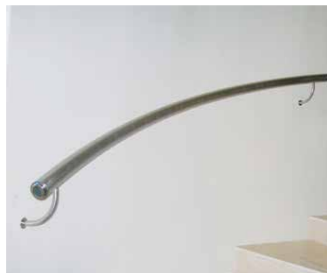
Пристенный поручень прокатанный по радиусу, дублирует изгиб стены.
