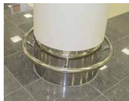
Колесоотбойник вокруг колонны (защищает облицовку от тележек).
