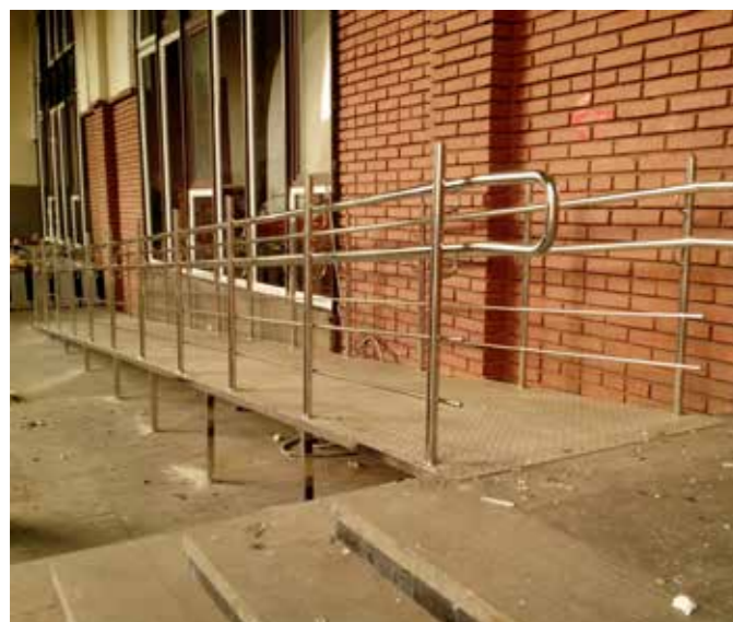
Каркас пандуса из нержавеющей трубы профильного сечения, покрытие нержавеющей текстурированный лист, стойки ограждения приварены к каркасу.
