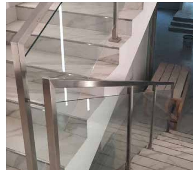
Эксклюзивный проект ограждения. Стекло крепится в специальные пазы, сделанные в стойках из нержавеющей шлифованной стали через уплотнители.
