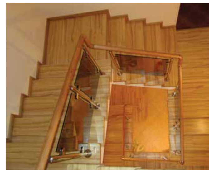
Колодезная лестница с деревянным поручнем и ограждением на зажимных стеклодержателях со стеклом цвета бронза.
