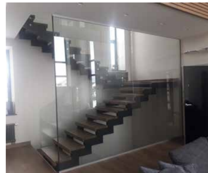
Стеклянная перегородка от пола до потолка в данном случае решает вопрос безопасности при передвижении не только по лестнице, но и внутри на этаже частного дома.
