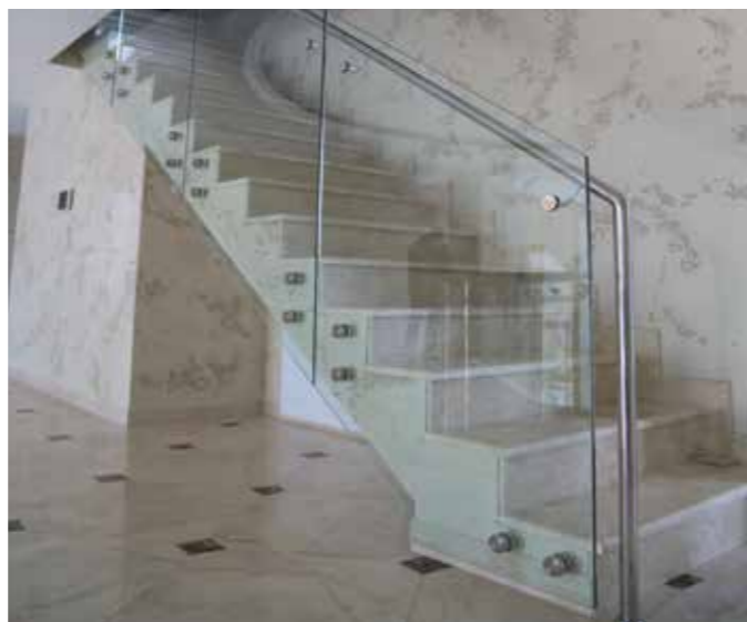
Ограждение без стоек с открытыми обработанными кромками стекла. Круглый поручень из нержавеющей стали Ф50мм уходит в пол дополнительно укрепляя конструкцию.
