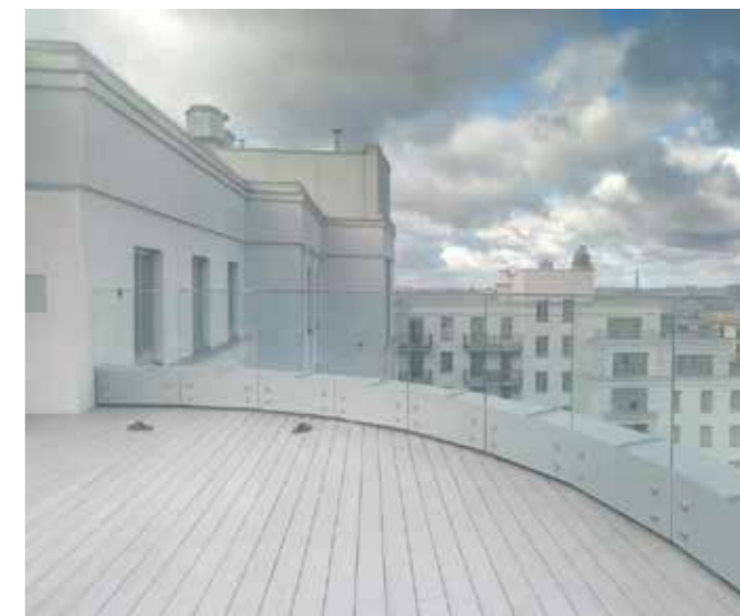
Ограждение видовой террасы с креплением несущего стекла в точках в парапет через металлический отлив, сверху на стекло установлен П-профиль из нержавеющей стали.
