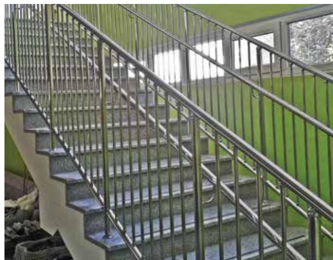
Ограждение в старшей школе. Выполнено с двумя поручнями д.38 мм на высоте 900 мм и 1200 мм. Вертикальные ригеля опираются на нижнюю балку д.38 мм с помощью деталей к212.
