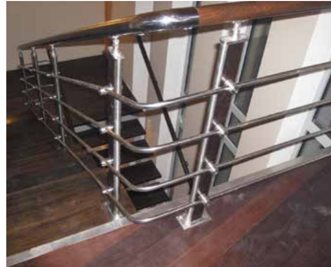
Стойки с деревянной вставкой "махагон" с четырьмя ригелями и завязками на поворотах. Поручень деревянный завязан на повороте нержавеющей.
