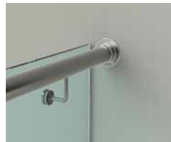
Крепление круглого поручня 50мм в стену через фланец k094 или k022
