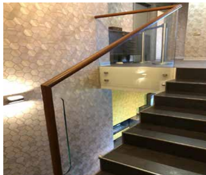
Цельностеклянные ограждения с непрерывным деревянным поручнем. Сделан вырез в стекле для удобства при движении по лестнице.
