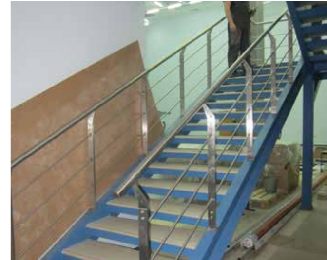
Дорогие, нестандартные, пластинчатые стойки с небольшим выносом поручня внутрь марша для удобства ходьбы. Три ригеля диаметром 16 мм сквозь стойку.
