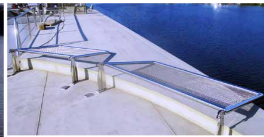
Откидные ограждения вертолетной площадки. Секции из полированной нержавеющей стали Ф42х2 мм, заполнение секции тканая сетка. Стойки в местах крепления к палубе снабжены стопроно-откидным механизмом, который позволят фиксировать ограждение в 3-х положениях.
