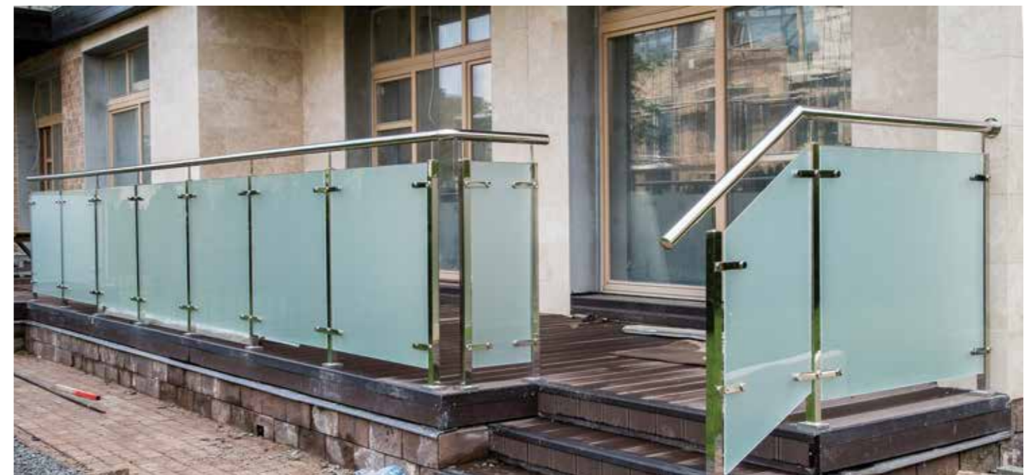
Входная группа совмещенная с балконом первого этажа. Ограждения со стойками 40x40 мм, круглым поручнем д. 50,8 мм, пластинчатыми стеклодержателями и матовым в массе стеклом, благодаря которому с внутренней стороны балкона крепление стекла практически не видно.
