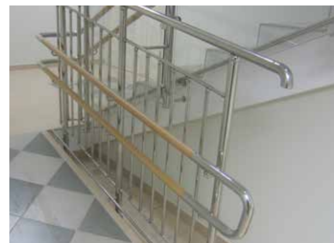
Нижний поручень детских ограждений завязан элементом из нержавеющей стали k051, разработанным специально для подобного вида ограждений, верхний поручень оканчивается отводом k067, чтобы никто не зацепился за выступающую часть поручня.
