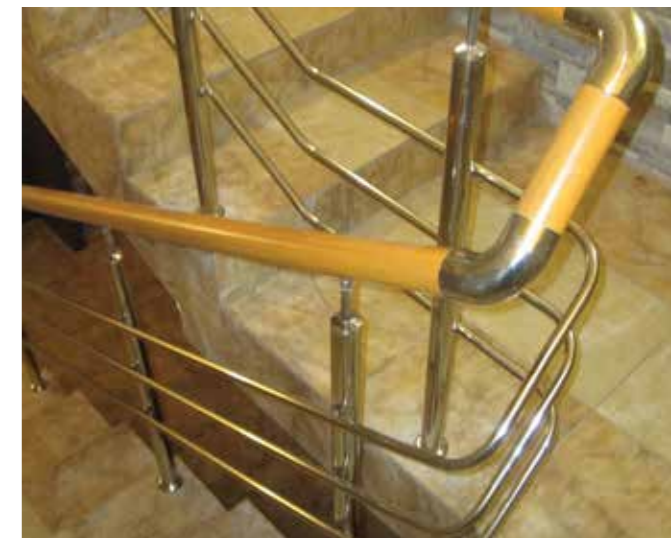
Ограждение с забегом площадки на верхний марш на 900 мм и выбогом нижнего марша на 2 ступени. Завязка круглого пластикового поручня и ригелей на повороте нержавеющей наискосок для компенсации перепада высоты в 2 ступени.
