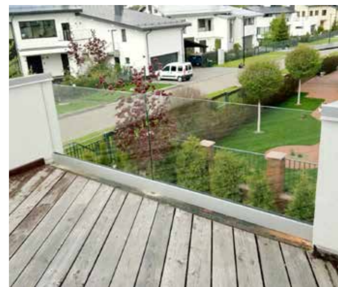
Сохранен красивый вид с террасы благодаря тому, что пространство между парапетами заполнено стеклянными ограждениями в несущем алюминиевом профиле.
