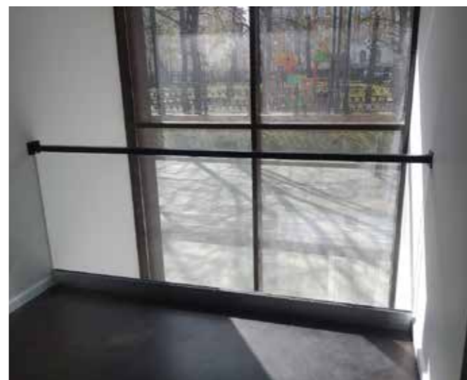
Ограждение окна из стекла 10мм в несущем алюминиевом профиле с крашеным поручнем, установлено в край площадки.
