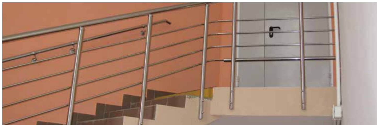
Марш слева развернут по отношению к площадке на 120 градусов, этим обусловлена сложная завязка поручня в трех плоскостях. Внизу ригель д. 16 мм переходит в трубу д. 38 мм, так как заказчик любит стоя на балконе курить и ставить ногу на первый ригель лестничного ограждения. Дублирующий пристенный поручень позволяет организовать безопасное движение в обе стороны одновременно.
