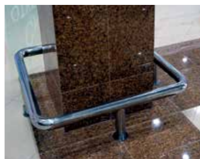
Колесоотбойники вокруг квадратной колонны, все завязано.
