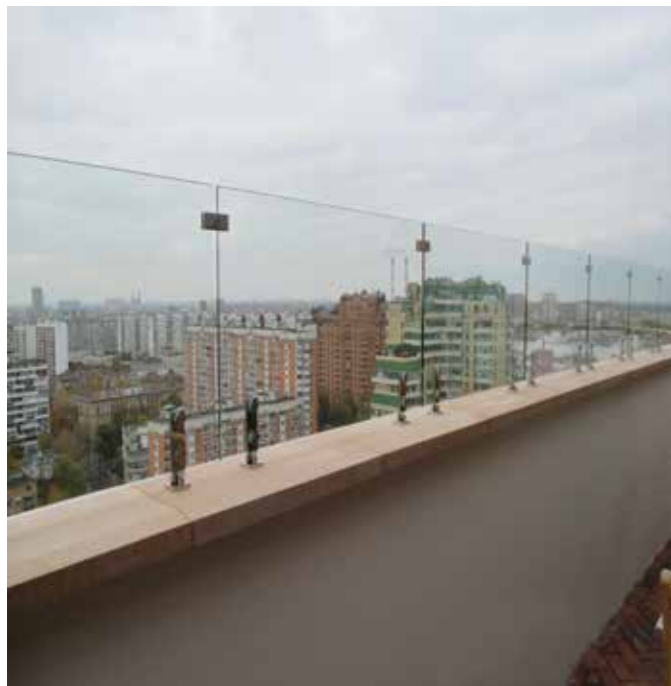
Ветрозащитное ограждение балкона с креплением сверху в парапетную крышку с помощью мини-стоек k276.
