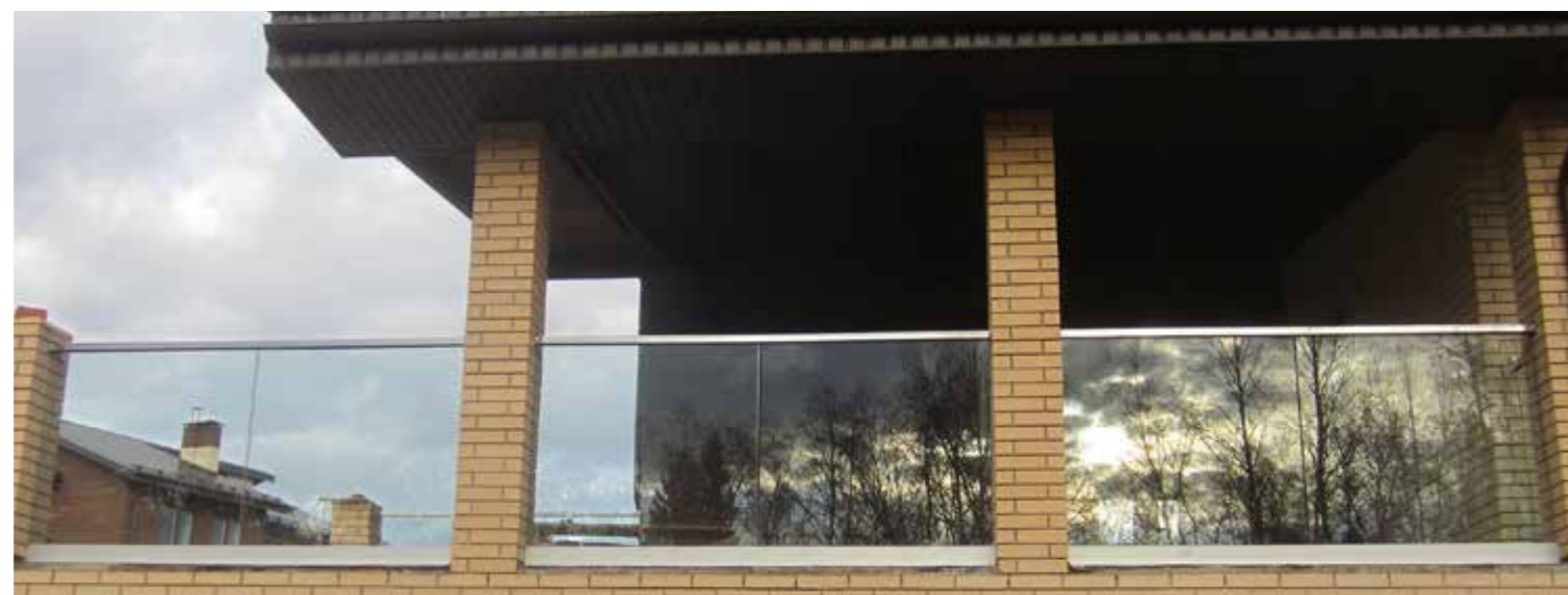
Классическое ограждение террасы из стекла в зажимном алюминиевом профиле. Поручень профильный 40x60мм установлен сверху на стекло через паз, закреплен к несущим колоннам дома для придания жесткости всей конструкции.
