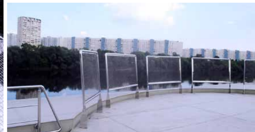
Откидные ограждения вертолетной площадки. Секции из полированной нержавеющей стали Ф42х2 мм, заполнение секции тканая сетка. Стойки в местах крепления к палубе снабжены стопроно-откидным механизмом, который позволят фиксировать ограждение в 3-х положениях.
