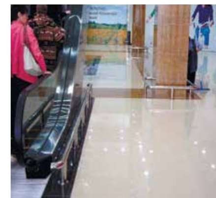
Отбойник защищает отделку эскалатора и колонны.
