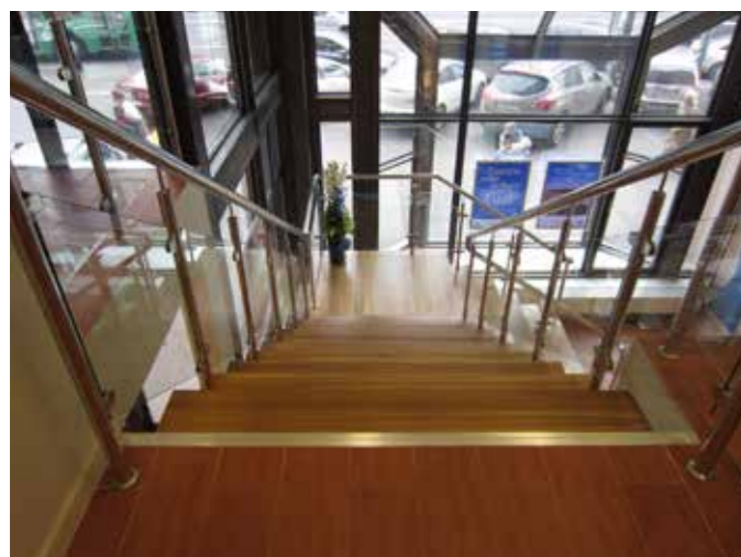
Ограждение со стеклом 8 мм с минимальным заполнением просвета между стойками стеклянным полотном. Левая линия выполняет функцию ограждения панорамного окна.
