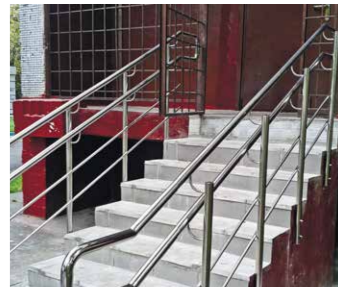
Ограждение лестницы с торцевым креплением для сохранения максимальной полезной ширины лестничного марша. Дополнительный поручень на высоте 700 мм.
