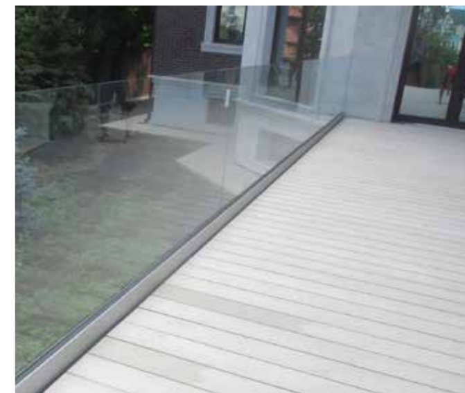
Минималистичное ограждение террасы в зажимном алюминиевом профиле без поручня, Стекло триплекс 8+8мм для обеспечения жесткости.
