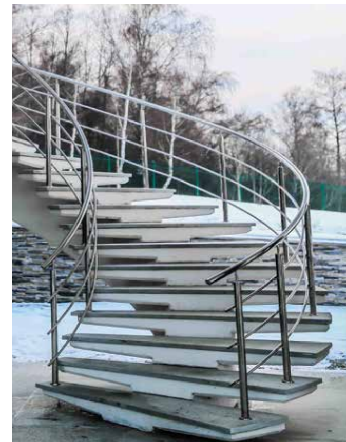
Уличное трехригельное ограждение забежной лестницы. Стойки диаметром 50 мм, наконечник K042.
