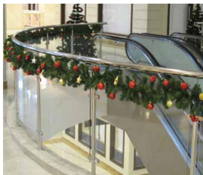
Ограждение круглого атриума: закаленное стекло толщиной 8 мм на зажимных стеклодержателях k038, наконечник k006, малая крышка k015.
