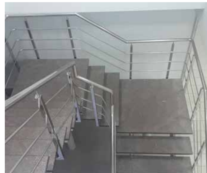
Ограждение колодезной лестницы с завязкой поручня, ригелей на поворотах. Крепление стоек сверху в ступень.
