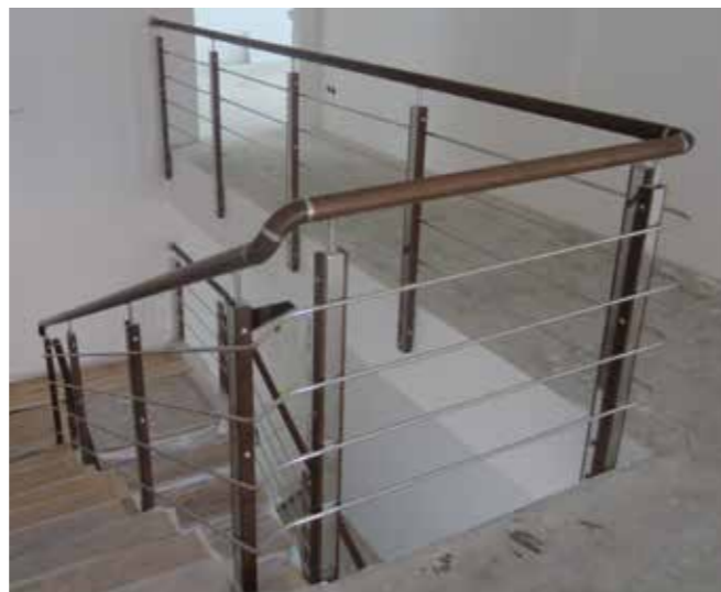
Поворот на 90 градусов при использовании бокового крепежа почти всегда сопровождается "горбылем" на поручне, для сохранения одинаковой высоты на марше и на балконе. Если бы стойки стояли на марше, то поручень завязался бы идеально. Деревянный поручень с соединительными кольцами.
