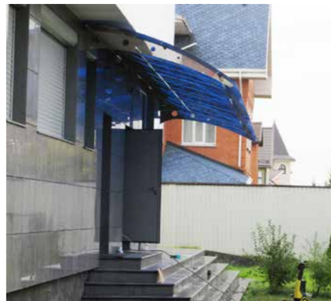
Козырек 3 x 1,5 метра на консолях с подконструкцией из нержавеющей стали накрытый синим монолитным поликарбонатом.
