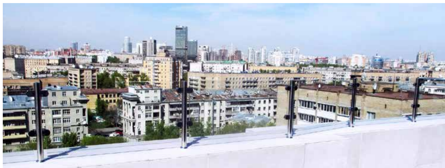
Ограждение эксплуатируемой кровли многоквартирного дома с креплением сверху в бетонный парапет. Нижняя кромка стекла имеет минимальный зазор относительно парапета для лучшей ветрозащиты.
