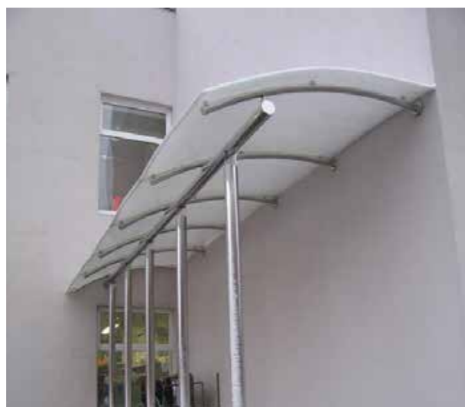
Навес над входом в подвал. Каркас из нержавеющей стали накрыт монолитным поликарбонатом молочного цвета.
