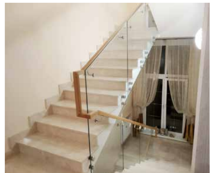
Ломаный дубовый профильный поручень, установленный на выносных элементах стеклянных ограждений.
