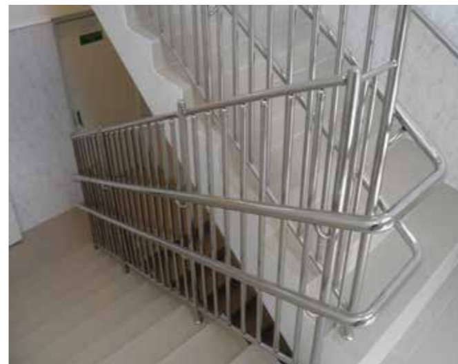
Ограждение в школе с маленьким межмаршевым расстоянием. Выполнено с тремя поручнями д.38 мм на высоте 500 мм, 900 мм и 1500 мм. Вертикальные ригели опираются на нижнюю балку д.25 с помощью деталей к212. Стойки завязаны между собой одной перемычкой.
