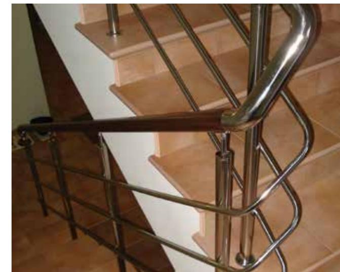
"Кошмар монтажника": завязка деревянного поручня нержавеющей трубой на узком марше с двумя забежными ступенями наискосок для сохранения одинаковой высоты на обоих маршах.
