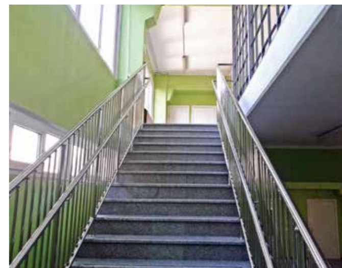
Ограждение в муниципальном учреждении, оборудованное дополнительным поручнем для детей 6-10 лет на высоте 700 мм. Верхний поручень установлен сверху, а нижний на выносе.
