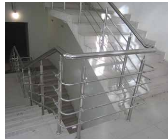
Ограждение лестницы с четырьмя ригелями. Ригели крепятся с помощью ригеледержателя k018. Межмаршевое расстояние 1 метр, площадка забегает на оба марша на длину одной ступени, поэтому 2 выхода в горизонт по 300 мм.
