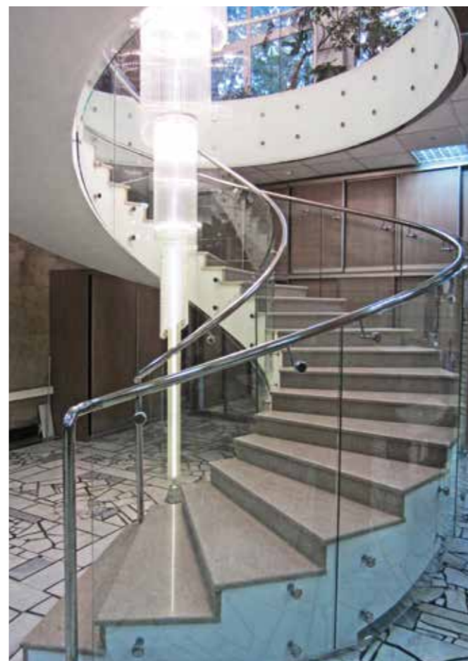
Ограждение в отделении банка, без стоек с боковым креплением и выносами поручня внутрь марша. Для жесткости окончание поручня уходит в пол. Стекло 12 мм гнутое по радиусу, выносы K241, точечные крепежи K277.
