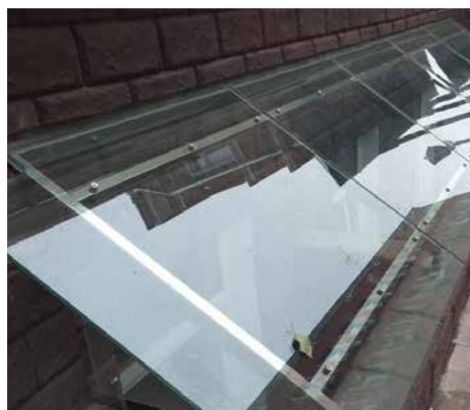
Простейший навес прямка: каркас из нержавеющей стали накрыт монолитным поликарбонатом.
