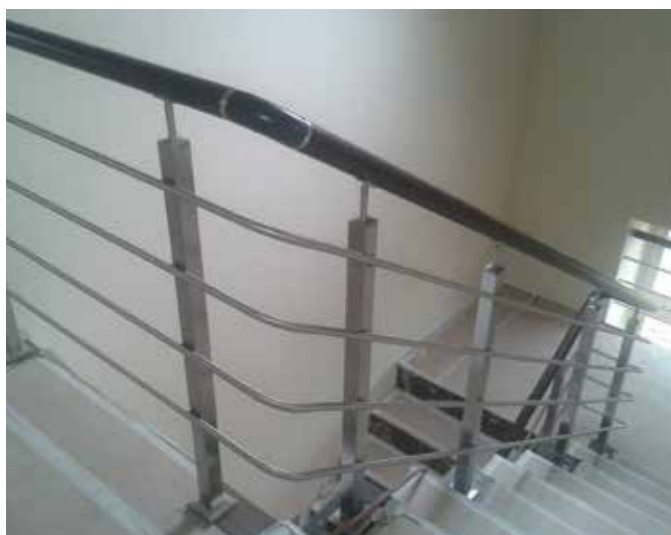
Чистовые полы укрыты картоном до начала монтажа четырехригельного ограждения на квадратных стойках 40 x 40 мм. Крышка k076, наконечник k239. Ригели приварены внахлест со стойкой завязаны между маршей.
