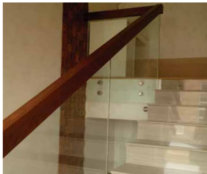
Массивный деревянный поручень установленный сверху на ограждение из стекла без стоек.
