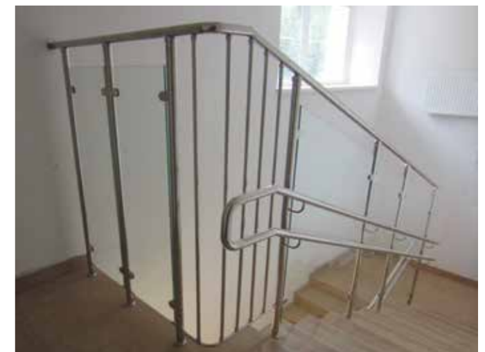
Ограждение средней школы высотой 1500 мм с безопасным стеклом триплекс 4+4 мм и двумя поручнями д.38 мм на выносах от стойки на высоте 900 и 700 мм. Наконечник k016, стеклодержатели k001, крепление сверху в ступень с маленькой крышкой k015. Поручень завязан травмобезопасно отводом k051.
