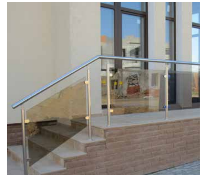
Ограждение входной группы с бронзовым в массе стеклом, сочетающимся по цвету с оконным профилем.
