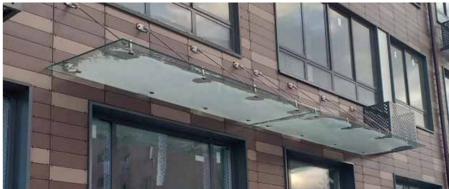
Козырек на вантах из монолитного поликарбоната толщиной 8 мм, смонтирован на закладные к стене вентилируемого фасада.
