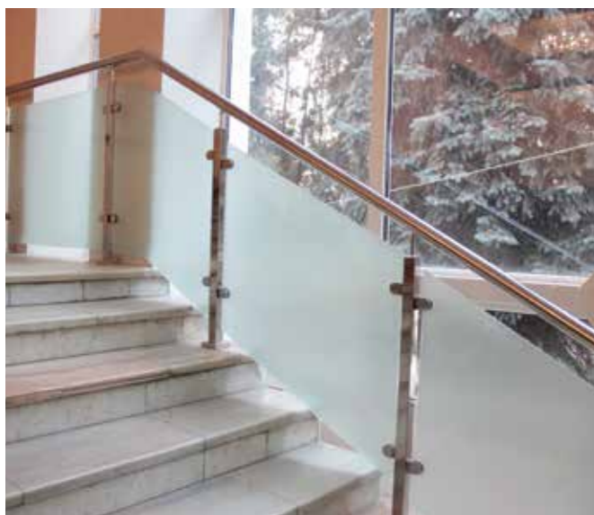
Ограждения лестницы на квадратных стойках 40x40 мм, крышка стойки k076. Стекло оклеено матовой пленкой. Стекло сложной формы на переходе на площадку.
