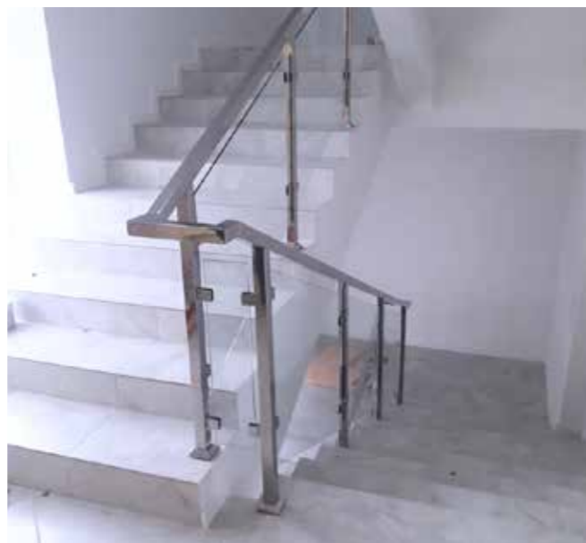
Ограждение со стеклом 8 мм, матовое со средним заполнением просвета между стойками стеклянным полотном. Наконечник стойки сфера k017, крепление стойки сверху в ступень с крышкой среднего размера k043.
