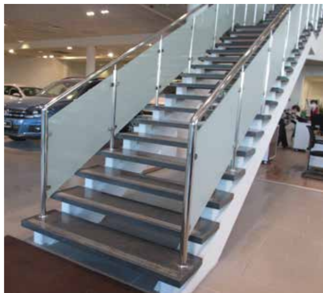
Ограждение со стеклом 8 мм и матовой непрозрачной белой пленкой. Поручень уходит в пол для жесткости, одновременно являясь крайней стоекой ограждений.
