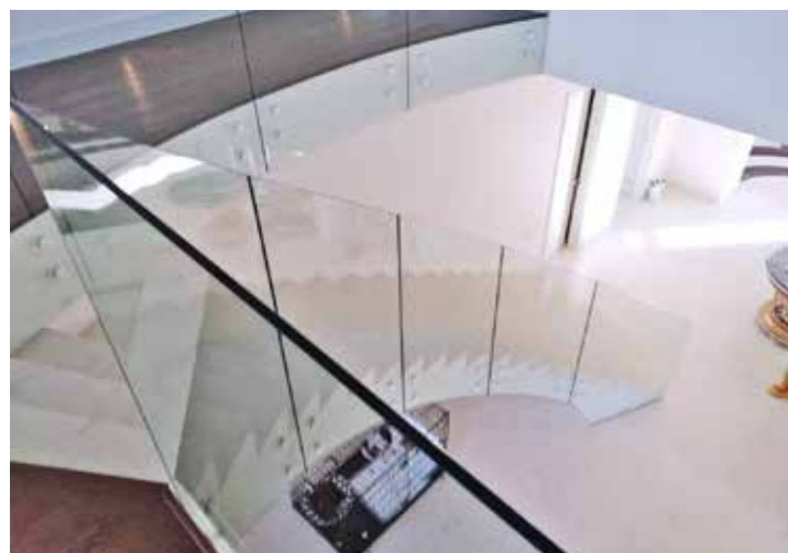
Идеальная точно выверенная геометрия стеклянных моллированных ограждений лестницы без поручня. Крепления стекол покрашены в тон торца лестницы и второго света жилого дома.
