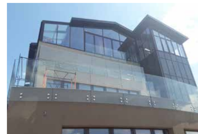
Ограждение террас многоуровневого коттеджа из закаленного стекла 12мм с креплением в торец парапета для сохранения полезной площади.
