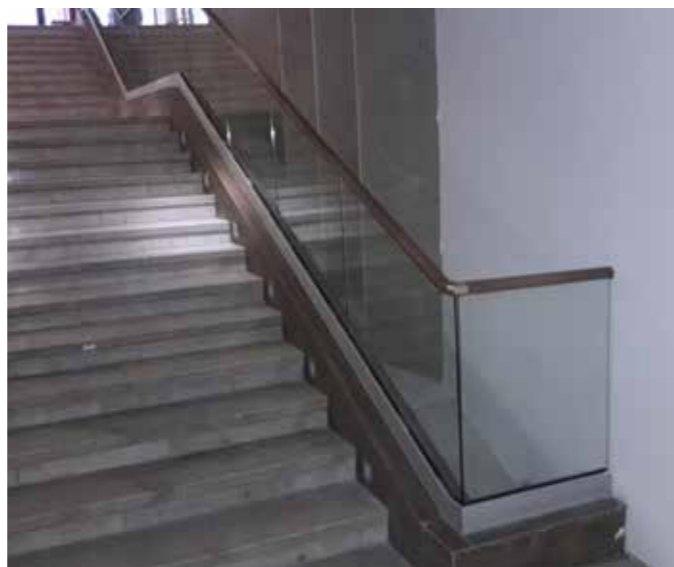
Профиль для стеклянных полотен смонтирован в основании парапета лестницы как на прямых, так и на наклонных участках.
