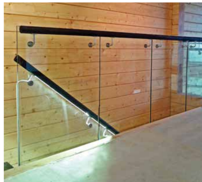
Освещение ступеней лестницы и балкона. LED лента встроена в деревянный поручень.
