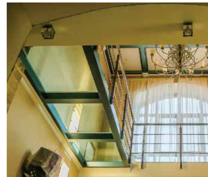
Снизу стеклнного пола проходит массивная подконструкция. При кажущейся хрупкости стеклнные полы очень мощные. Обычно их проектируют с расчетом на нагрузки от 500 кг/кв.м. и выше.
