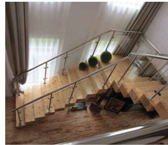
Ограждение со стеклом 8 мм на зажимных стеклодержателях K039, большие крышки K201 прикрывают треханкерные закладные K232.
